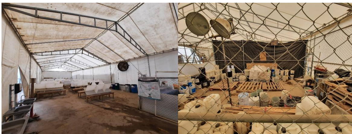
Ilustración 12. Comedor de obra y bodegas como obras provisionales. Fueron retiradas una vez cumplieron su función. Fotografía tomada por Fernando Jimenez, abril 2022
