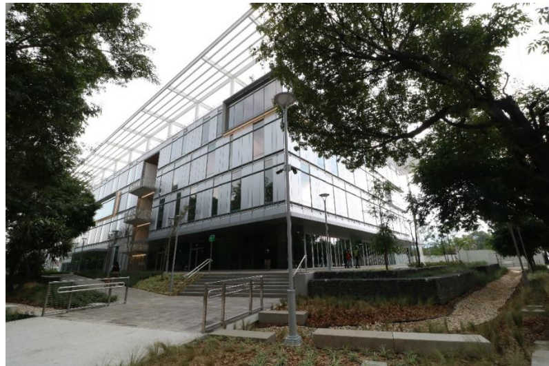
Ilustración 6. Edificio Aulas 2 (Preparatoria), fotografía tomada por Fernando Jiménez, 2021
