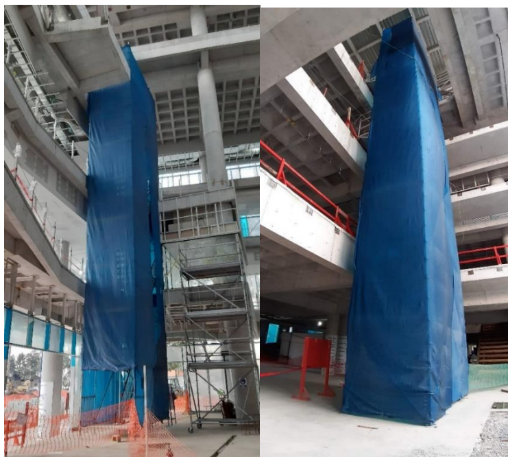
Ilustración 11. Escalera de andamios en edificio de Biblioteca y Profesional, respectivamente, cubierta con malasombra azul para protección de objetos que pudieran caer de distintas alturas. Fotografía tomada por Fernando Jiménez, agosto 2020.
