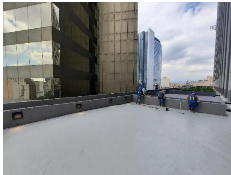
Ilustración 22. Terraza con el sistema Puma aplicado. Fotografía tomada por Fernando Jiménez, 2022.
