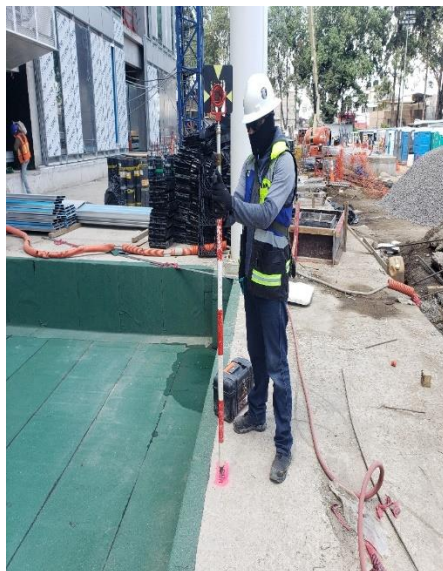
Ilustración 10. Obtención de Nivel de Piso Terminado (NPT) a través de la topografía. Fotografía tomada por Fernando Jiménez, febrero 2022
