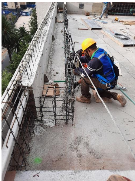
Ilustración 20. Colocación de instalación eléctrica dentro del armado de la jardinera, fotografía tomada por Fernando Jiménez, 2022.
