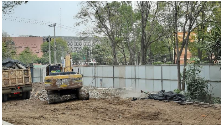
Ilustración 13. Camión de volteo del sindicato siendo cargado de cascajo para su disposición en tiro oficial. Fotografía tomada por Fernando Jiménez, junio 2021
