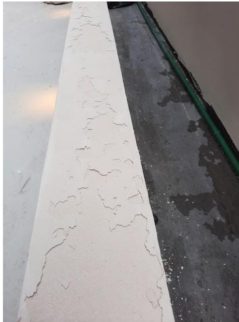
Ilustración 24. Aplicación de Coverplast afectado por el efecto de la lluvia. Fotografía tomada por Fernando Jimenez enero 2023
