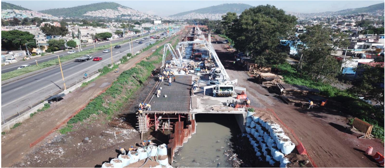
Imagen 14: Colado del encajonamiento Río de los Remedios con módulos de 27 m.
