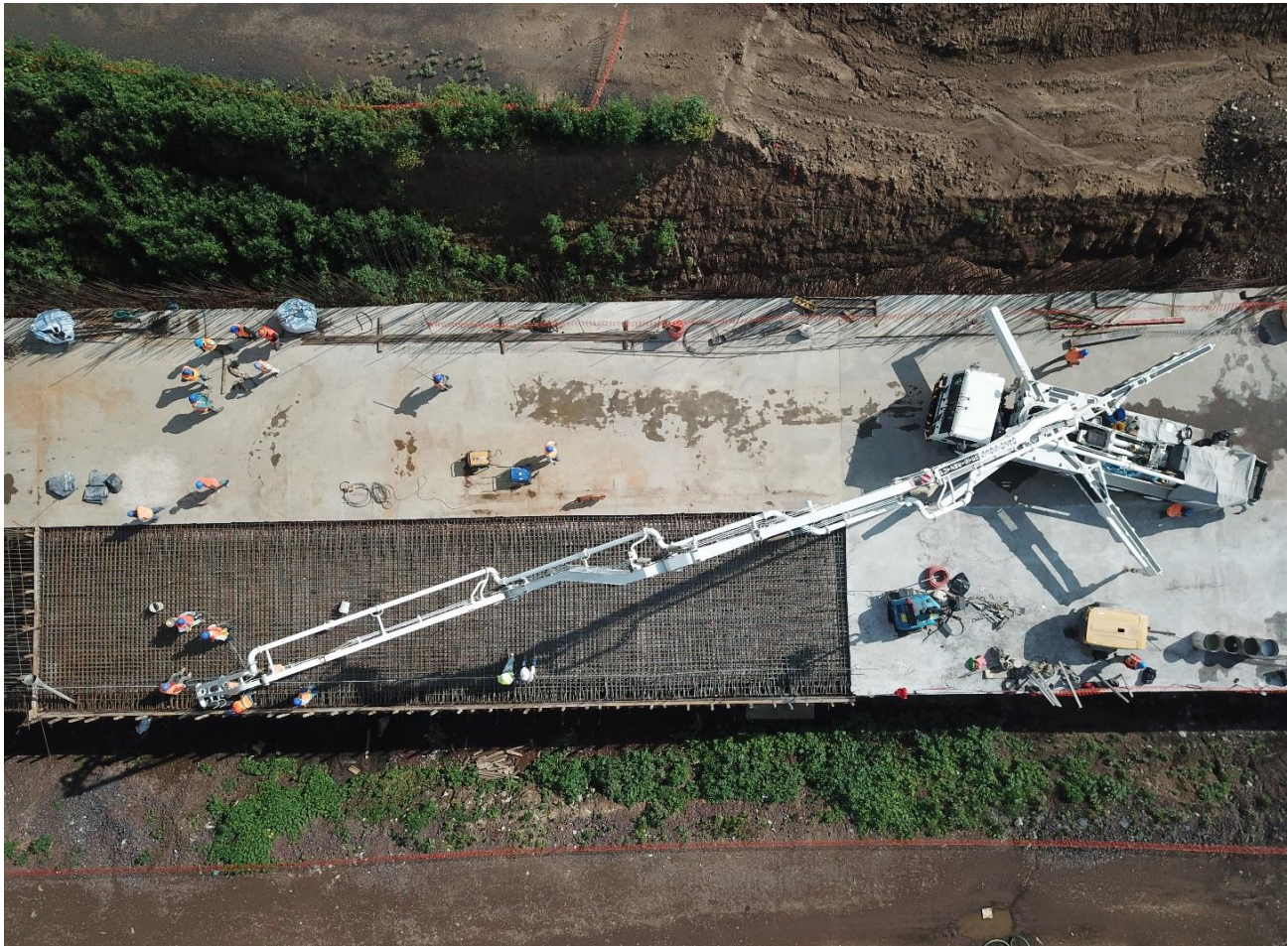
Imagen 43: Colado de segunda fase, losa tapa con bomba pluma km 1+900.
