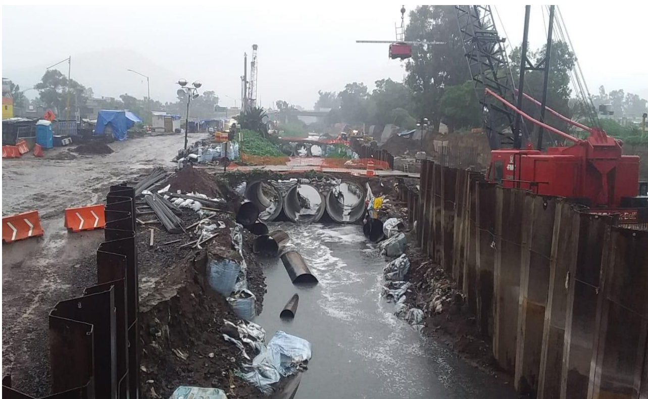
Imagen 29: Pasos provisionales con tubos de concreto para tránsito de maquinaria y peatonal.
