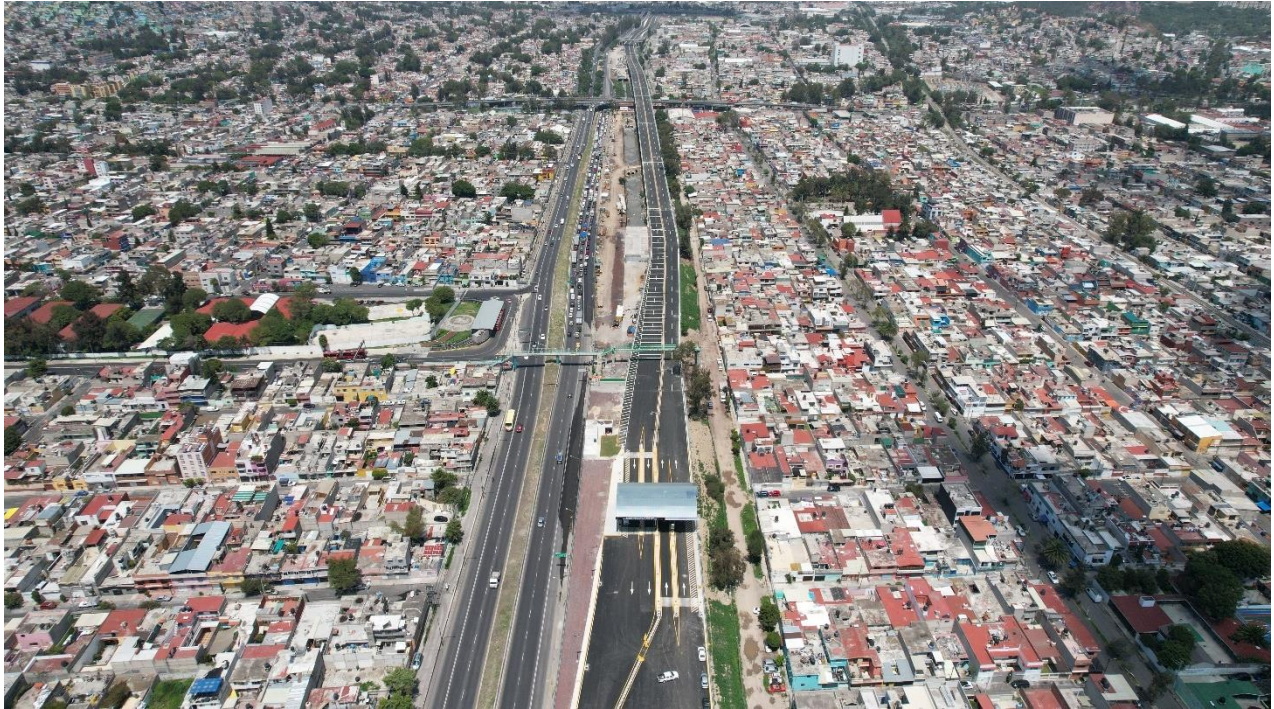
Imagen 70: Autopista Macrolibramiento Mexiquense subtramo 4.1
