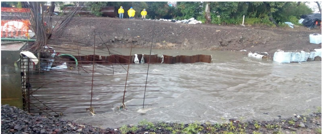
Imagen 12: Lluvias intensas presentadas en Río de los Remedios durante su construcción.
