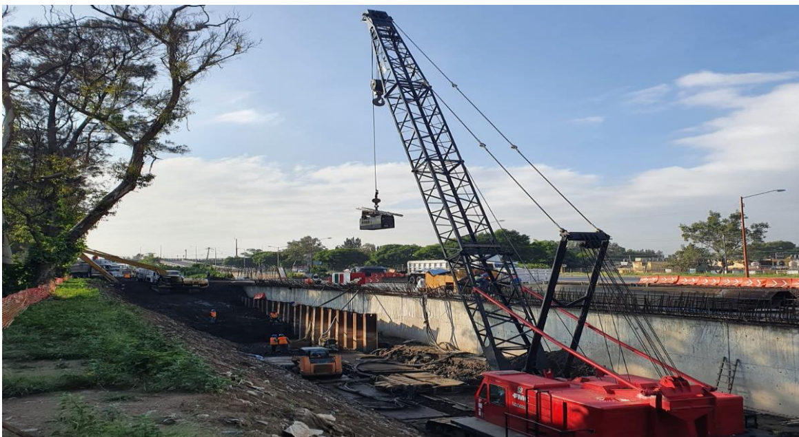
Imagen 6: Grúa Link Belt utilizada para tablestacado.
