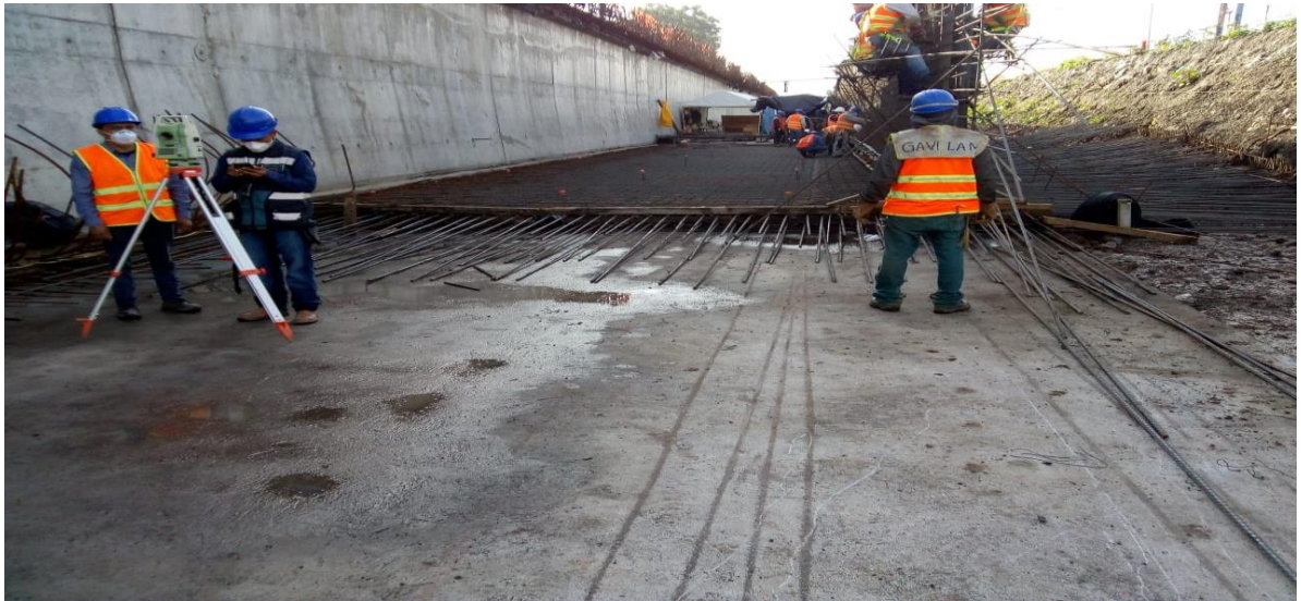
Imagen 25: Trazo topográfico para el dren de agua negra.
