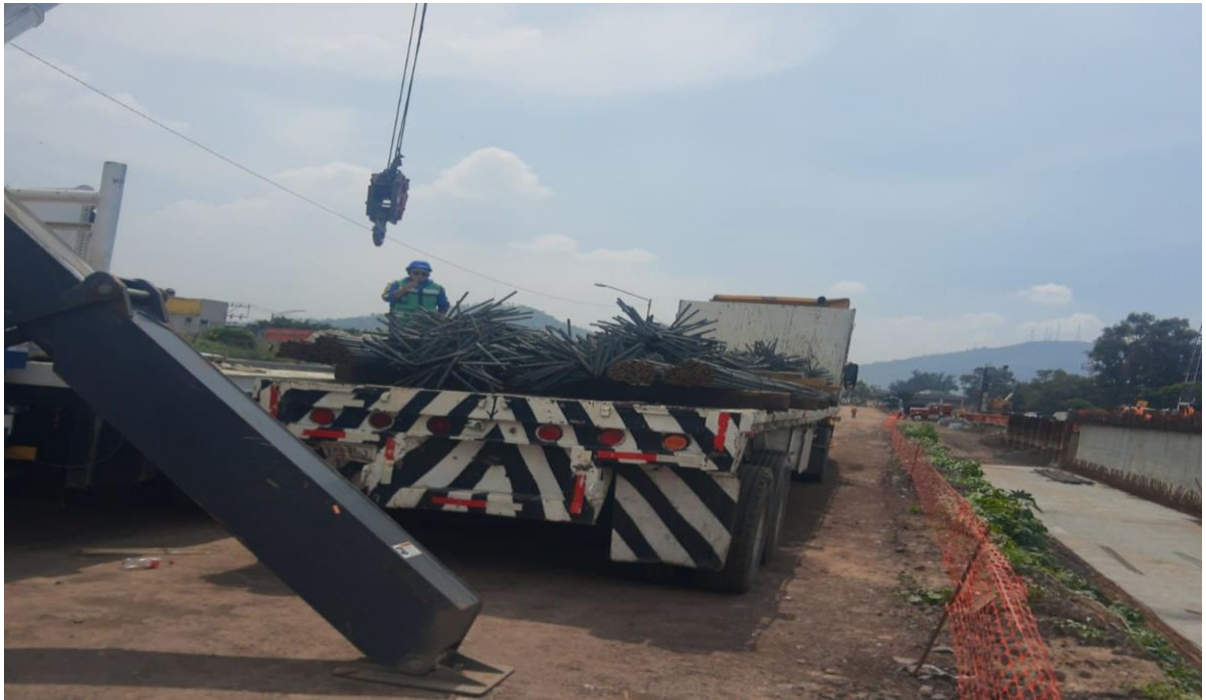
Imagen 40: Llegada habilitado de acero para el dren de aguas negras.
