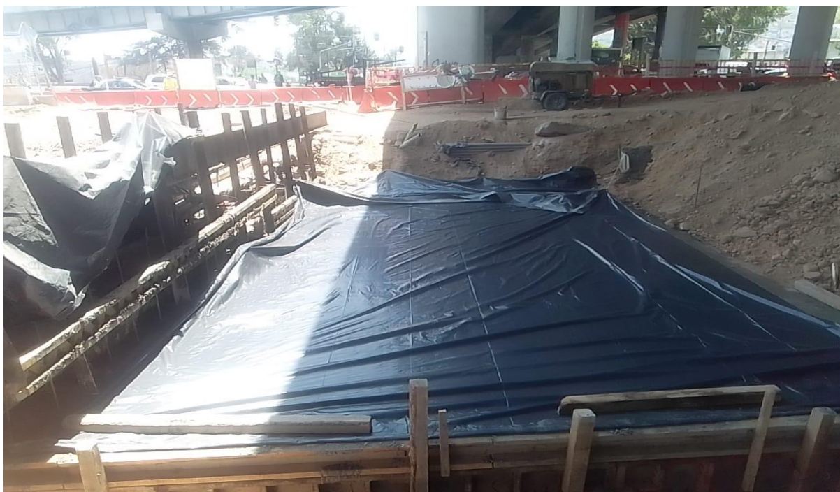
Imagen 45: Losa tapado con hule negro de polietileno para evitar perdida de agua.
