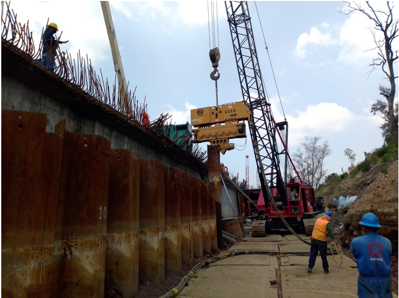
Imagen 31: Grúa link belt con vibrohincador para hincado de tablestaca.
