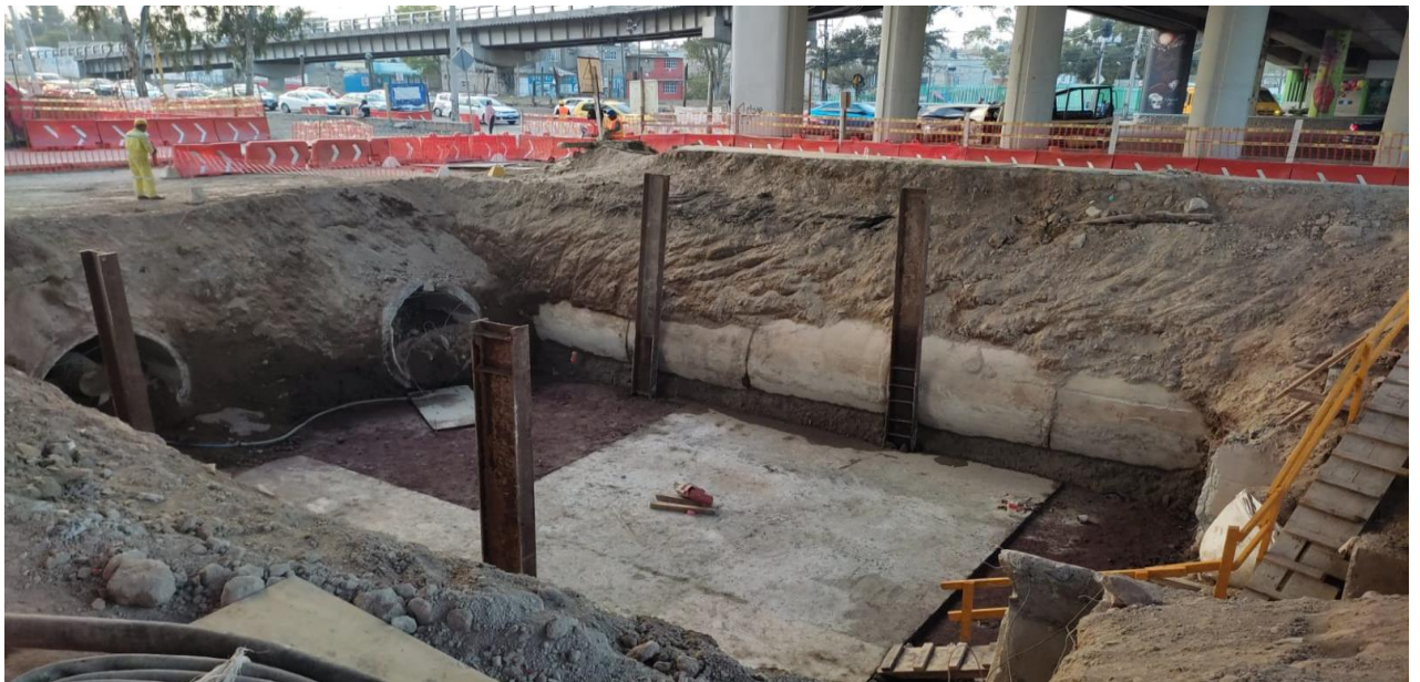
Imagen 41: Plantilla de concreto para dren de agua negras bajo Centenario km 1+200.
