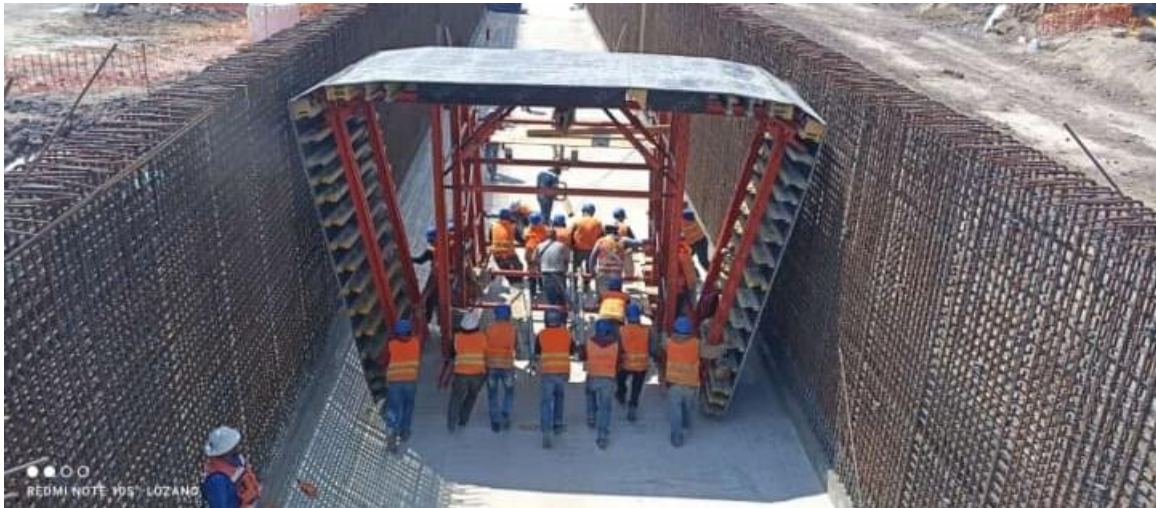
Imagen 50: Deslizamiento de módulos de cimbra para colado del siguiente cuerpo.
