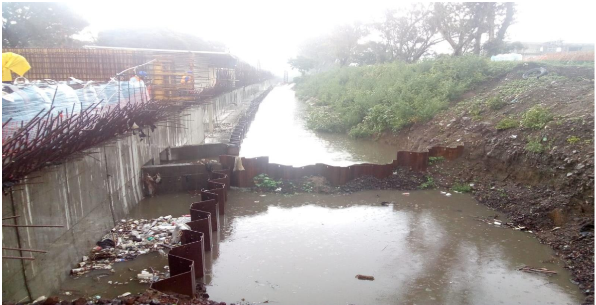
Imagen 52: Sistema muro-tablestacado para desvío del cauce.
