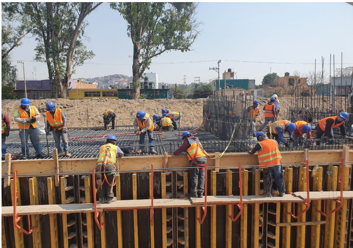
Imagen 53: Uso de EPP durante la ejecución de los trabajos.
