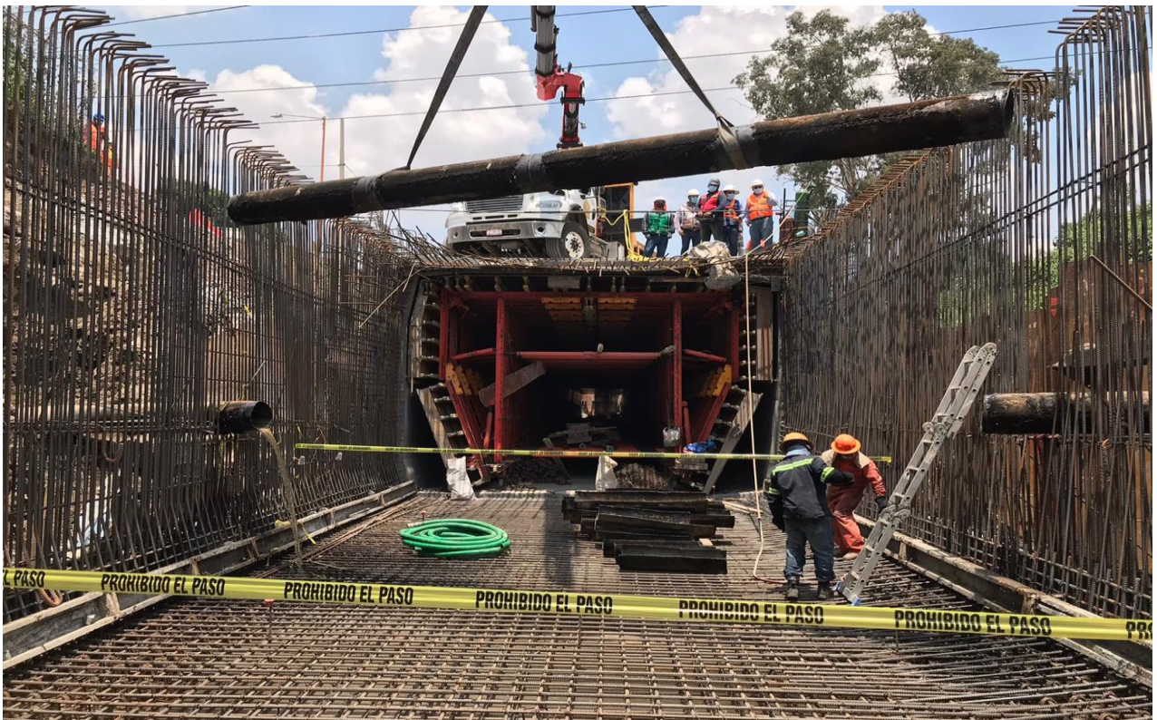
Imagen 47: Armado de cimbra deslizante para el dren de aguas negras.
