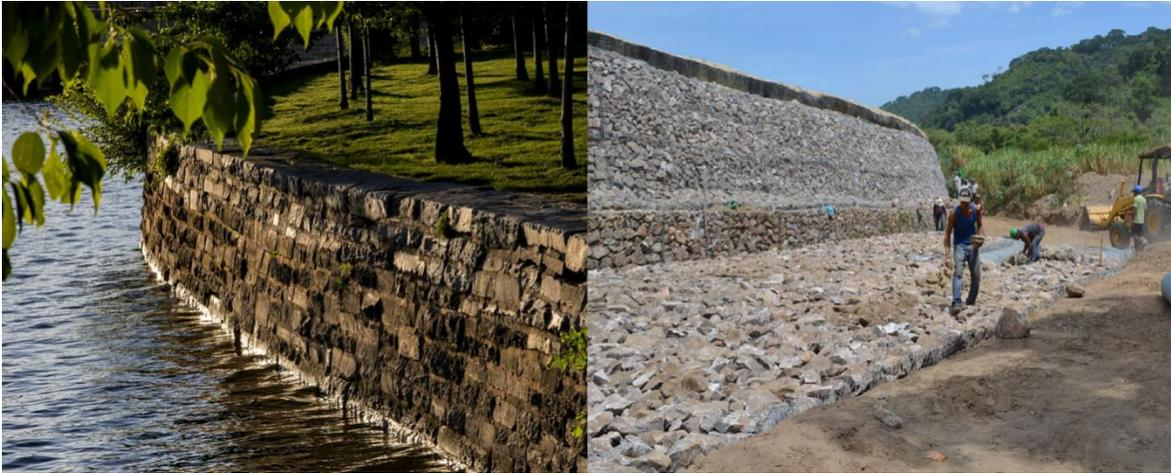
*Figura 5.45 Enrocado para protección de dique de terraplén reforzado*
