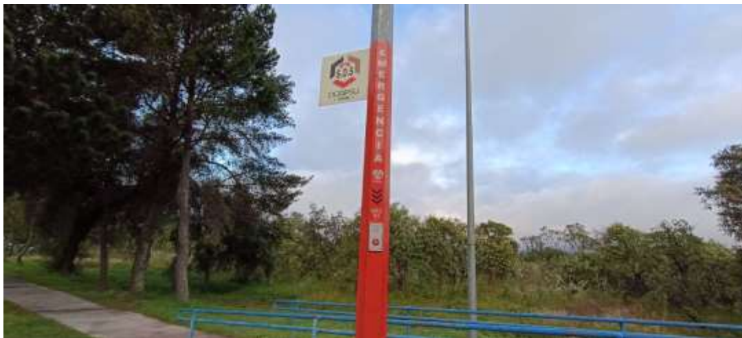
Figura 43. Poste SOS ubicado en Ciudad Universitaria. Fuente: elaboración propia.
