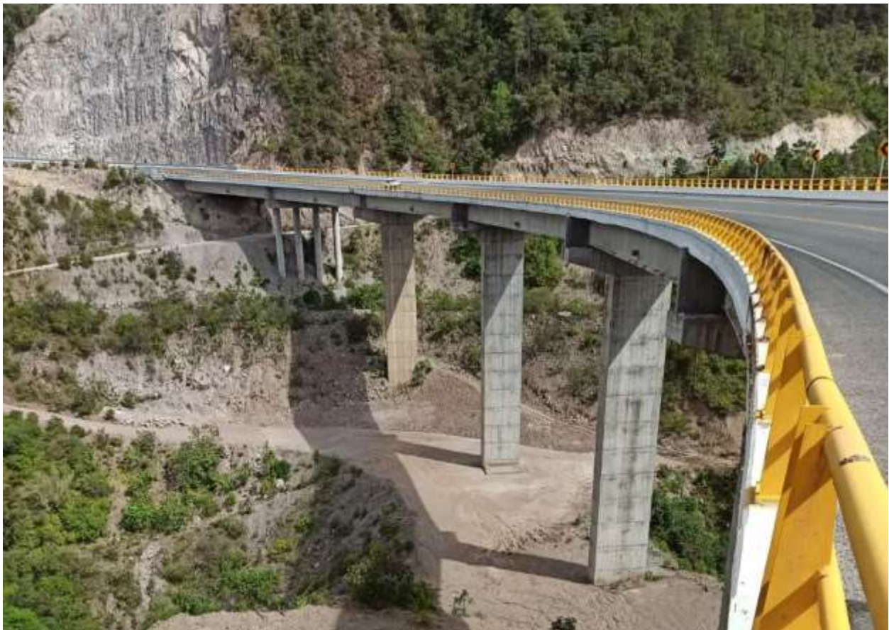
Figura 7. Puente para el tránsito de vehículos terrestres. Fuente: elaboración propia.
