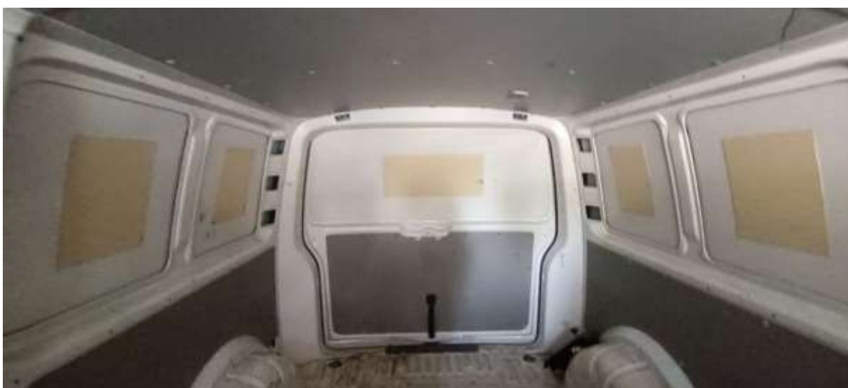
Figura 33. Interior de una furgoneta con ventanas reemplazadas por chapa. Fuente: elaboración propia.
