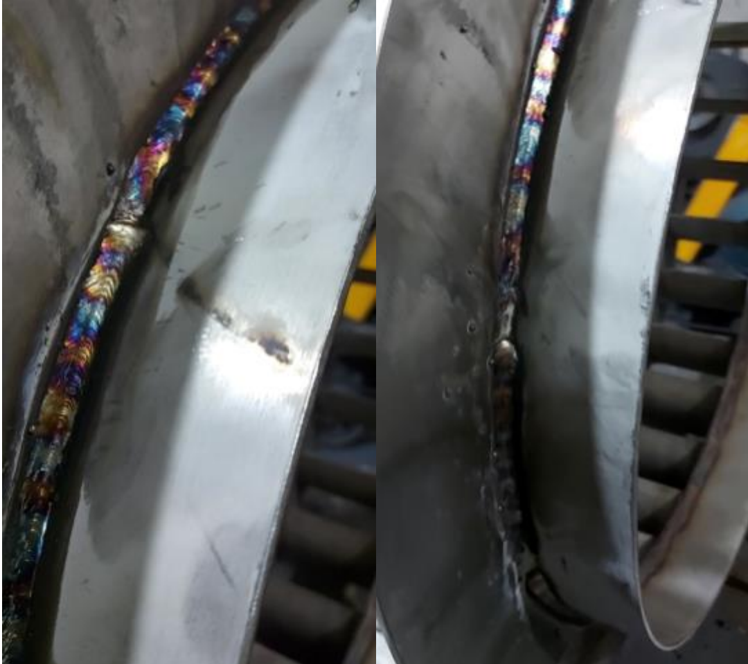
Fig. 5: Ejemplo de inspección de cordones de soldadura
