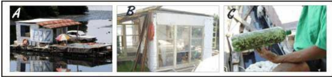
Imagen 23. Casa flotante hecha de basura. A. Vista general de la casa. B. Ventanas recicladas. C. Botellas utilizadas con el relleno mencionado.
