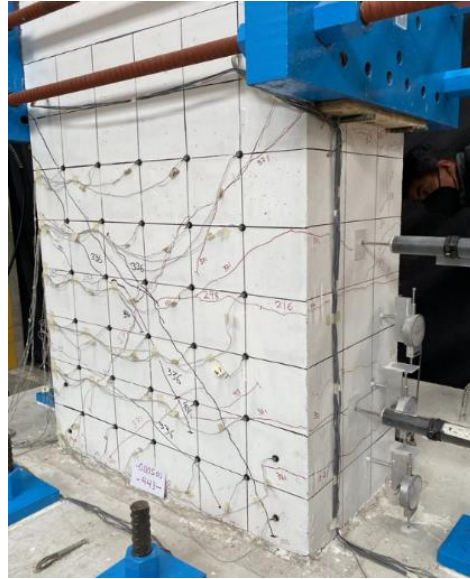
Fig. 3.3.5 Columna O ( R=0.5\% (2)) (Instituto de Ingeniería, 2021 - 2023)
