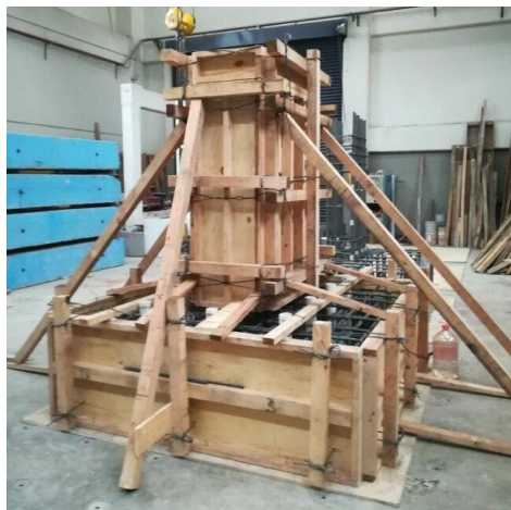
Fig. 2.5.15 Cimbra de la columna (Instituto de Ingeniería, 2021 - 2023)
