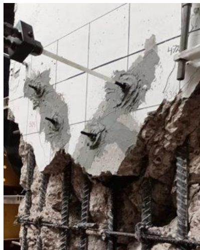
Fig. 3.3.27 Inyección de grietas - Columna OR (Instituto de Ingeniería, 2021 - 2023)
