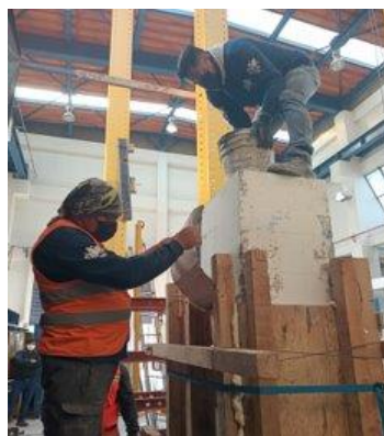
Fig. 3.3.29 Colado del espécimen - Columna OR (Instituto de Ingeniería, 2021 - 2023)
