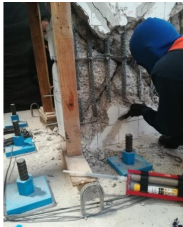
Fig. 3.3.28 Proceso de la inyección de grietas - Columna OR (Instituto de Ingeniería, 2021 - 2023)
