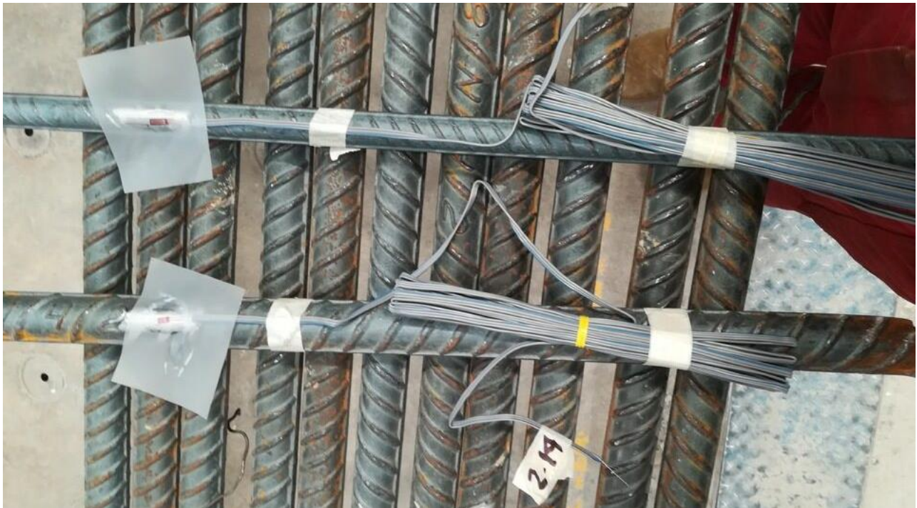
Fig. 2.5.6 Cables de deformímetros (Instituto de Ingeniería, 2021 - 2023)
