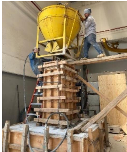
Fig. 2.5.18 Colado de las columnas (Palma, 2022 - 2023)
