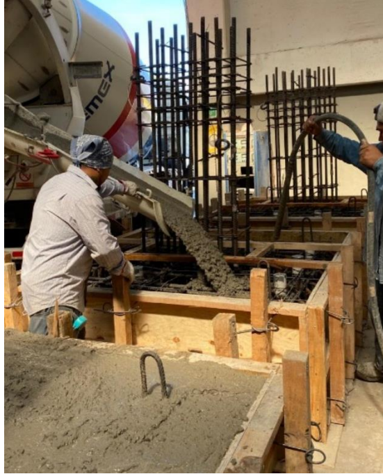
Fig. 2.5.16 Colado del concreto en las zapatas (Palma, 2022 - 2023)
