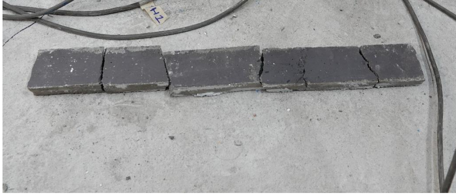
Fig. 3.3.141 Grout desprendido - Columna C-2 (Instituto de Ingeniería, 2021 - 2023)
