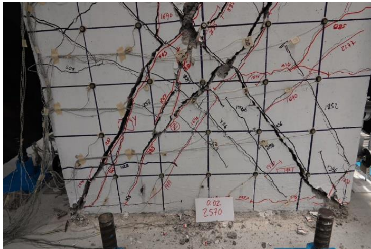
Fig. 3.3.88 Daño en la base de la columna ( R=2\% ) - Columna O*
