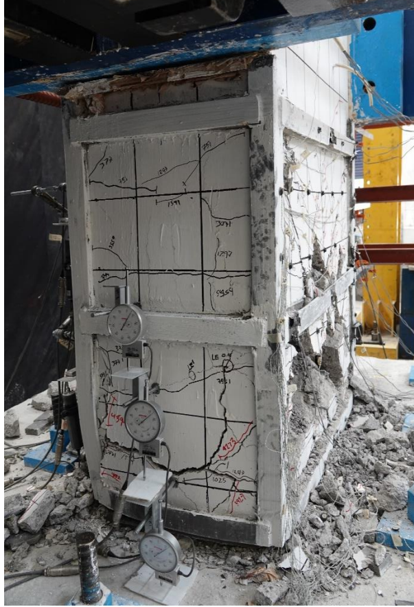
Fig. 3.3.159 Confinamiento de la camisa de acero ( R=-5\% ) - Columna C-2 (Instituto de Ingeniería, 2021 - 2023)
