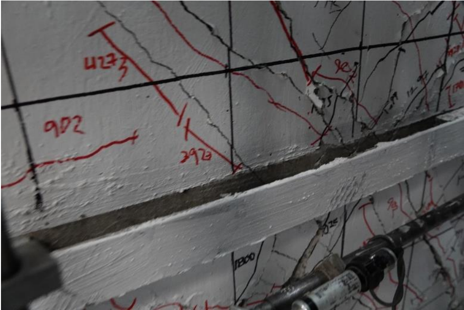
Fig. 3.3.135 Desprendimiento total del grout cara sur - Columna C-2 (Instituto de Ingeniería, 2021 - 2023)
