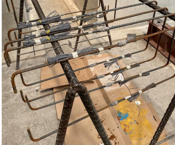
Fig. 2.5.9 Estribos instrumentados (Instituto de Ingeniería, 2021 - 2023)
