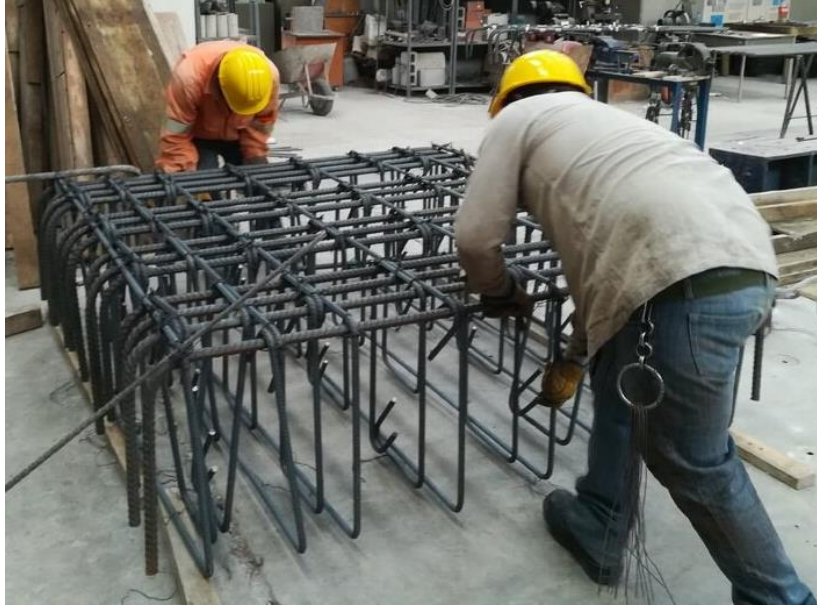
Fig. 2.5.10 Armado de la zapata (Instituto de Ingeniería, 2021 - 2023)
