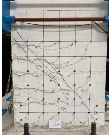
Fig. 3.3.2 Columna O (R=0.5%) (Instituto de Ingeniería, 2021 - 2023)
