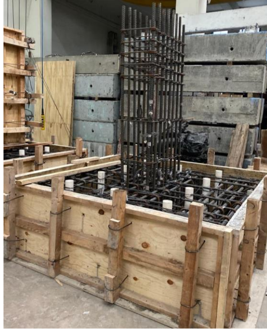
Fig. 2.5.14 Cajón de cimbra de la zapata (Palma, 2022 - 2023)
