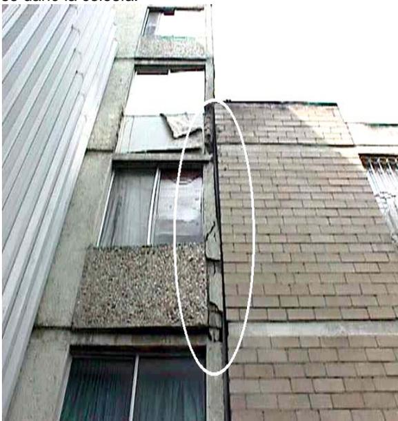
En esta imagen se hace notar la deformación del muro de borde No 11, notando que hay material atrapado entre los dos edificios.
