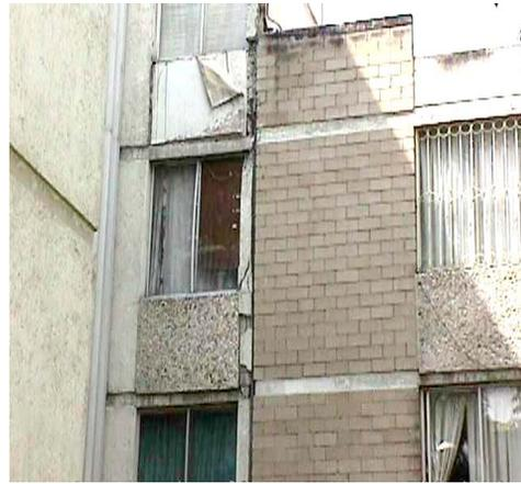
Elevación de la unión entre el edificio S-32 con el S-30. El muro deformado no tiene esquina con alguno con otro que lo rigidice y el precolado bajo la ventana no proporciona dicha rigidez.
