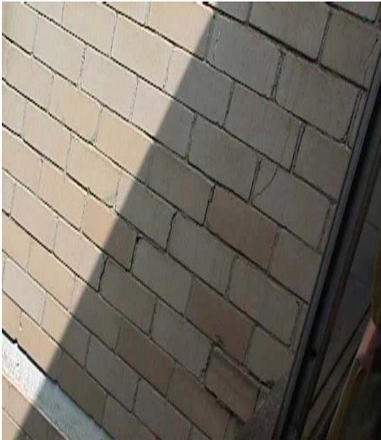
Fisura escalonada típica de hundimientos diferenciales, encontrada en la fachada principal del edificio S-34.
