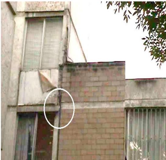
Las losas de ambos edificios, S-32 y S-30, pueden servir como diafragmas horizontales y resistir la presión entre ambos, al colocar topes suficientemente rígidos entre ellas.
