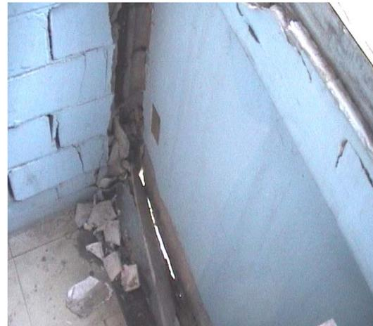
Vista del muro del edificio S-32, donde se aprecia desde el interior que el precolado no rigidiza al muro y se sale de su lugar.
