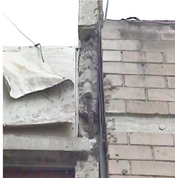
Pretil de azotea del edificio S-30 incrustado a medio entrepiso del departamento 31 del edificio S-32, aquí se aprecia que el precolado bajo la ventana ya fue sustituido por madera.
