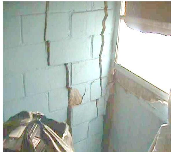
Fractura en el muro de borde del departamento 21 del edificio S-32.
