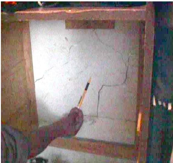
Muro en el clóset del edificio S-30, donde se aprecia la fisura escalonada, típica de hundimientos diferenciales.
