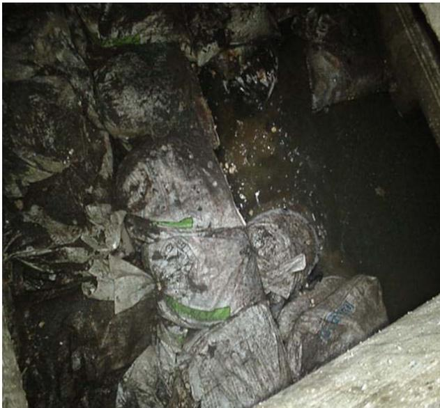
Foto 7. Celda de cimentación con lastre
