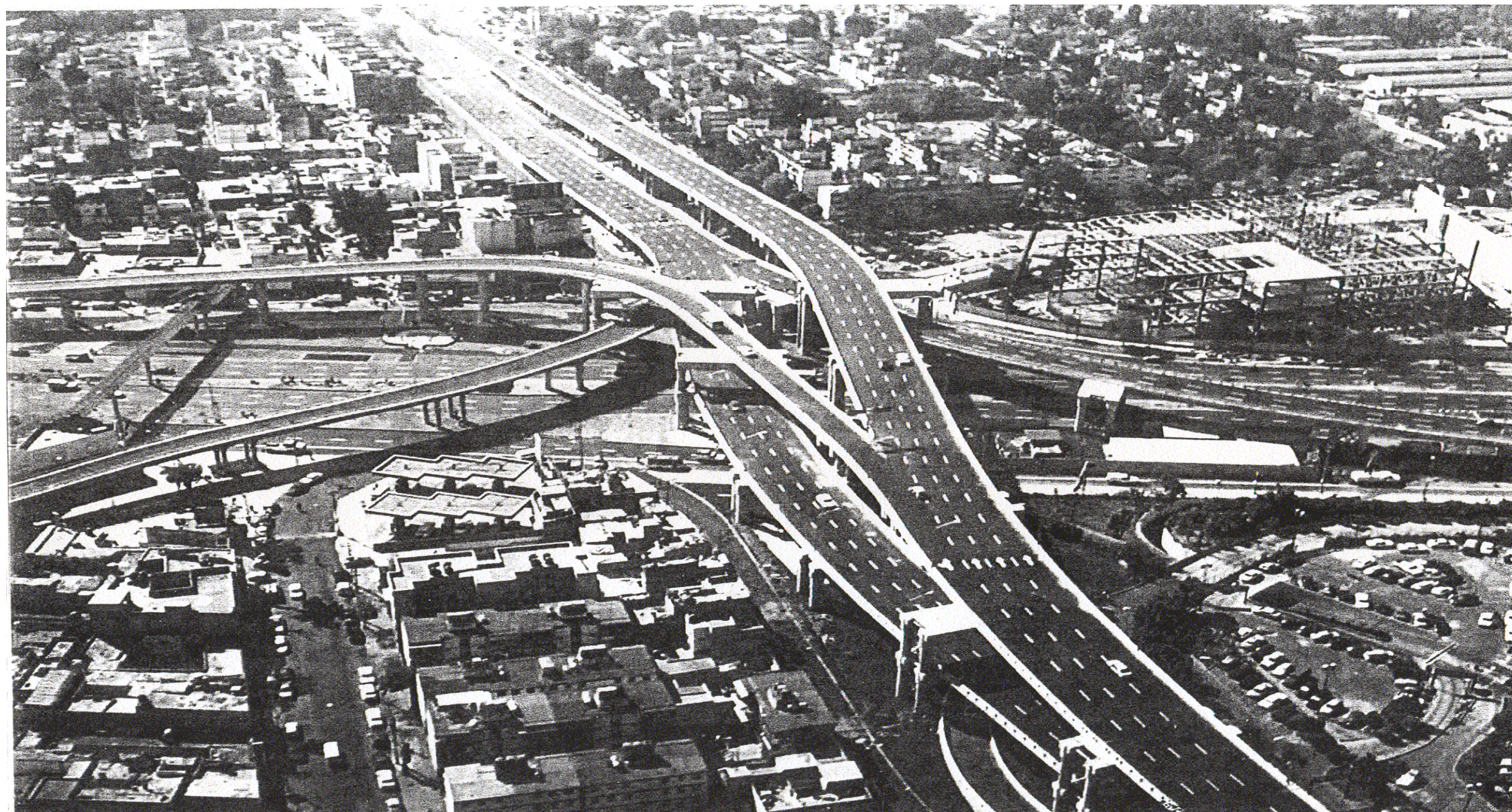
Distribuidor vial “Ing: HEBERTO CASTILLO MARTÍNEZ” (Angulo sup. izq. Francisco del Paso y Troncoso)
