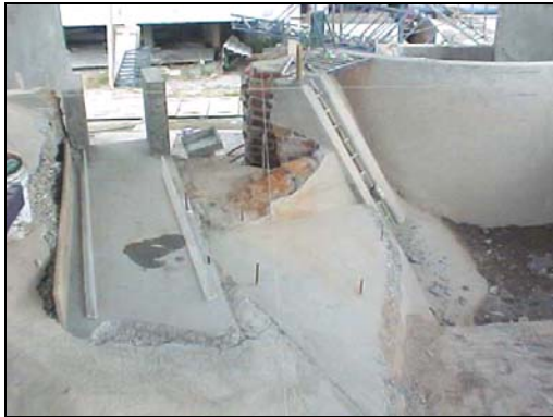
Etapa constructiva del modelo. toma actual.
