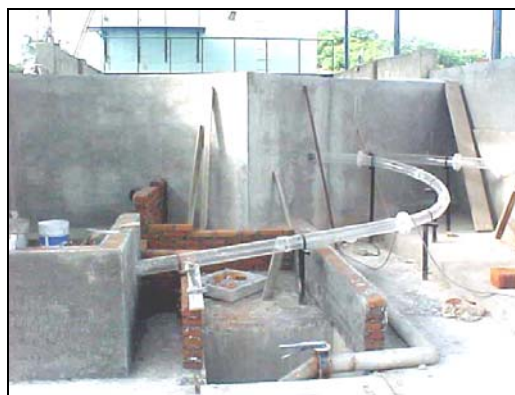
Túnel de descarga del desarenador
