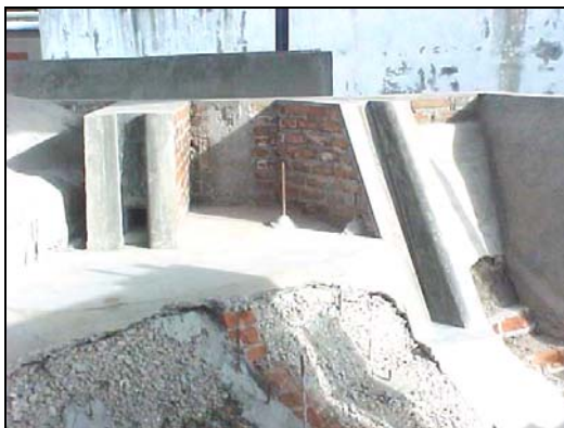
Obra de toma nueva y desarenador.
