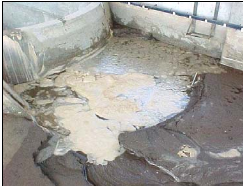
Al obstruirse el desagüe, se recupera el nivel del embalse.
