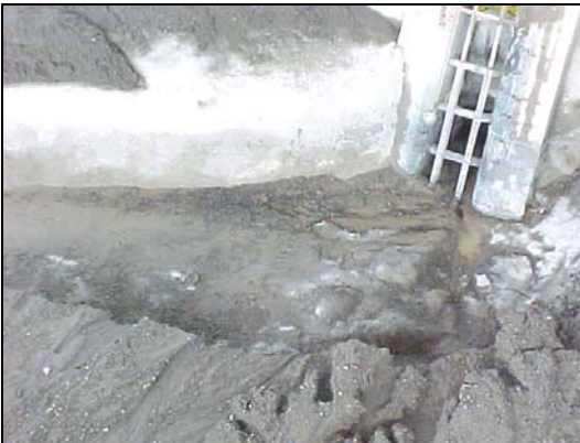
Erosión frente al desarenador
