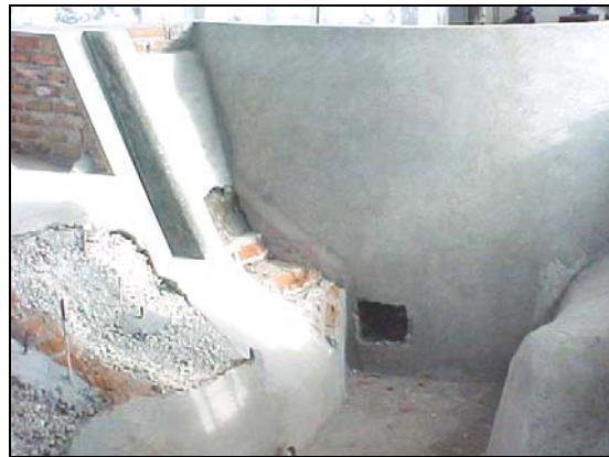
Obra de toma actual y desagüe de fondo
