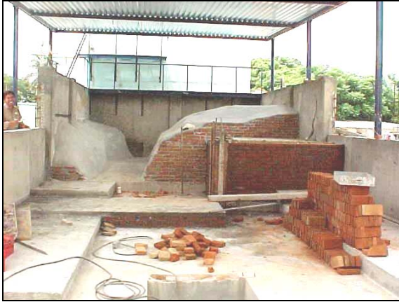
Topografía, aguas arriba.
