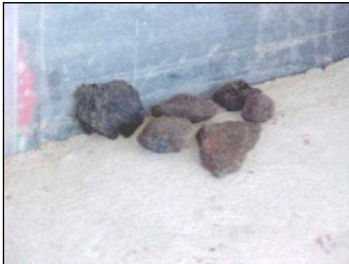
Las piedras arrastradas por el flujo obstruyeron la estructura de rejillas
