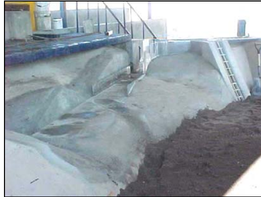
Canal sedimentador-desarenador y obra de toma
