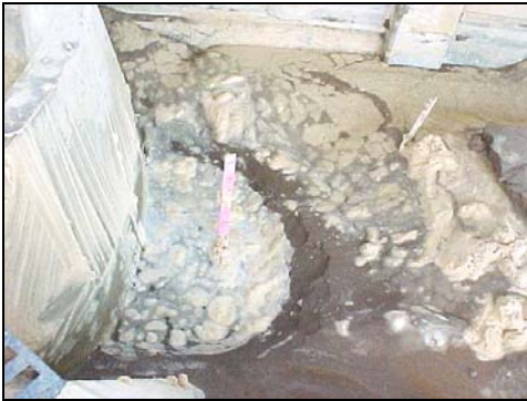
Cono de socavación, 110 min. en modelo
