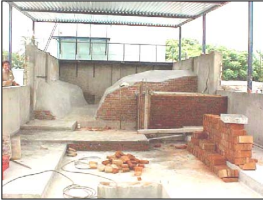
Topografía, aguas arriba.
