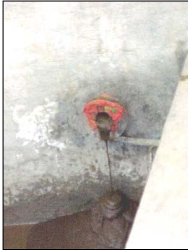
Inicio del ensaye, desagüe prácticamente obstruido
