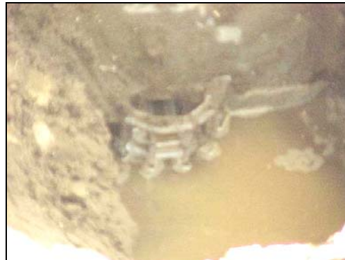
Las piedras arrastradas por el flujo obstruyeron la estructura de rejillas
