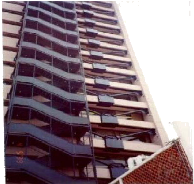
Figura 4.4. Reforzamiento estructural (Vista Posterior)
