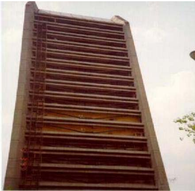
Figura 4.3. Reforzamiento estructural (Vista Frontal)
