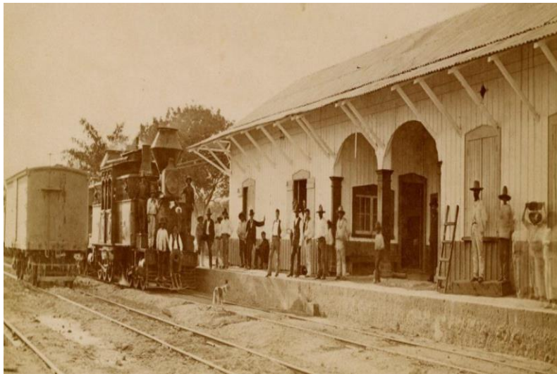
Ilustración 2. Locomotora de Tren en 1878. Fuente: SICT.
