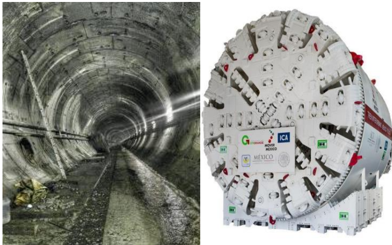
Ilustración 24. Tuneladora y túnel del TIMT. Fuente: ICA
