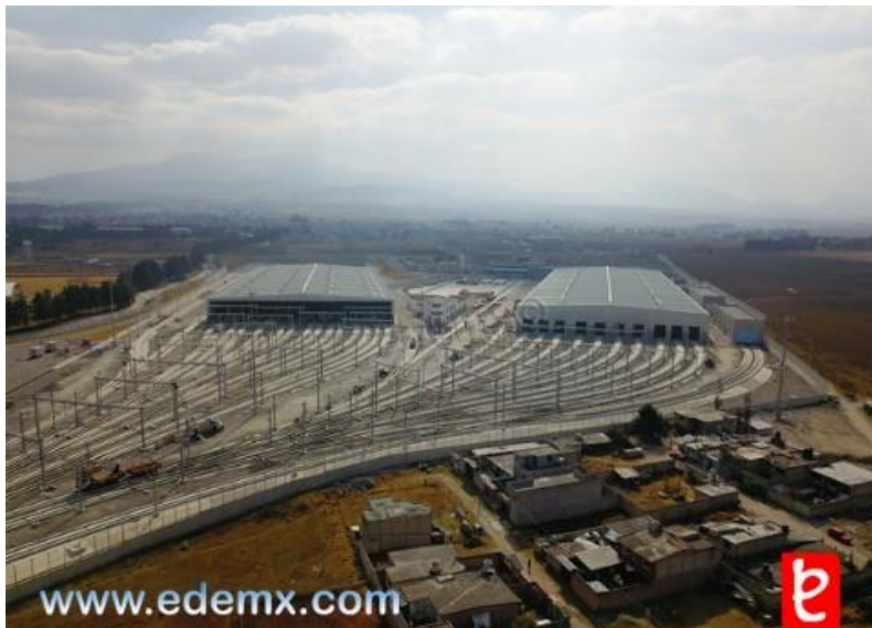
Ilustración 29. Talleres y cocheras. Fuente: Gobierno del Estado México.
