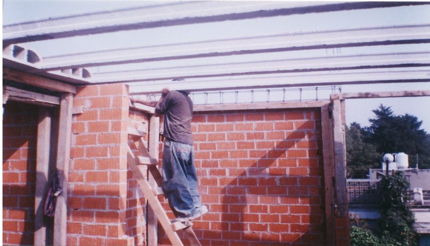
FIGURA IX.1 COLOCACION DE VIGUETAS A CADA 0.60 DE ACUERDO COMO MARCAN LAS ESPECIFICACIONES DE LOS PLANOS.
