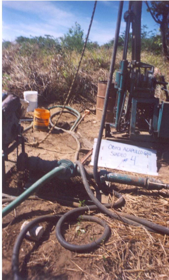
FOTO21. La presente fotografía, muestra el momento de perforación del Sondeo SPT-4. En esta zona la capa vegetal alcanza hasta los 20cm aproximadamente
