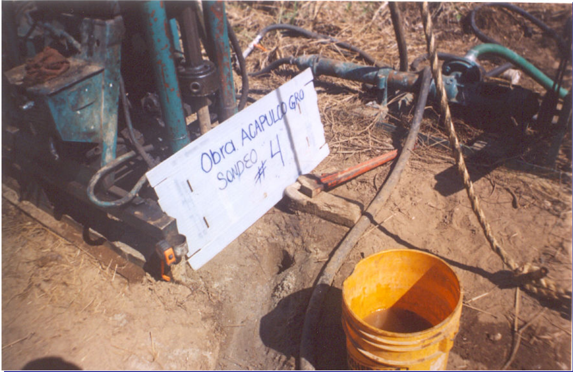
FOTO22. Se tiene la finalización de trabajos en el Sondeo SPT-4.
