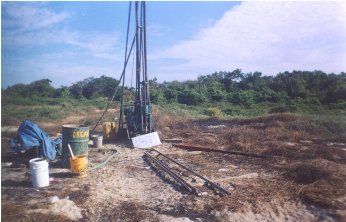
FOTO20. Se ilustra las herramientas utilizadas y la maquinaria de perforación empleadas en el Sondeo SPT-3.
