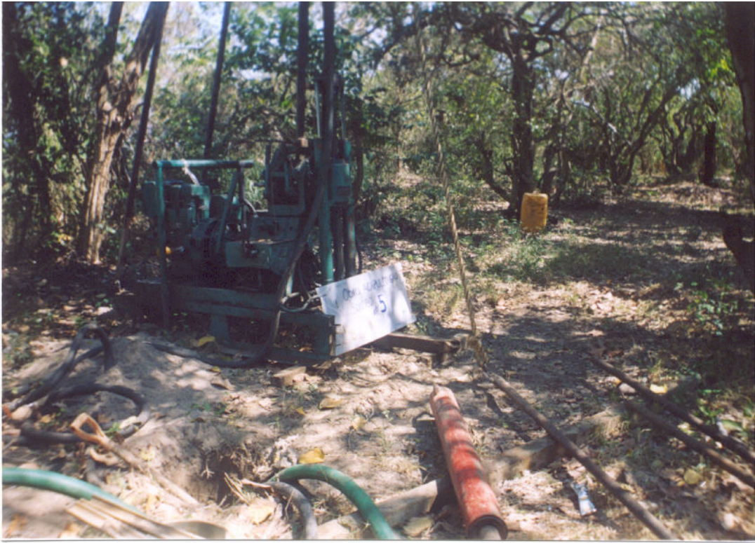
FOTO23. En la zona donde se realizó el Sondeo SPT-5, es muy abundante la vegetación y la capa vegetal aumente hasta los 25cm de espesor.
