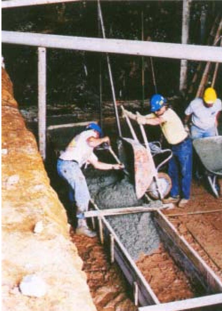
Fig. 4.27 Las carretillas se usan para colar (colocar) el concreto en áreas que no se tienen por otros métodos.
