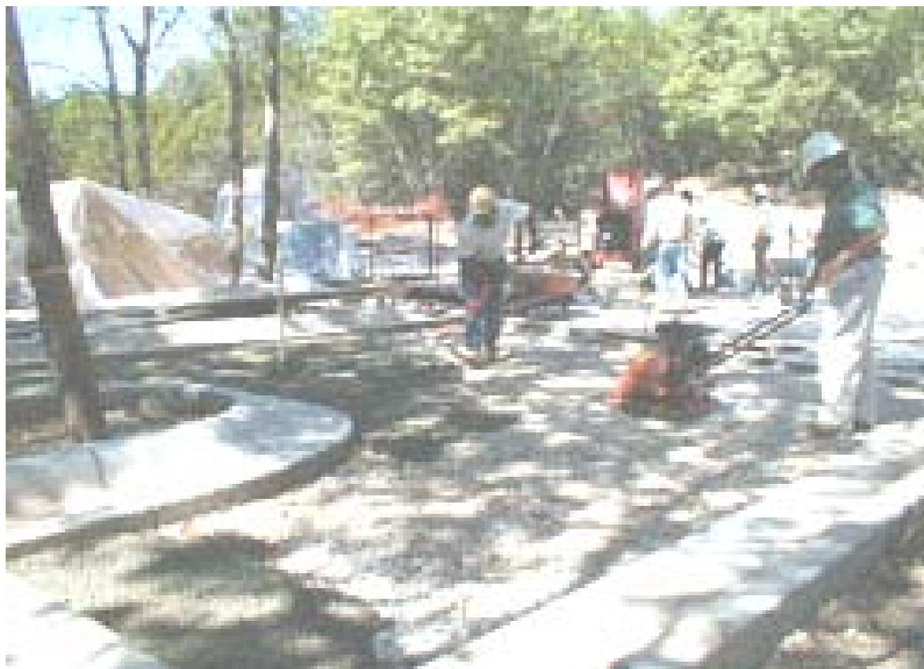
Fig. 4.30 Aplicación del rodillo en una superficie de concreto permeable.
