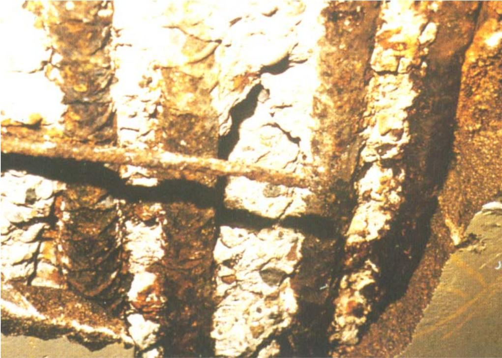
Fig. 11 Daños a la estructura como resultado de la corrosión del acero, inducida por cloruros.
