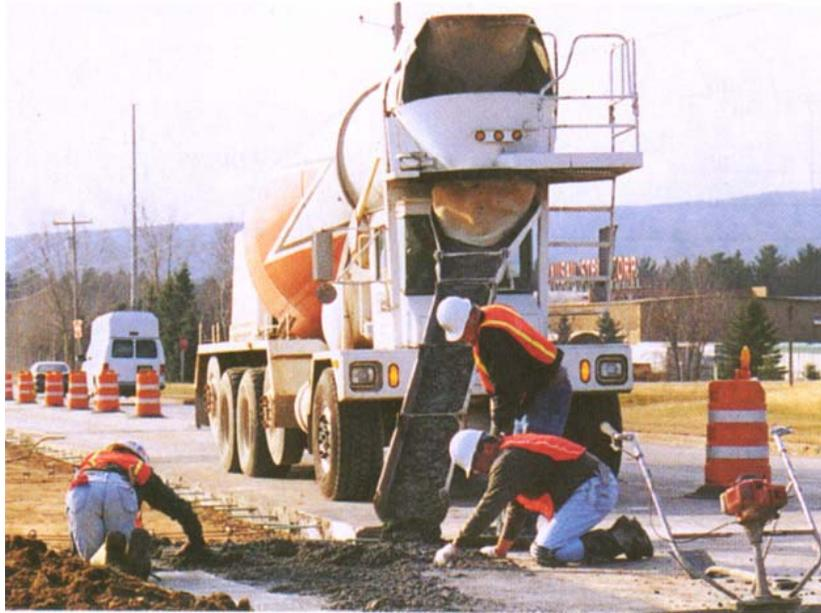
Fig. 4.18. En comparación con los camiones convencionales de descarga trasera los camiones mezcladores de carga delantera dan al conductor mayor movilidad y control para la descarga directa en el sitio.
