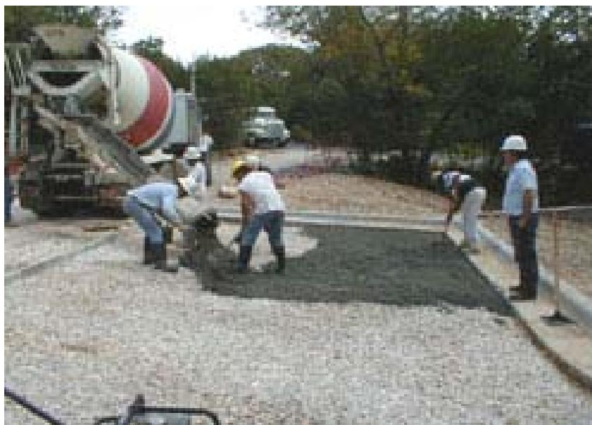
Fig. 4.31 Colocación del concreto permeable.
