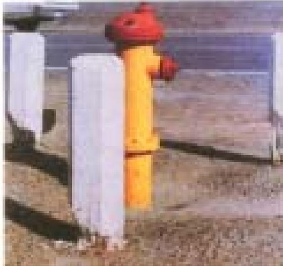
Fig. 3.14 Ataque de sulfatos, en la región sometida a mojado y secado, la cual, es normalmente cerca del nivel del suelo.
