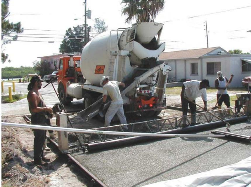
Fig. 4.28 Trompo o revolvedora móvil
