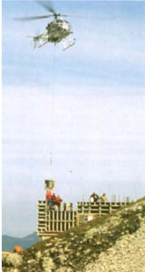
Fig. 4.23. Para trabajos sobre el terreno o sitios inaccesibles, un cubo de concreto se levanta por medio de un helicóptero.
