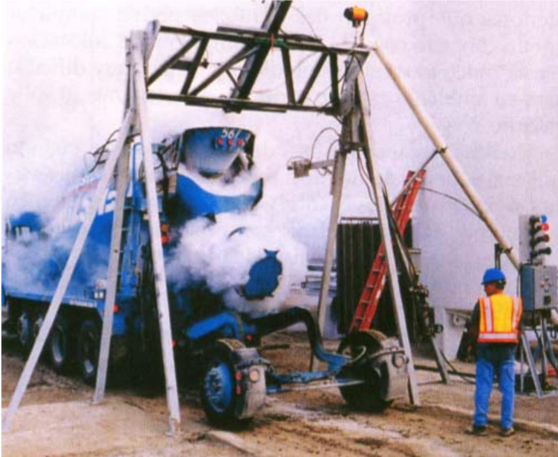
Fig. 4.2 El nitrógeno líquido, adicionado directamente en el camión mezclador en la planta de concreto premezclado, es método para la reducción de la temperatura del concreto.
