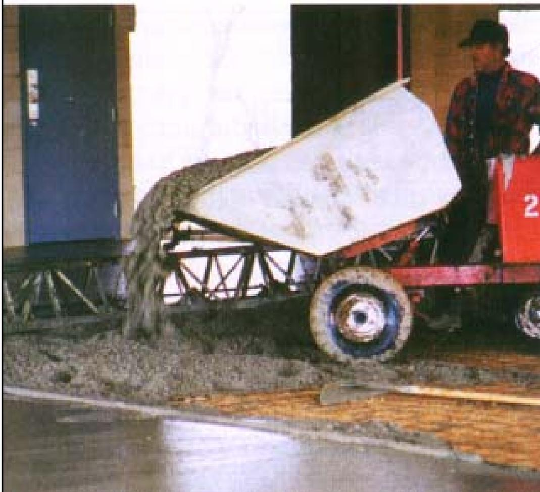
Fig. 4.1 Colocación del concreto lo más cerca posible.
