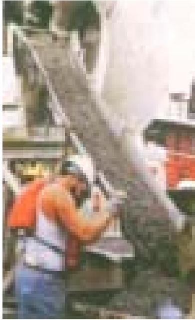
Fig. 3.4 El concreto fluye con buena trabajabilidad, en su colocación
