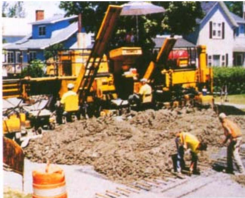
Fig. 4.26 Los camiones basculantes depositan el concreto delante de la pavimentadota de cimbras deslizantes, lo cual coloca a todo lo ancho de una calle en una sola pasada.
