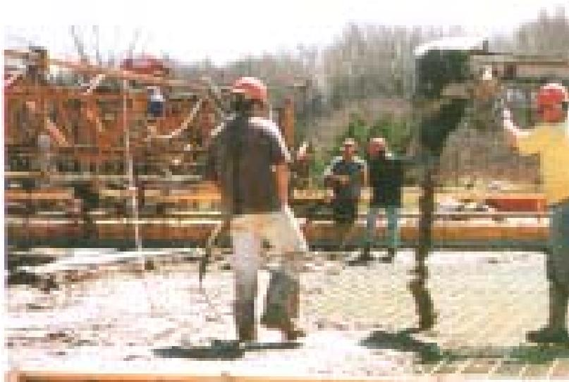
Fig. 4.25. Brazos giratorios en las esferas (bandas, cintas) transportadoras permiten que se coloque el concreto fresco de manera bastante homogénea en toda la cubierta,
