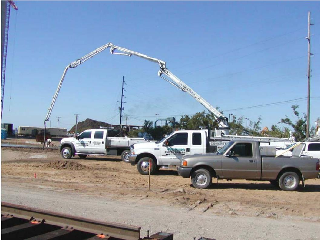
Fig. 4.32 Un aguilón montado en un camión, el cual descarga el concreto en distintas posiciones.
