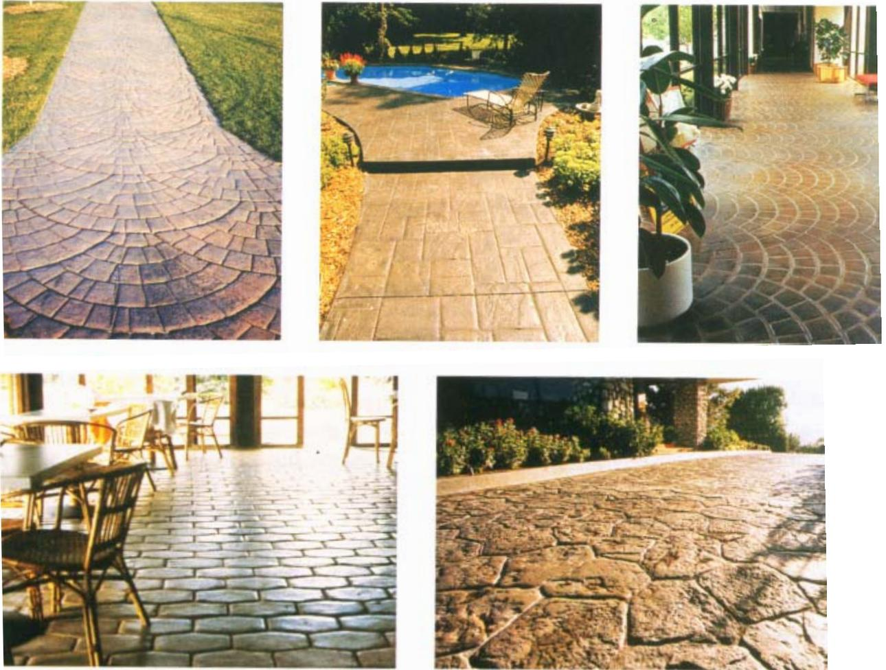
Fig.5.1 Acabado de concretos estampados, texturizados y coloreados.
