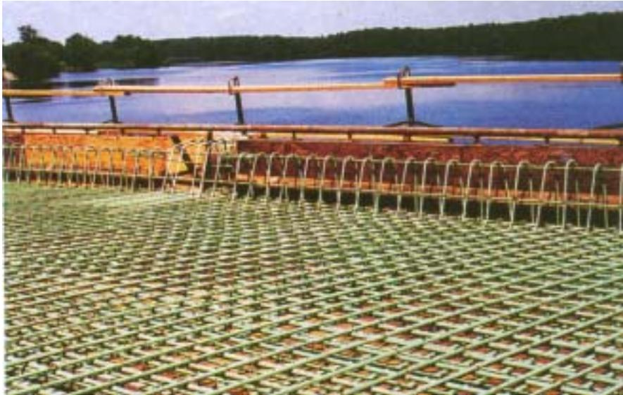
Fig. 3.13 Armadura revestida con epoxis usada el tablero de un puente.
