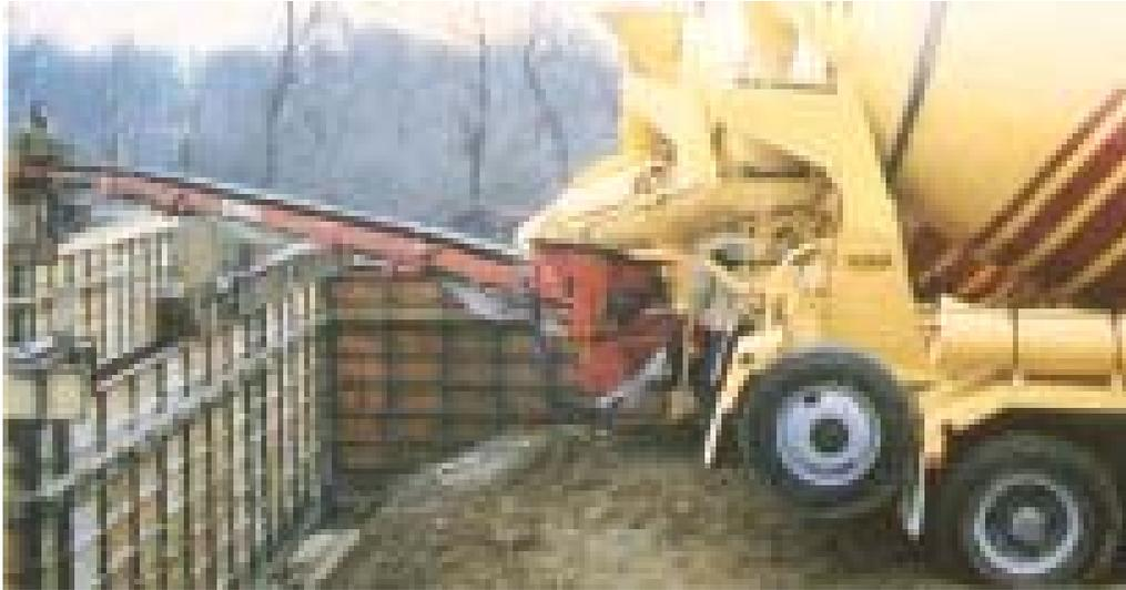
Fig. 4.20. La esfera transportadora montada sobre el camión mezclador coloca el concreto hasta 12 metros sin la necesidad de otro equipo de manejo.
