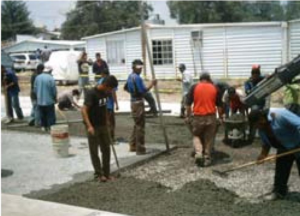
Fig. 4.5 Colocación del concreto permeable.
