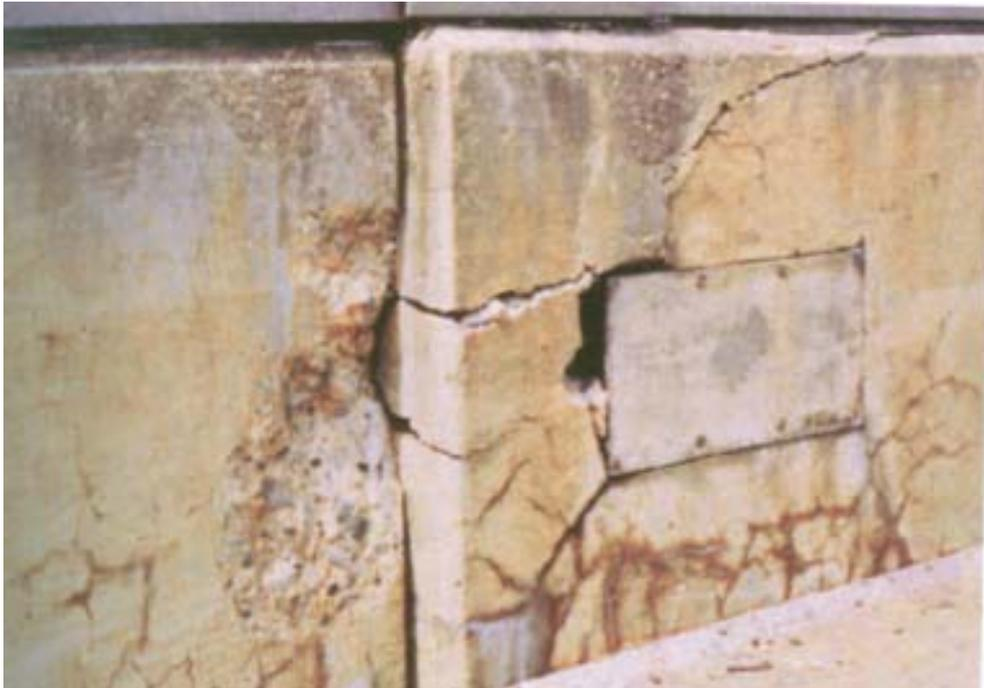
Fig.3.11 La figuración, el cerramiento de las juntas y la dislocación lateral fueron causados por la reactividad de álcali-agregado, en este muro de parapeto.
