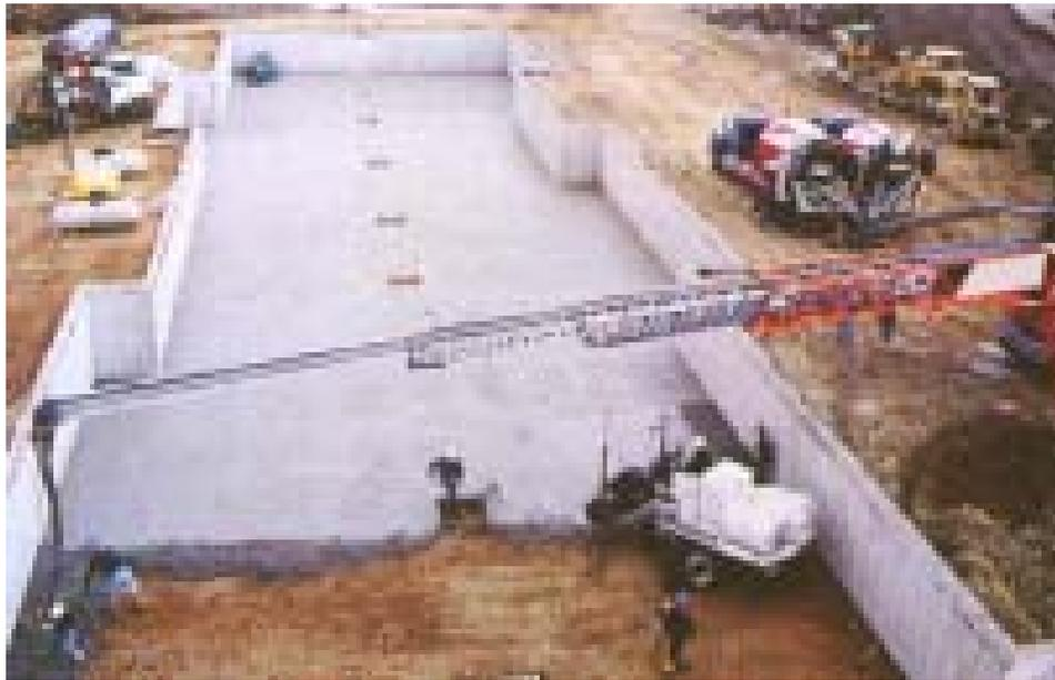
Fig. 4.19. La esfera (banda) transportadora es un método eficiente y portátil para el manejo del concreto
