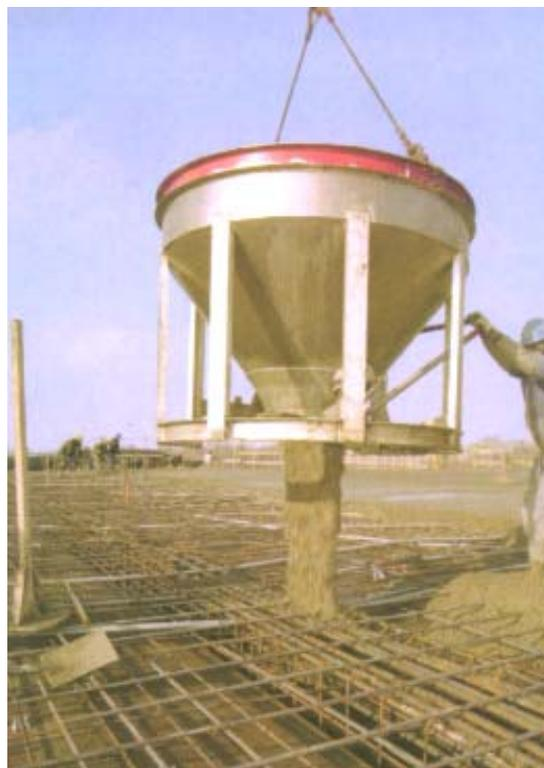
Fig. 4.15. Colocación del concreto mediante una grúa y cubo.
