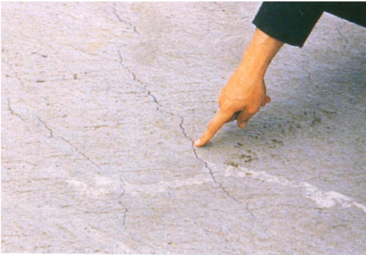
Fig. 4.3 Fisuras típicas, por el fraguado rápido.
