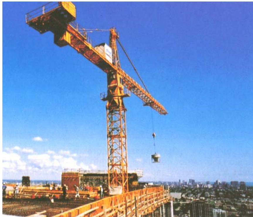
Fig. 4.17. La torre grúa y el cubo pueden manejar el concreto fácilmente en construcciones en edificios altos.
