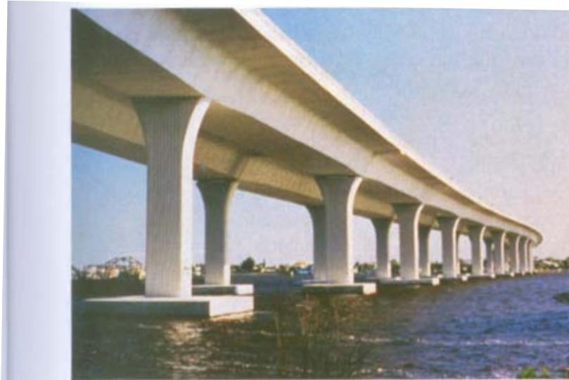
Fig. 3.17 Los concretos de puentes expuestos al agua del mar se deben diseñar y proporcionar especialmente para la durabilidad
