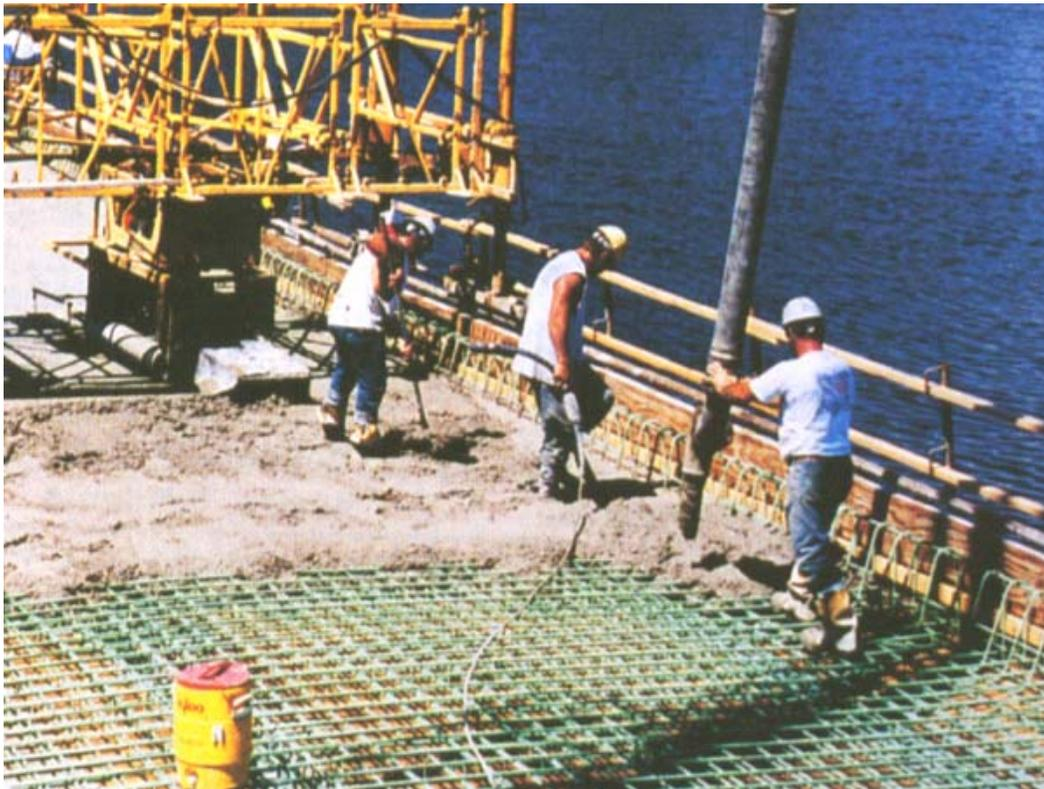
Fig.4.9 concreto con baja relación agua-cemento y baja permeabilidad a los cloruros, ideal para el tablero de puentes, se produce fácilmente con reductores de agua de alto rango.
