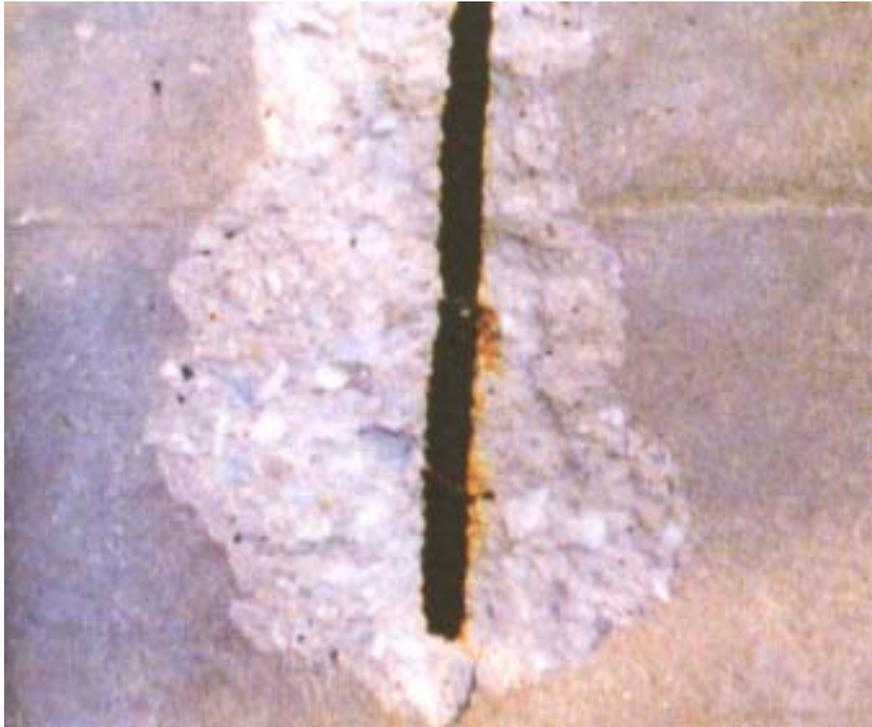
Fig. 3.12 Aquí podemos apreciar la carbonatación penetrando al acero de refuerzo.
