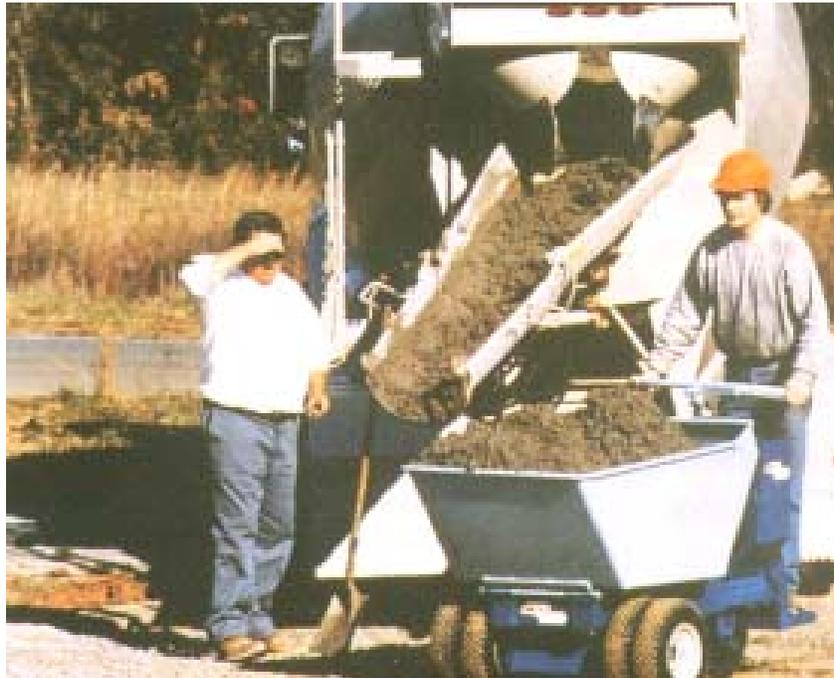
Fig. 4.14. Descarga del concreto a través de un canalón desde el camión mezclador.
