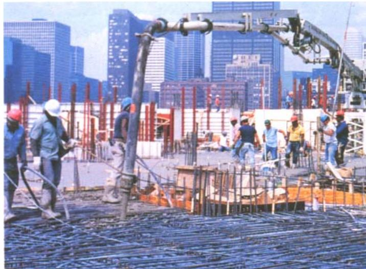
Fig. 4.24. Un aguilón montado sobre un mástil y localizado cerca del centro de la estructura puede llegar frecuentemente a todos los puntos de la localización. Se usa principalmente en edificios altos donde las torres de grúas no se pueden ocupar de al colocación del concreto.
