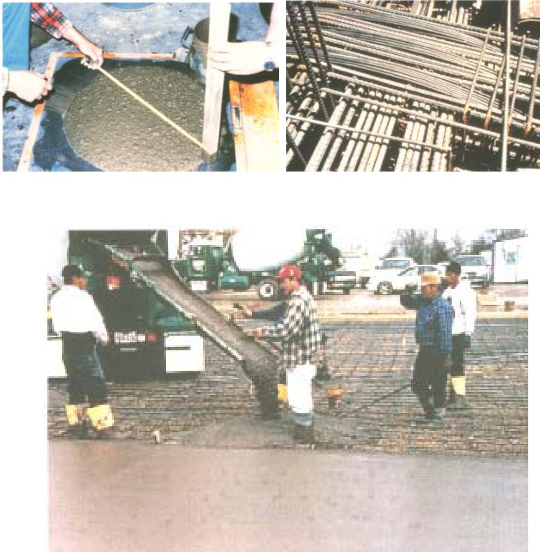
Fig. 4.10 Concreto fluido con alto revenimiento, colocado fácilmente, en áreas con alta congestión de acero de refuerzo.
