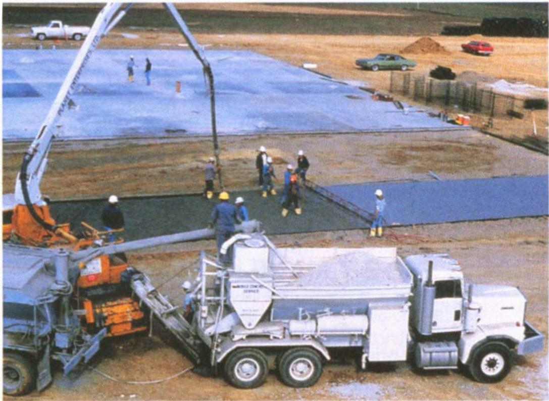
Fig. 3.5 Dosificadora móvil, la cual mide los materiales por volumen y mezcla continuamente, a medida que los ingredientes secos, agua y aditivos se alimentan dentro del tambor de mezclado en la parte trasera del vehículo.
