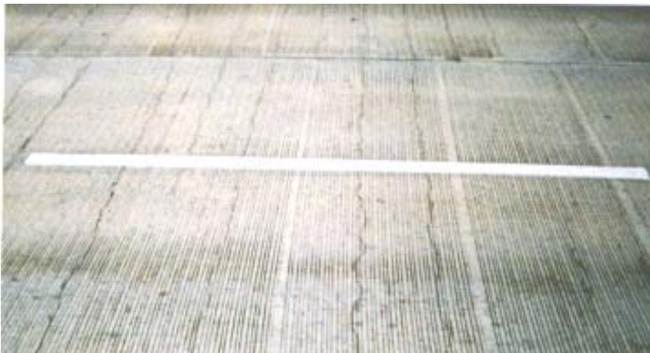
Fig. 12 Fisuras por contracción, como se muestra en este tablero de puente, las cuales se pueden reducir con uso de aditivos reductores de contracción.
