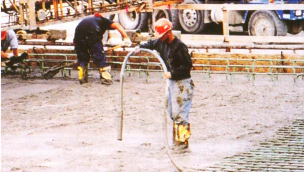
Fig. 4.29. Vibradores usados en la consolidación del concreto
