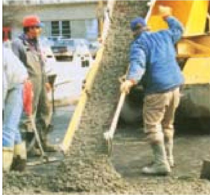
Fig. 4.16. Descarga del concreto premezclado desde el camión mezclador.
