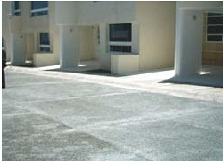
Fig. 3.8 pavimento de concreto permeable.
