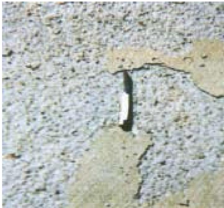
Fig. 4.8 Descascaramiento del concreto resultante de una carencia de aire incorporado.
