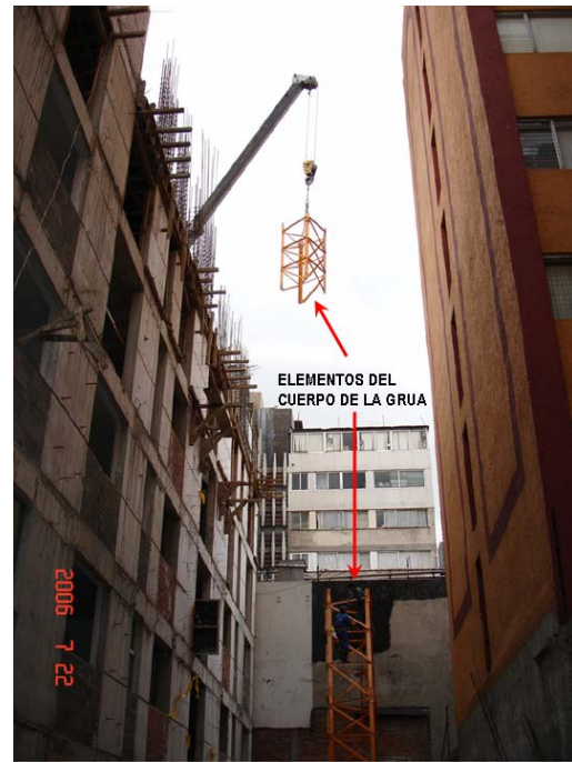
Imagen 4.26 Retiro de lastres de bancada Imagen 4.27 Desarmado del cuerpo de la grúa torre La segunda plataforma se cargó con los siguientes componentes:
