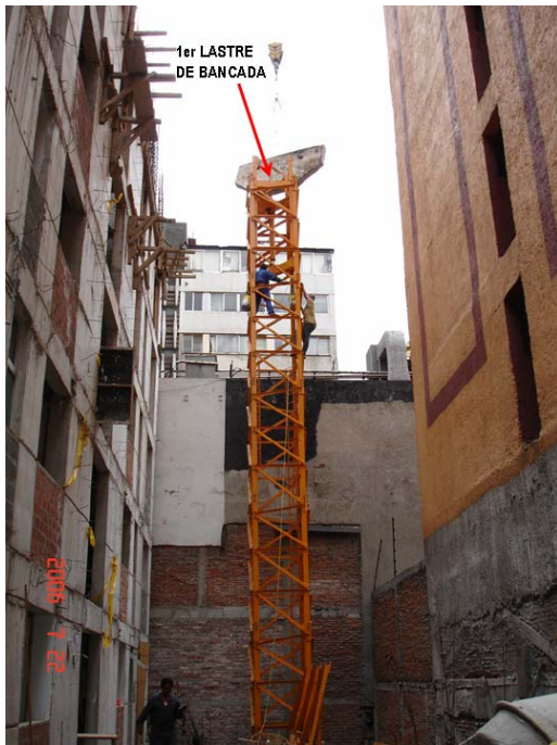
Imagen 4.26 Retiro de lastres de bancada Imagen 4.27 Desarmado del cuerpo de la grúa torre La segunda plataforma se cargó con los siguientes componentes:
