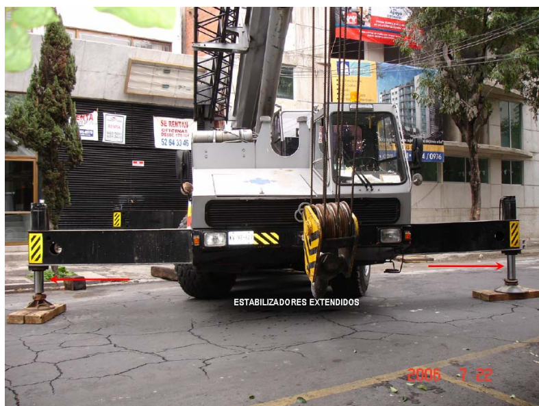
Imagen 4.15 Anclaje de la grúa auxiliar
