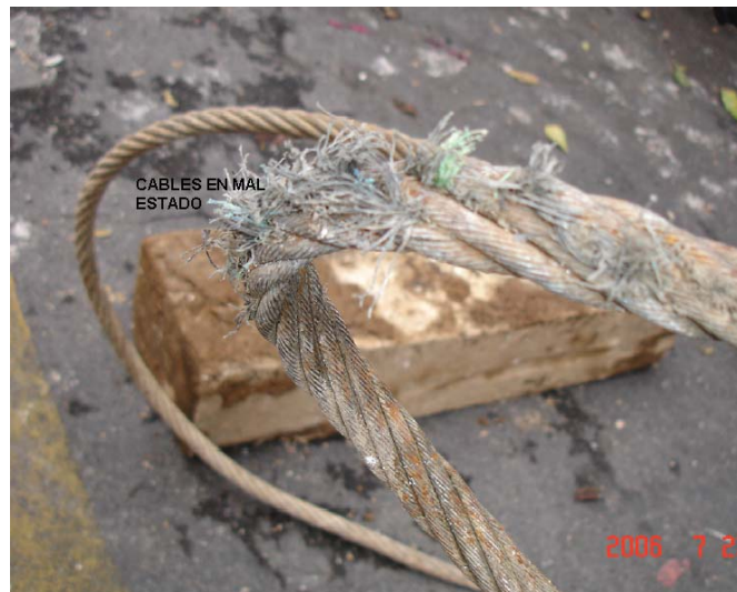
Imagen 4.10 Cables en mal estado
