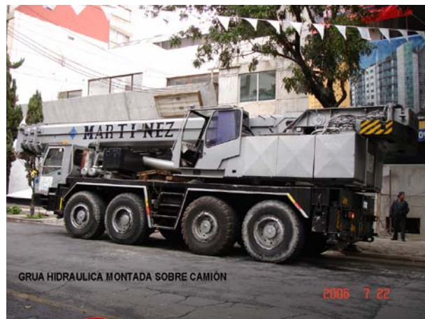
Imagen 4.5 Grúa hidráulica de 80.0 t
