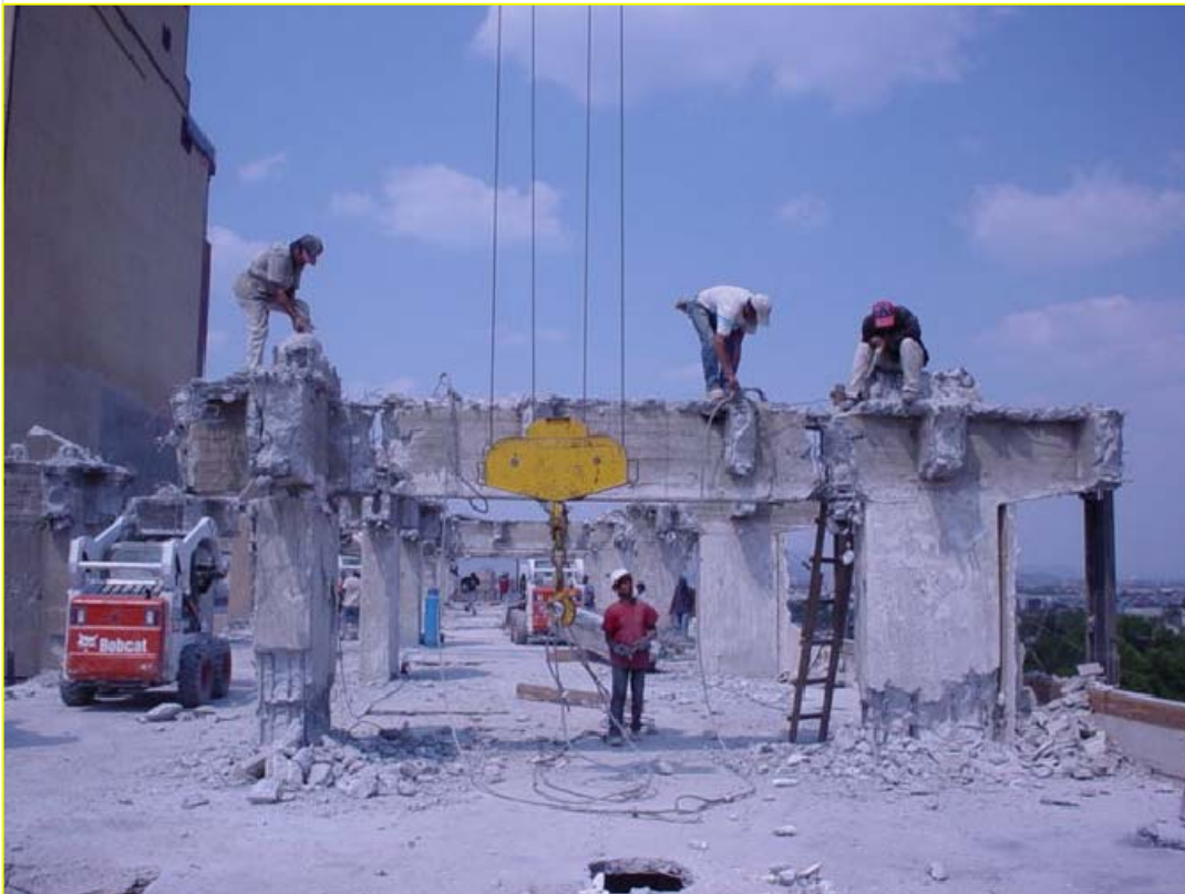
FOTOGRAFÍA No. 4 TRABAJOS DE DEMOLICIÓN.
