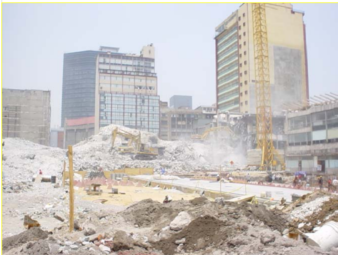
FOTOGRAFÍA No. 6 PANORAMA DEL FINAL DE LA DEMOLICIÓN.
