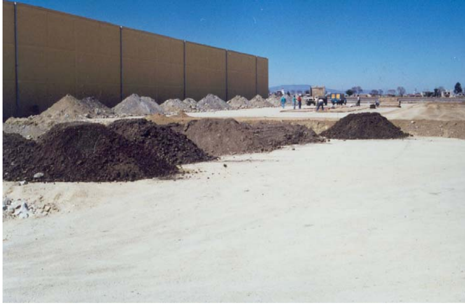
II.3.2 Material de relleno desplantado y terreno perfectamente compactado
