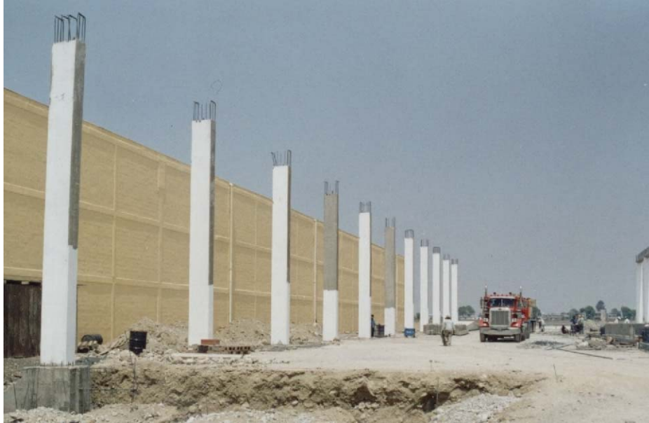
V.2.8. Colocación de columnas.
