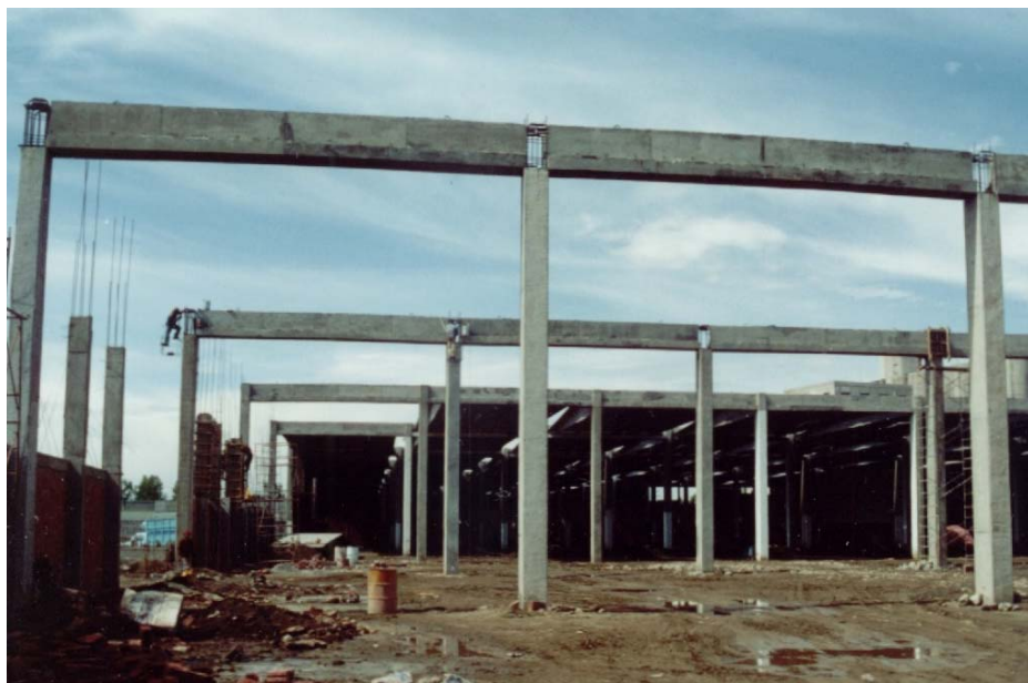
V.3.7. Trabes portantes montadas.
