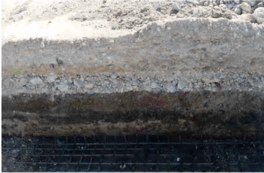
II.3.6. Corte de suelo estabilizado.
