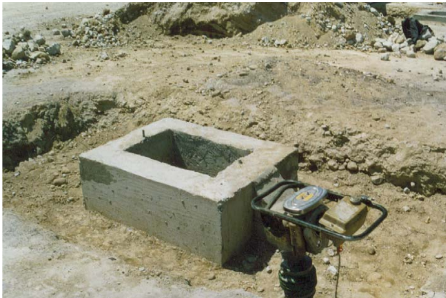
V.1.4. Compactación de material de relleno en zapatas.
