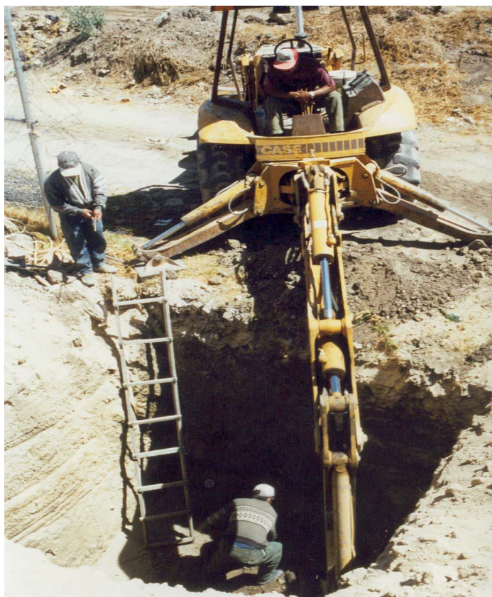
V.1.2. Excavación y retiro de materiales para desplante de zapatas.
