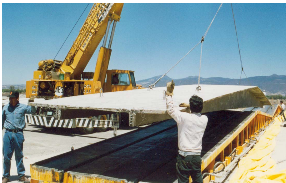
V.4.1. Descimbrado de losas.
