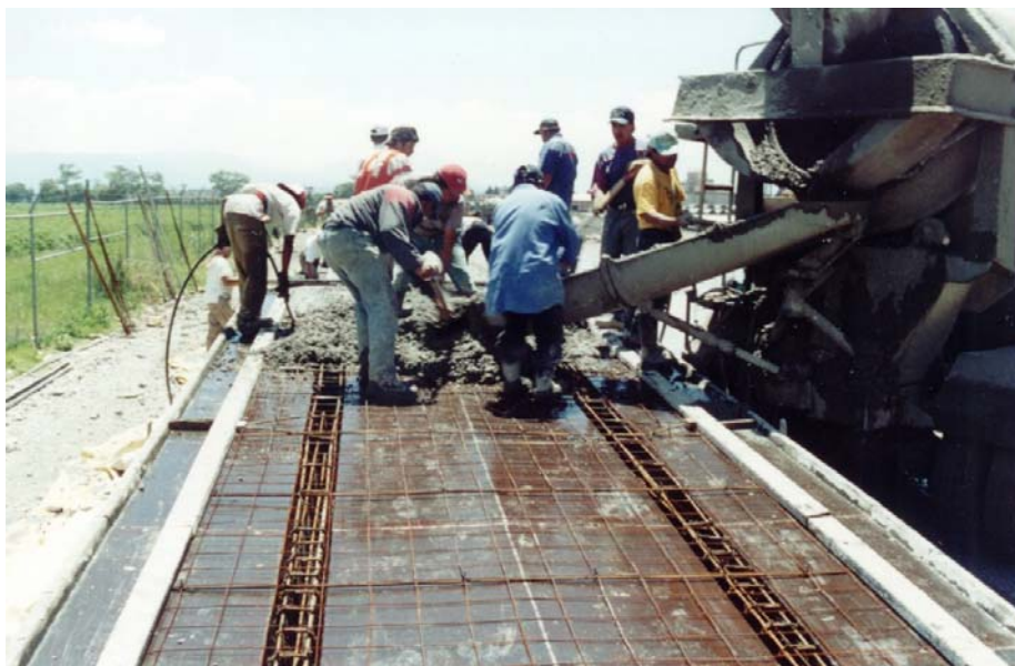
IV.2.4. Colado en sitio. Olla proporcionando concreto.
