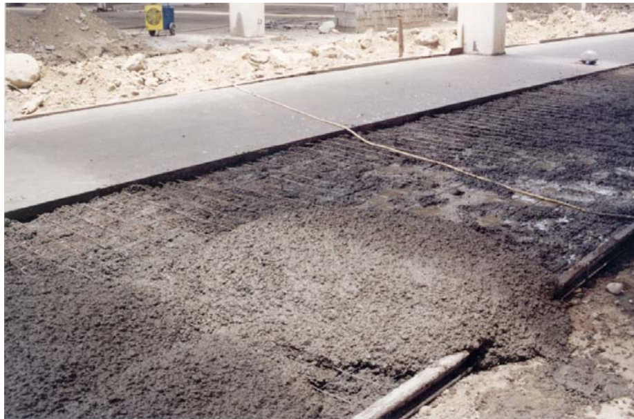
IV.2.2. Colado de pisos
