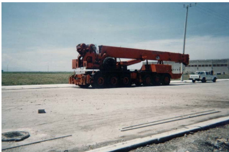
V.1.8. Grúa para montaje de elementos de concreto.
