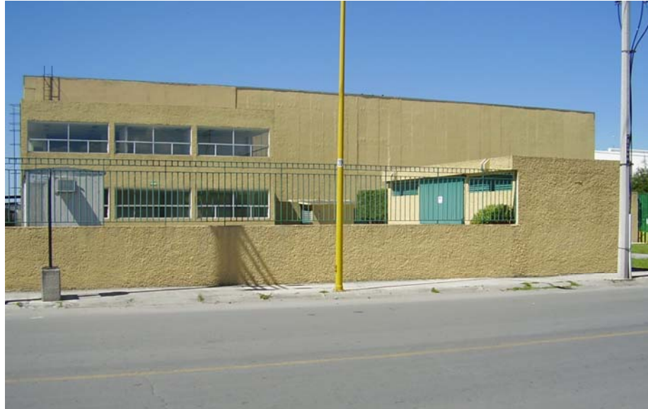
VII.2. Nave terminada.
