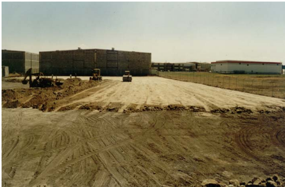
II.3.3 Compactación de de tepetate con rodillo
