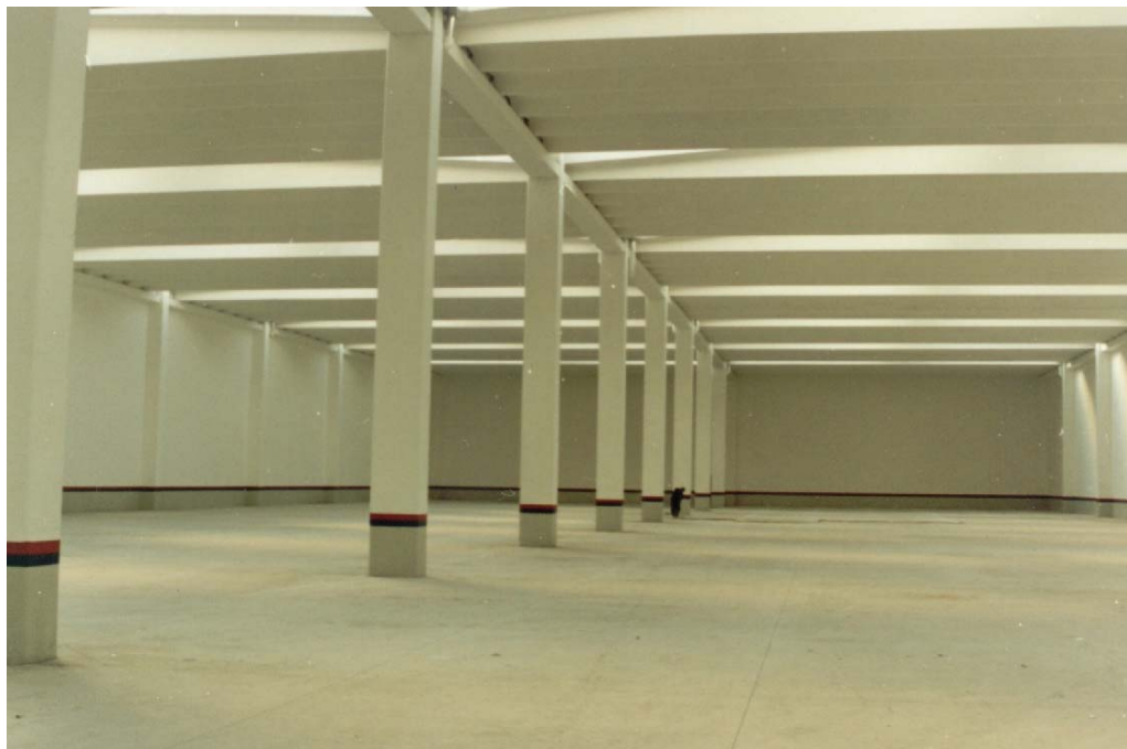
V.5.6. Acabado interior de la nave.
