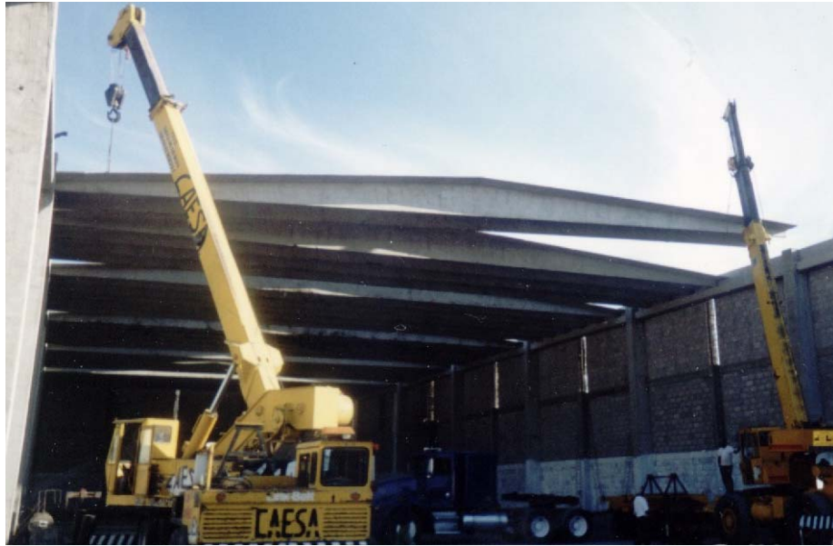
V.4.7. Montaje de la losa con 2 grúas.
