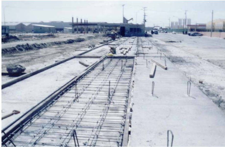
IV.1.8. Prefabricación de muros en serie.
