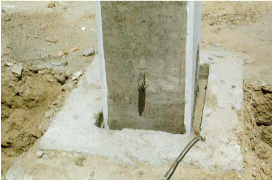
V.2.6. Relleno de grout en espacio vacío entre columna y candelero.
