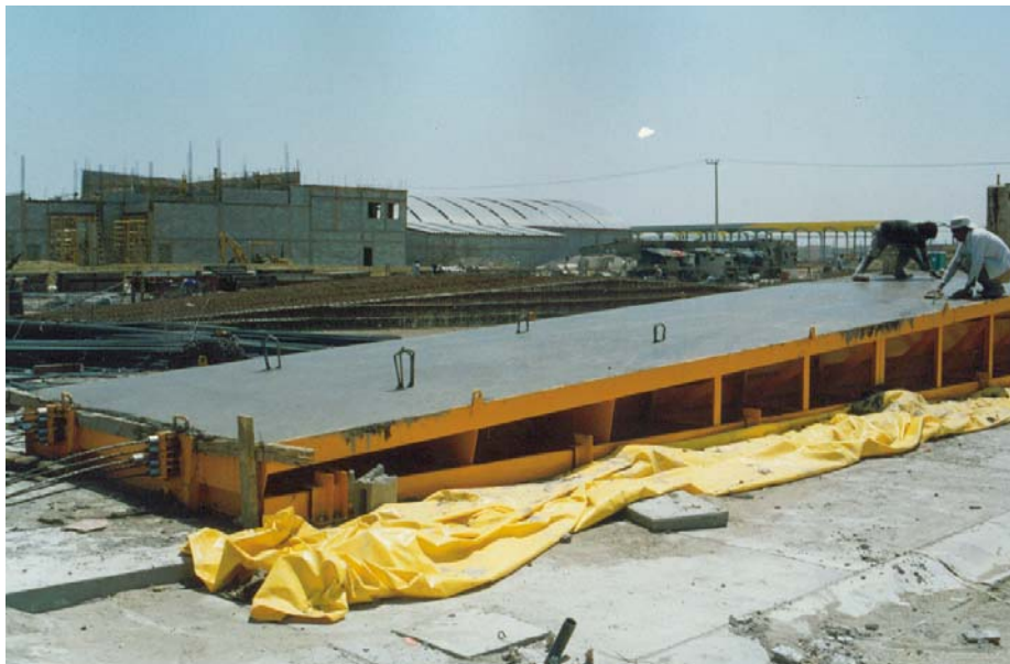
IV.2.6. Acabado final a la pieza de concreto.
