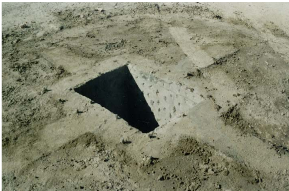
V.1.5. Cimentación cubierta y compactada.
