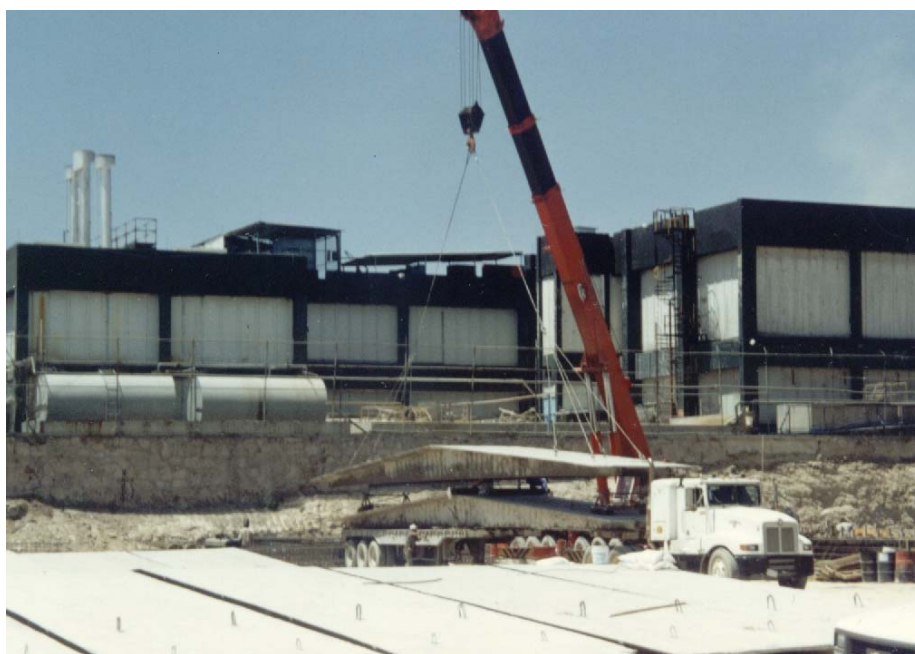
V.4.4. Maniobra de colocación en trailer de transporte.
