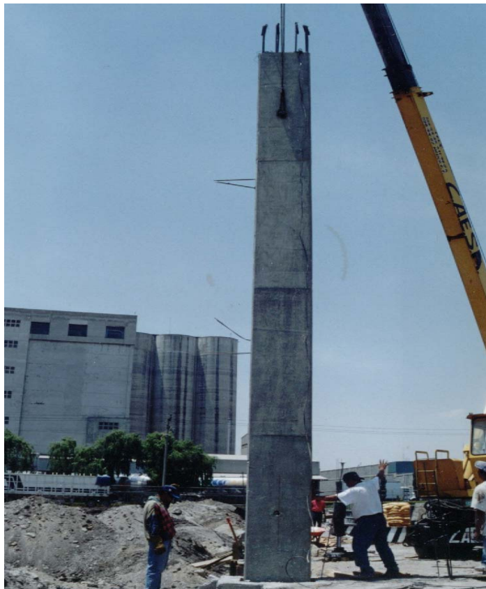
V.2.5. Colocación de columna dentro de candelero.
