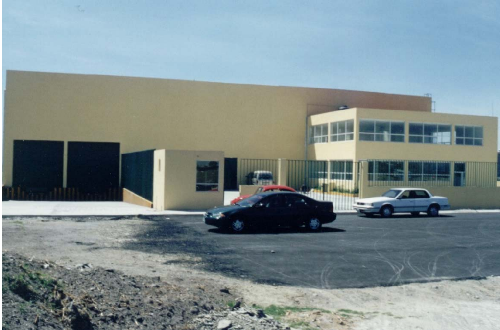
V.5.7. Acabado exterior de la nave.
