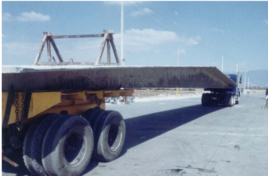
V.4.5. Losa colocada en trailer de transporte.
