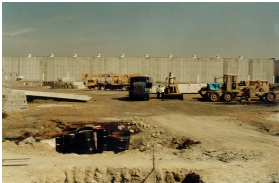
II.3.4 Equipo utilizado para llevar a cabo la estabilización del terreno
