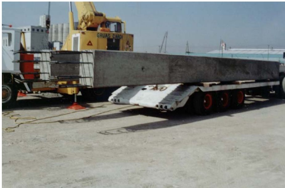
V.2.3. Columna colocada en trailer de transporte.
