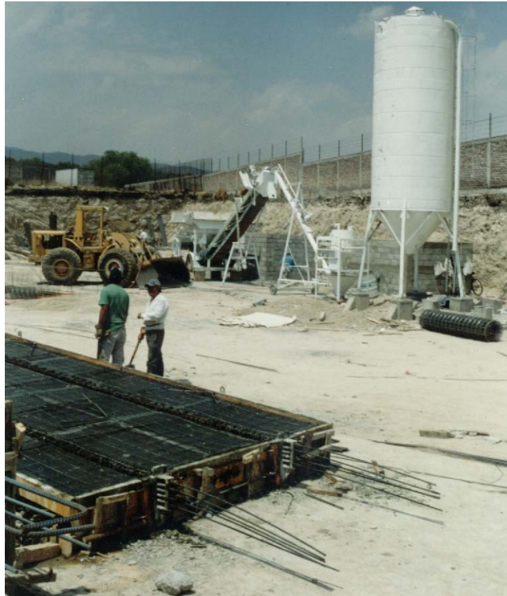
IV.3.2. Torones pretensados.
