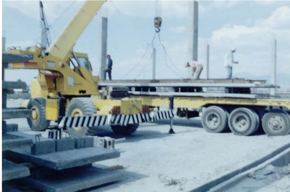
V.5.2. Zona de almacenaje y colocación de muros en trailer de transporte.
