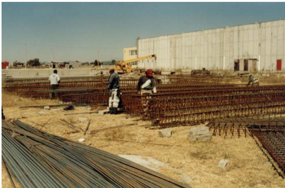
IV.1.1 Cuadrillas de tierreros habilitando armados
