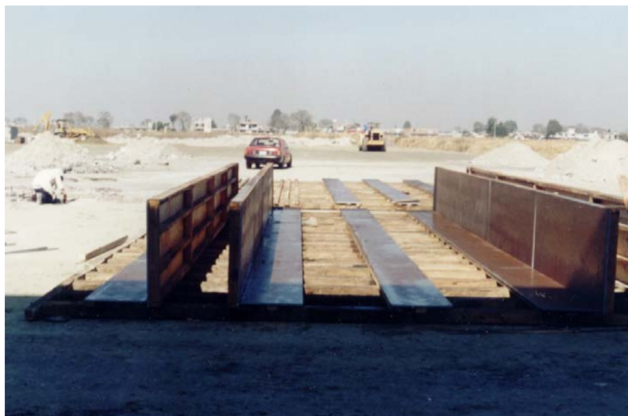
IV.1.5. Cimbra de madera para columnas de concreto
