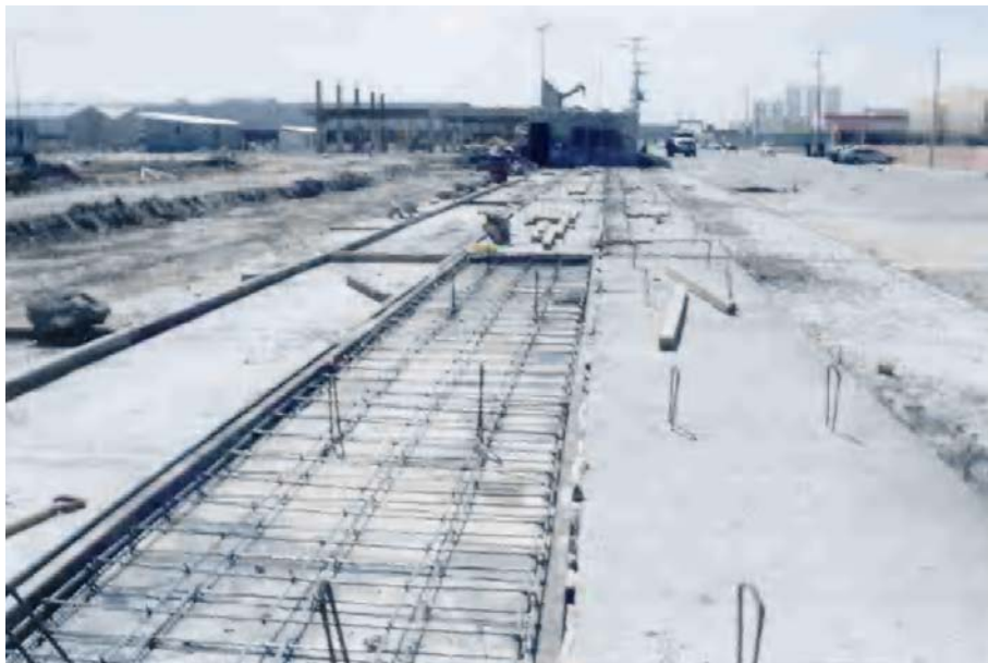
II.2.6 Muros de concreto reforzado colados de manera horizontal
