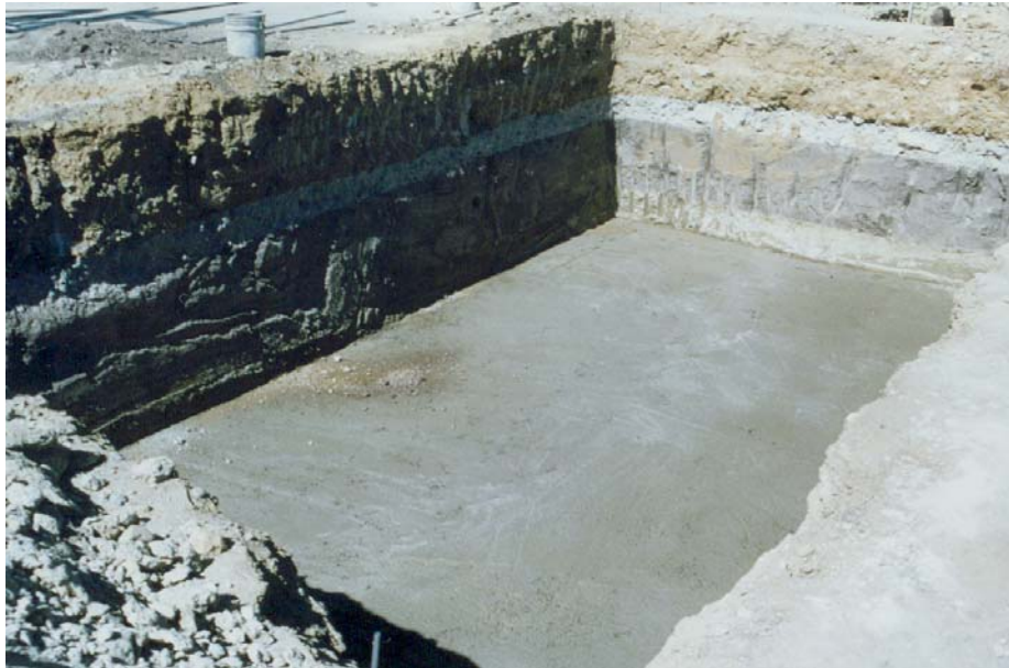
V.1.3. Capa de concreto pobre que evita contaminación de cimentación con materia orgánica proveniente del suelo.
