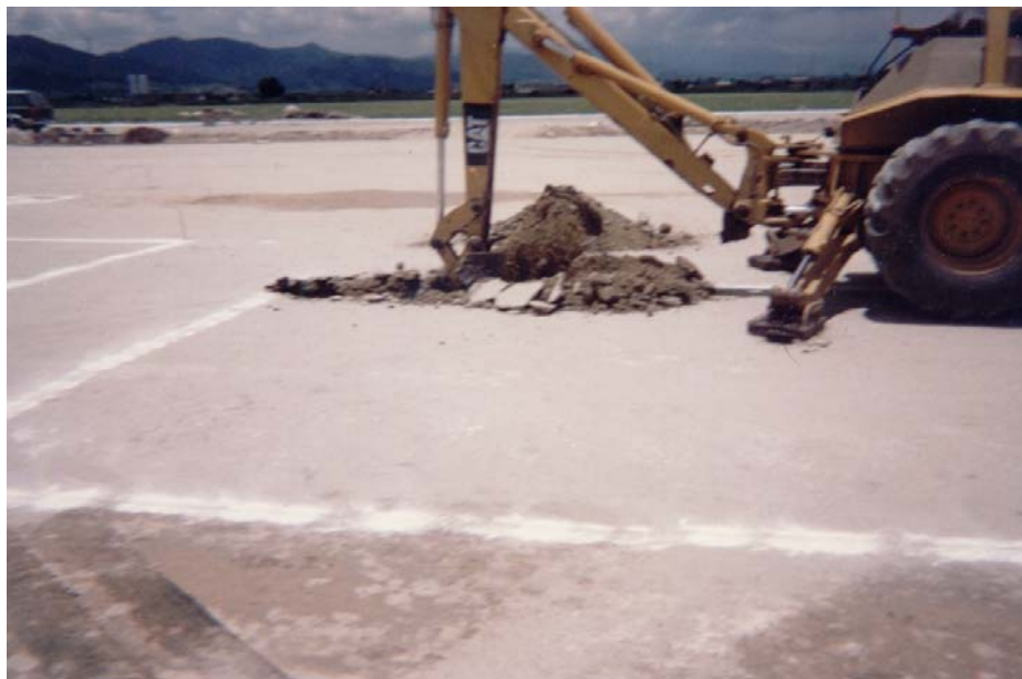
V.1.1. Trazo definido de la excavación y comienzo de esta.
