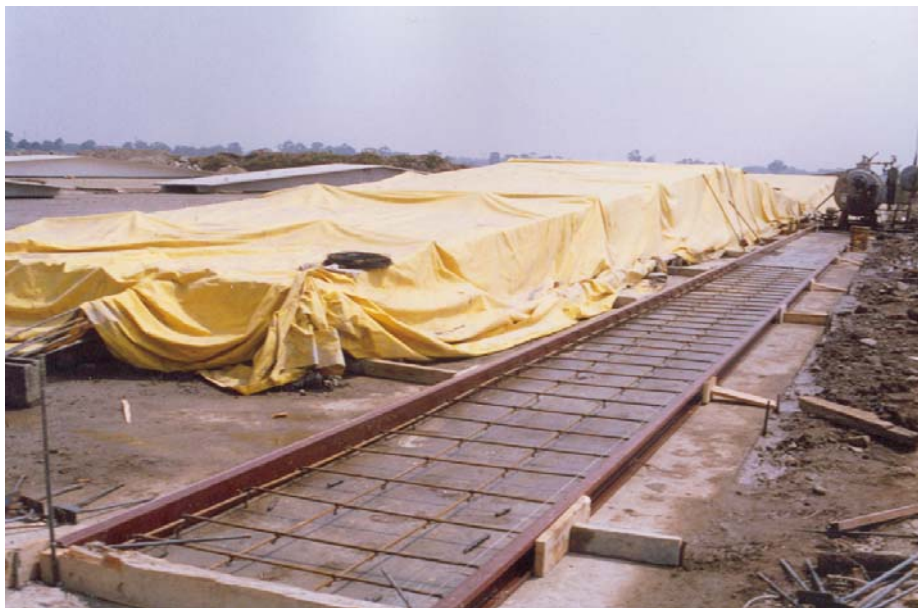
IV.1.7. Molde de muro de concreto.
