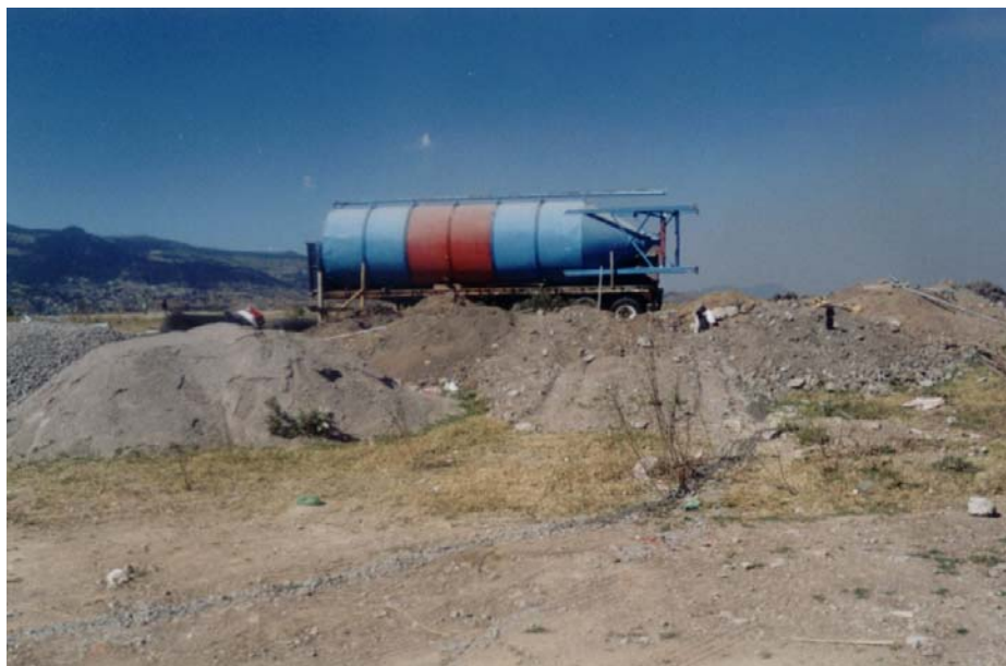
V.1.6. Transportación de silo a pie de obra.
