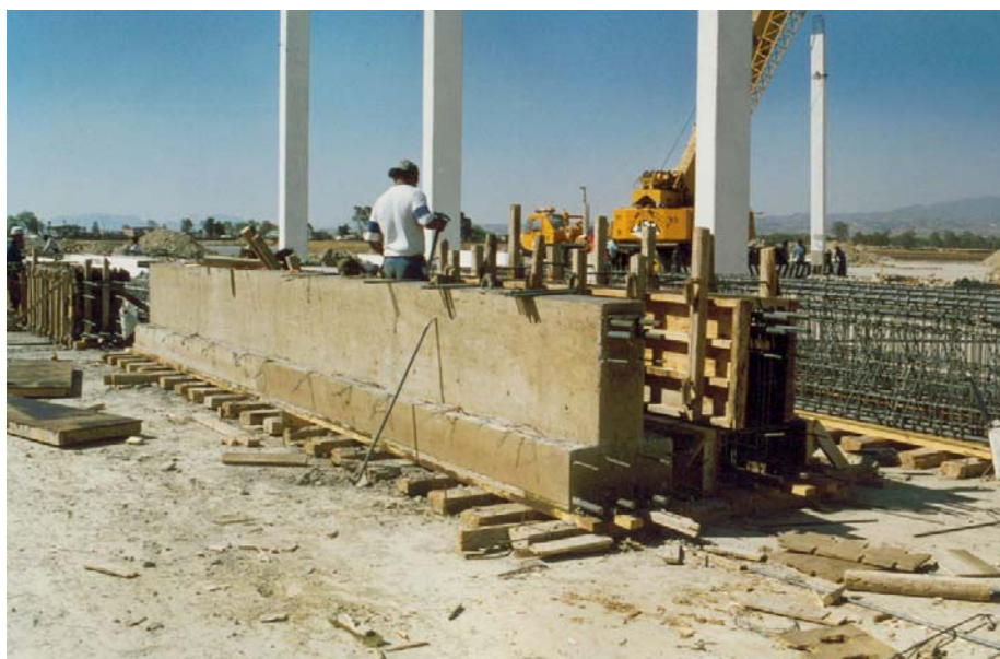
IV.2.3. Trabe portante colada y descimbrada
