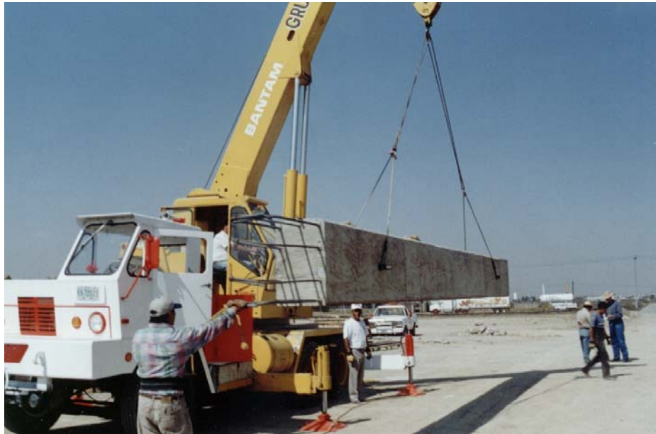
V.2.2. Columna tomada por la grúa.
