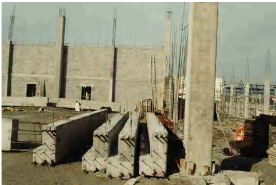
II.2.3 Travesaños perimetrales en forma de L armadas, cimbradas y coladas en sitio
