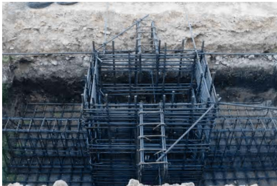
II.2.4 Colocación y armado de zapata y dado
