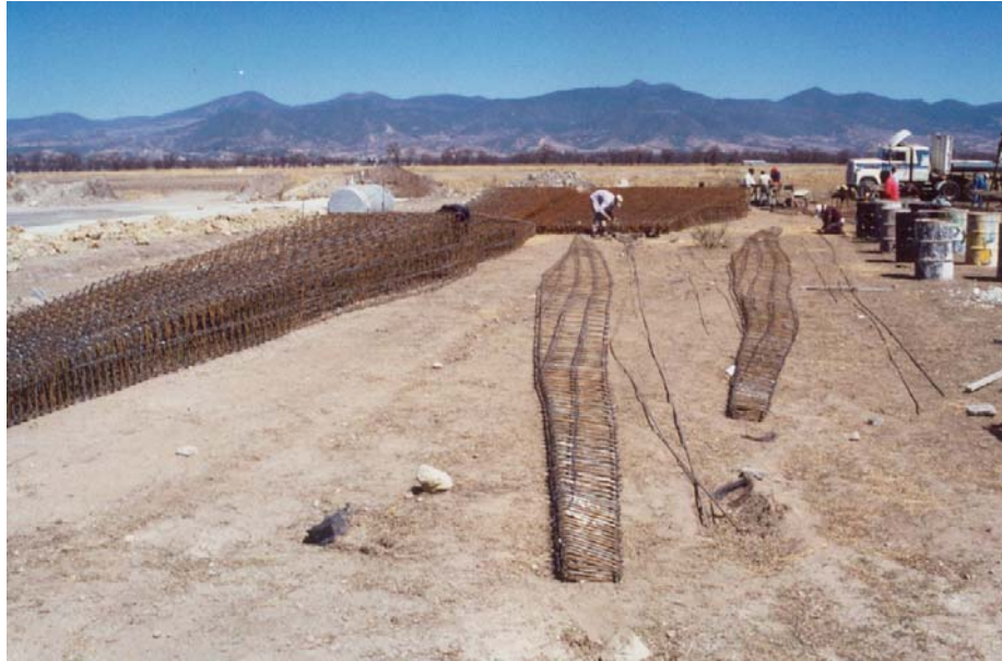
IV.1.2 Armados de nervaduras de doble t
