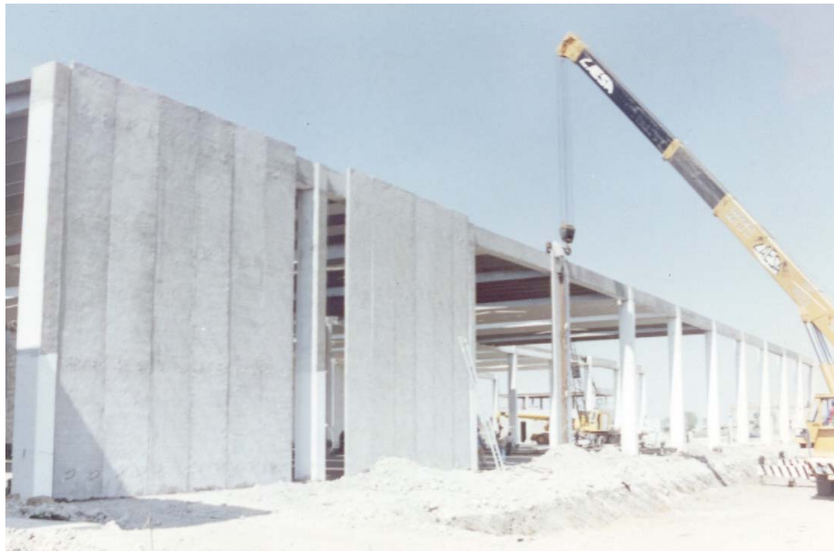
V.5.3. Montaje de muros.
