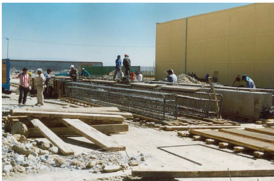
IV.1.3. Armados de columnas
