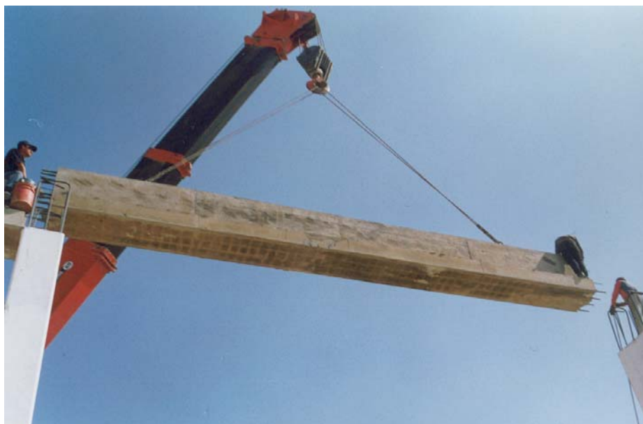
V.3.3. Montaje de traves en columnas.
