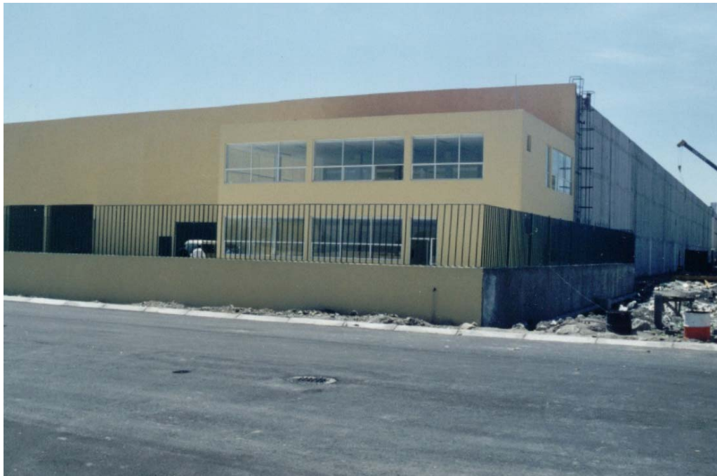
V.5.8. Acabado exterior de la nave.
