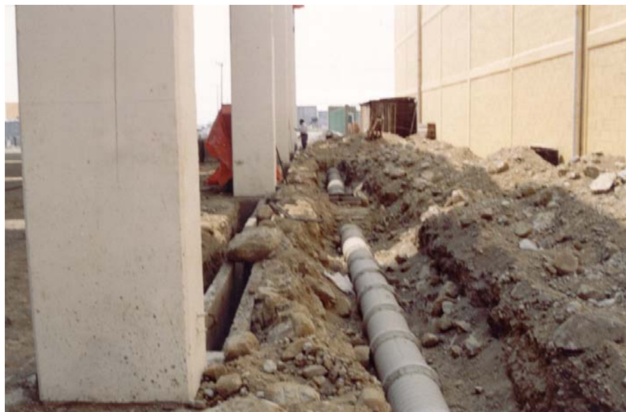
II.4.2. Colocación de tubería de asbesto-cemento
