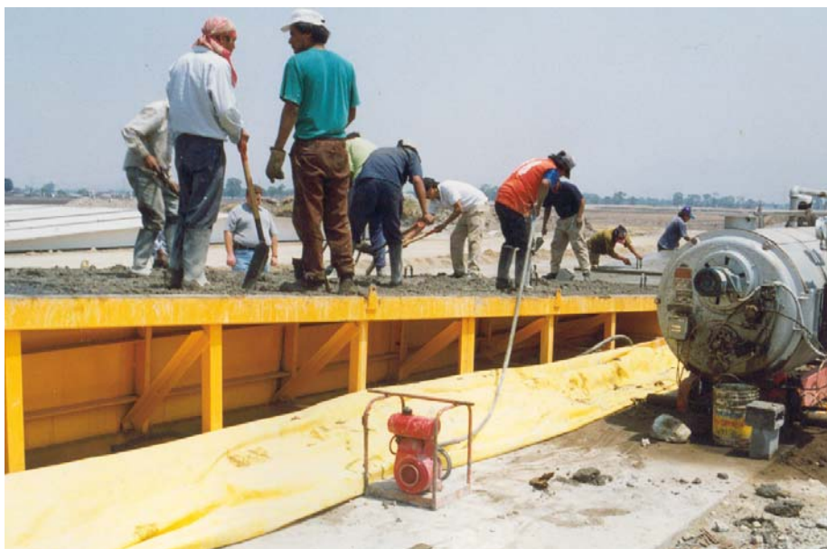
IV.2.5. Colado en sitio. Colocación y vibrado del concreto
