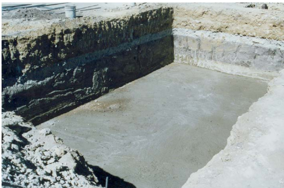
IV.2.1. Firme de concreto pobre
