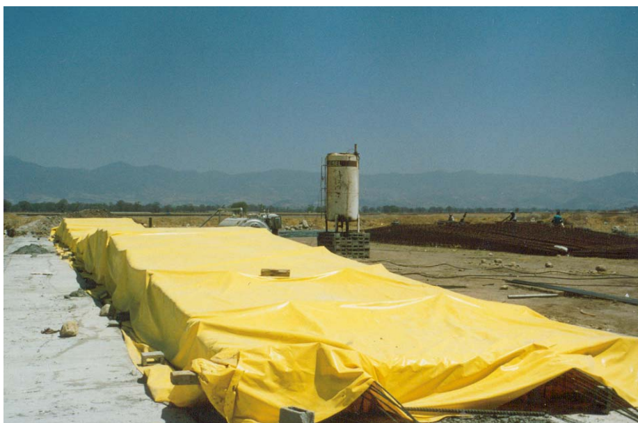
IV.4.1. Doble T cubierta para inicio de proceso de curado.
