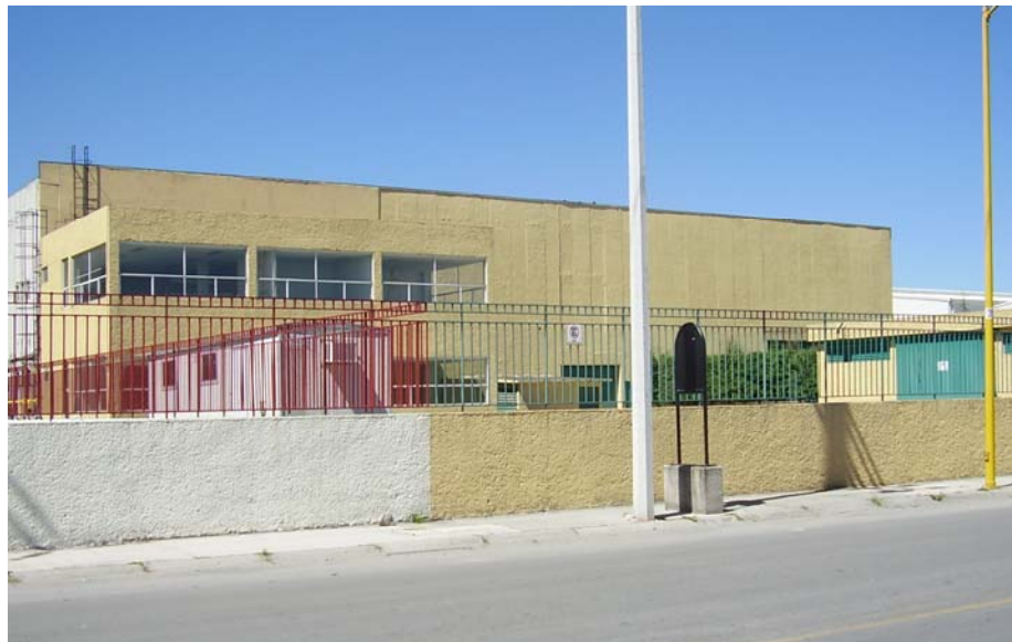
VII.3. Nave terminada.
