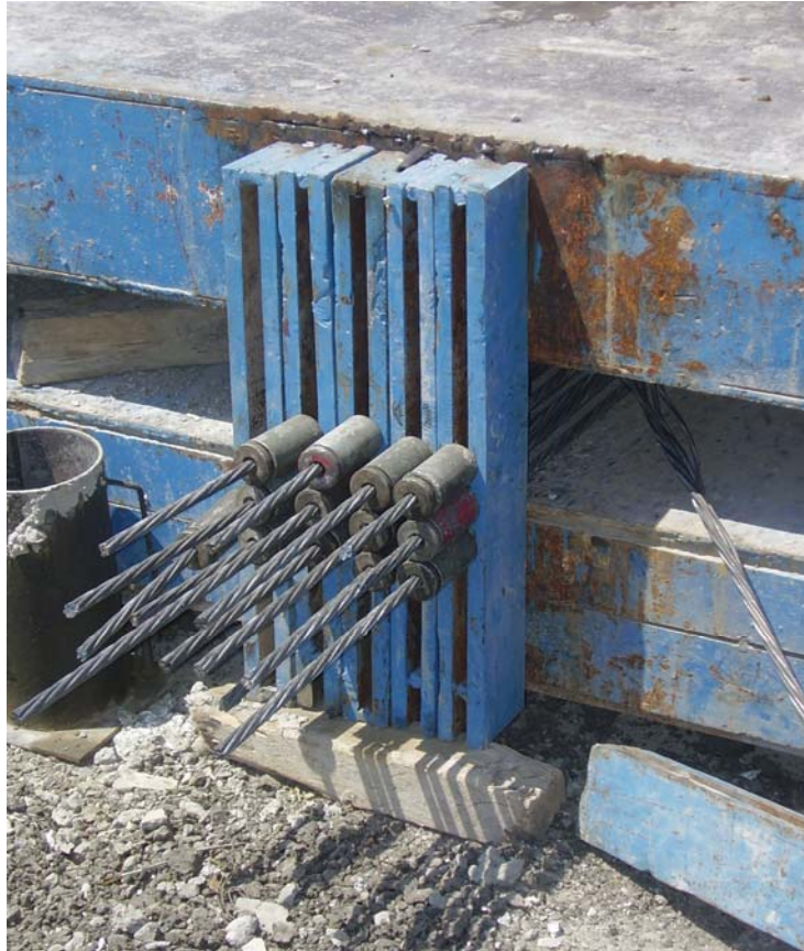
IV.3.3. Torones pretensados.
