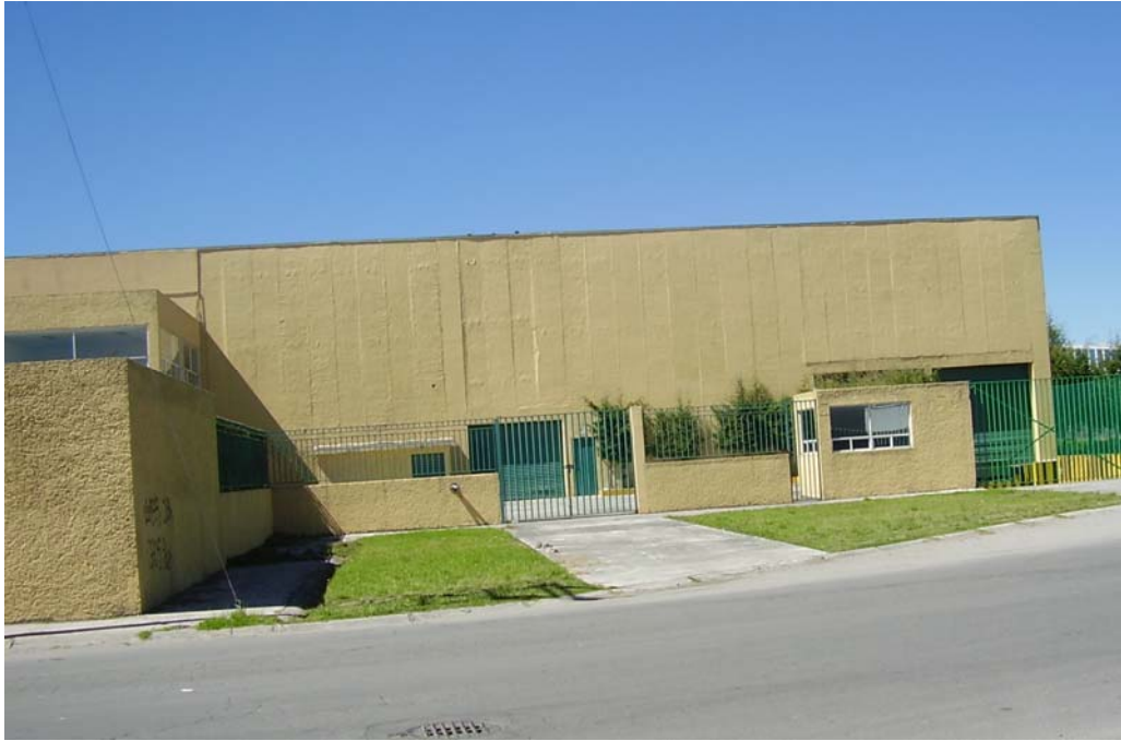
V.5.9. Acabado final de nave.
