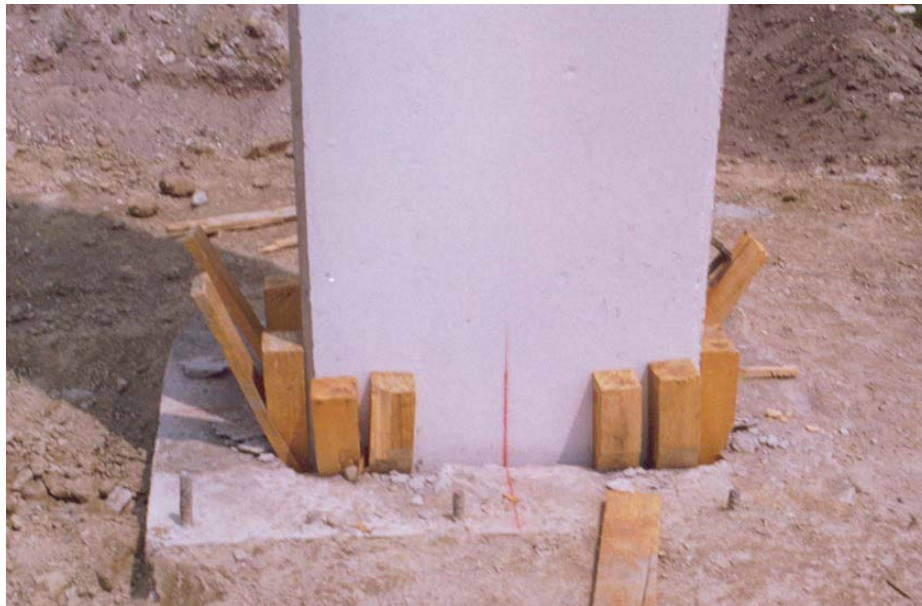
V.2.7. Nivelación de columnas.
