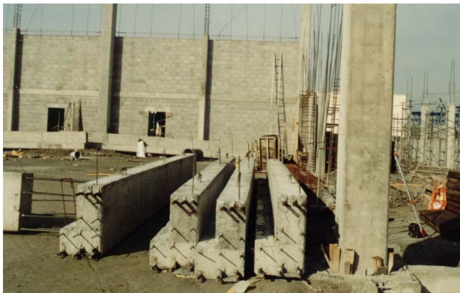
V.3.1. Zona de almacenaje de traves portantes.
