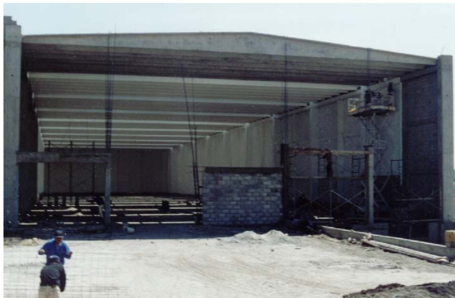
V.4.8. Losas montadas.
