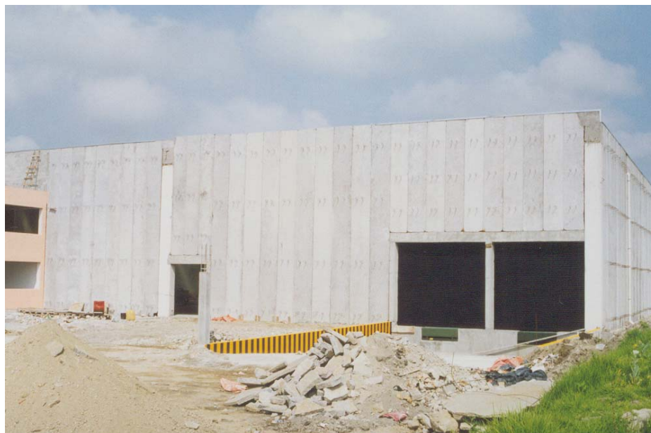
V.5.4. Muros completamente montados.
