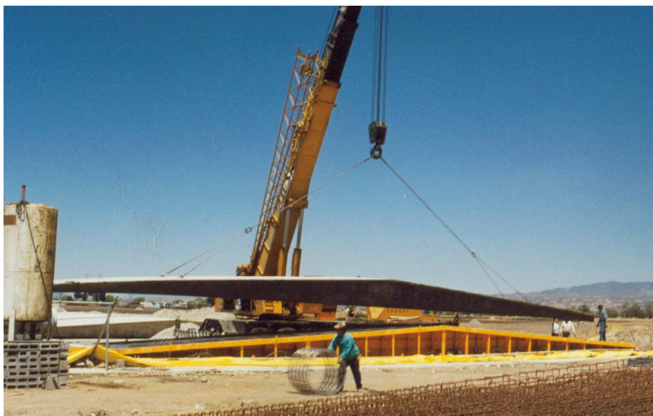
V.4.2. Descimbrado de losas.
