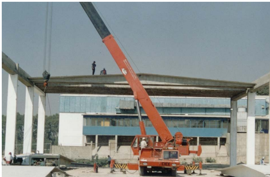
V.4.6. Montaje de la losa con 1 grúa.
