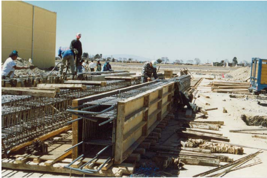
IV.1.6. Cimbrado de columnas
