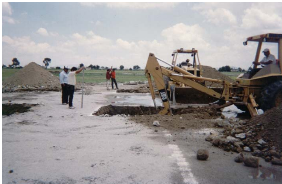
II.3.5 Equipo utilizado para llevar a cabo la estabilización del terreno
