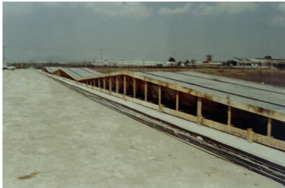
IV.1.9. Molde para losa doble t.
