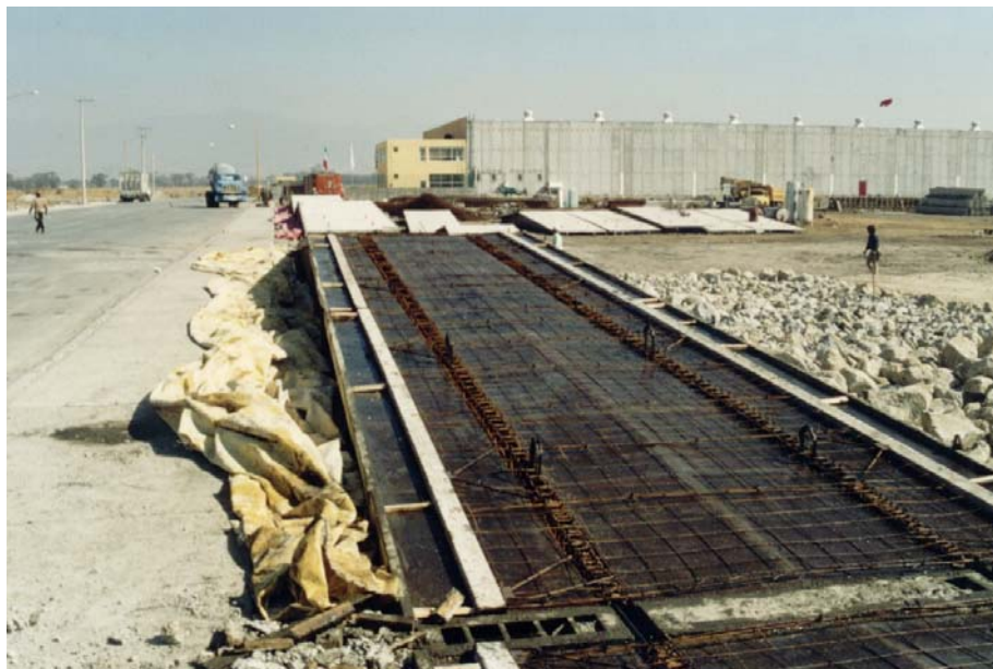
IV.1.10. Molde para losa doble t.
