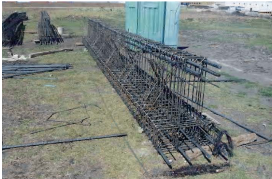
IV.1.4. Armado de trabe tipo ménsula
