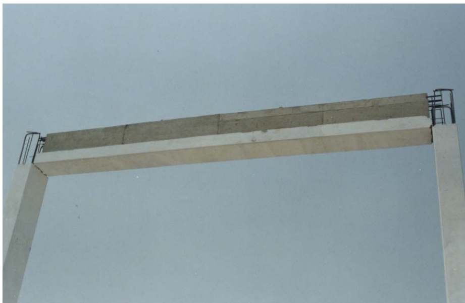
V.3.4. Columna montada (simplemente apoyada).
