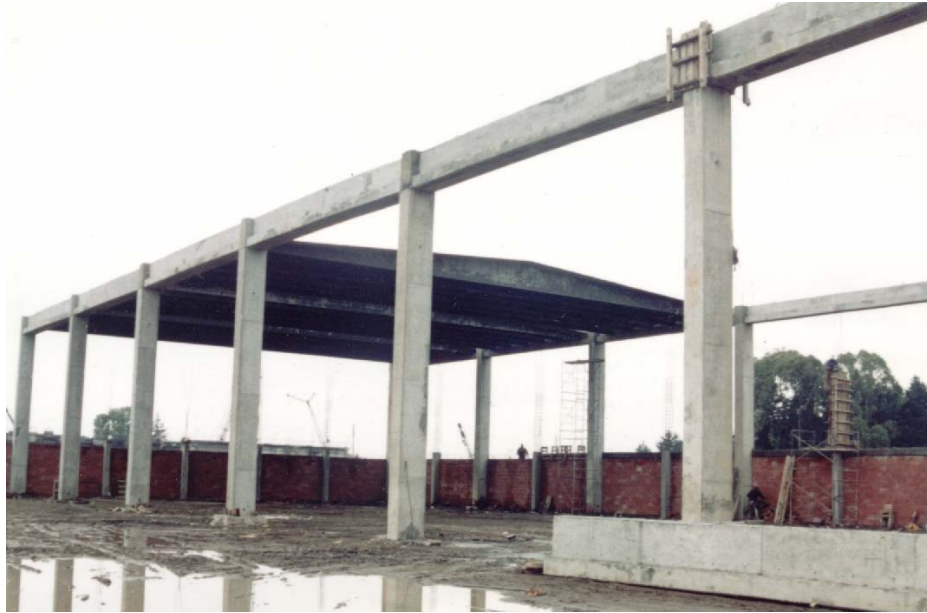
V.3.6. Cimbrado de nudos.
