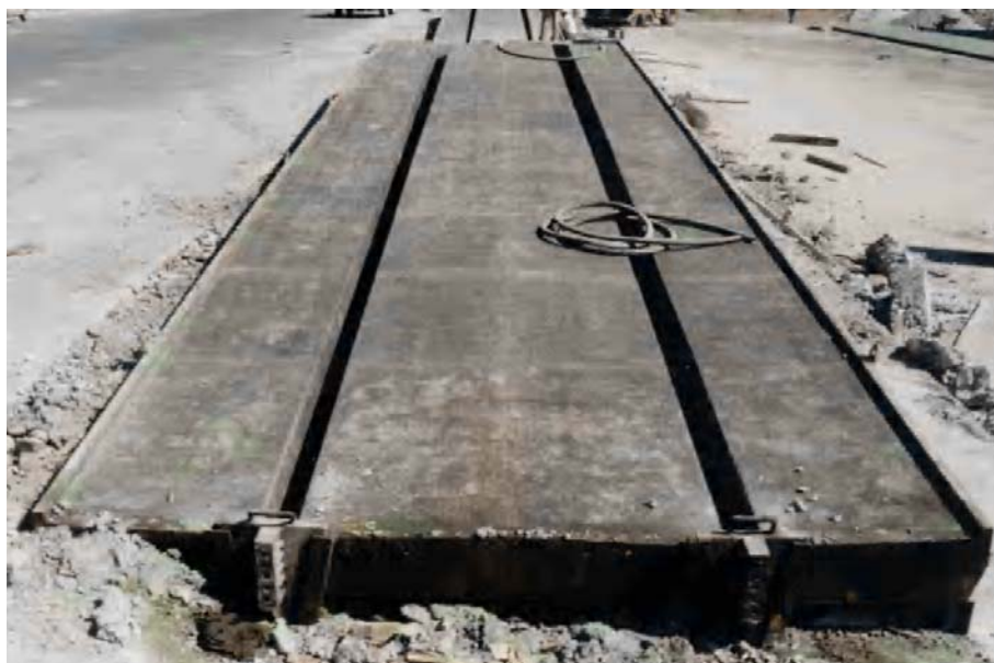
II.2.1 Molde de losa doble T, se observan en la parte inferior los cartabones. También se aprecia la variación en la longitud de las nervaduras
