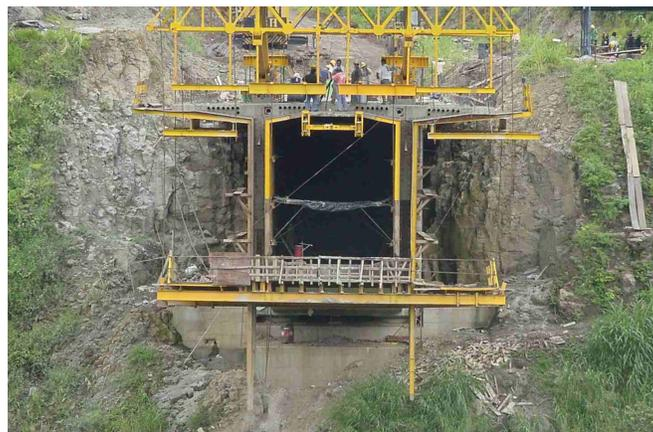
Figura III.43.- Arreglo de los ductos para los cables de tensado.
