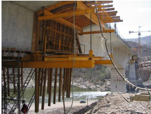
Figura III.44.- Fabricación de la dovela de cierre.
