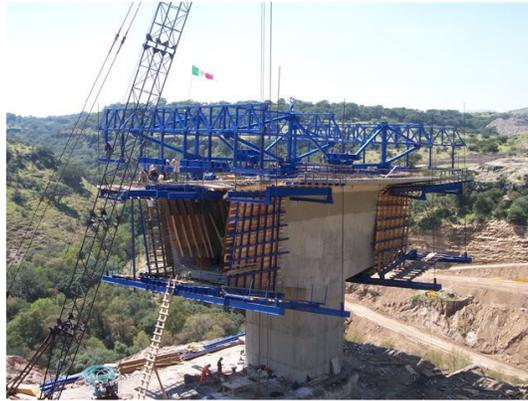
Figura II.17.- Dovela de pila. Cortesía de Freyssinet de México.
