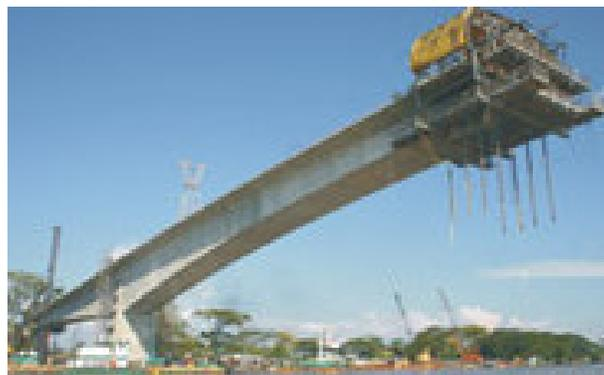
Figura III.31.- Construcción de un puente en doble voladizo.
