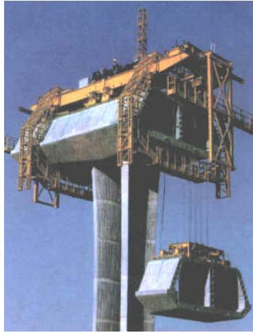
Figura III.3.- Construcción en voladizo usando piezas prefabricadas.
