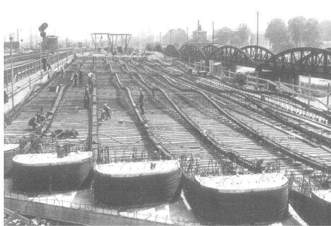
Figura III.19.- Arreglo de los cables de presfuerzo del sistema Baur-Leonhardt.
