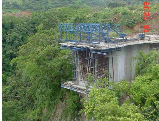
Figura III.42.- Dovela de estribo.
