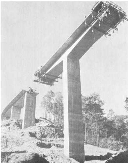
Figura I.35.- Construcción del puente Totolapa.
