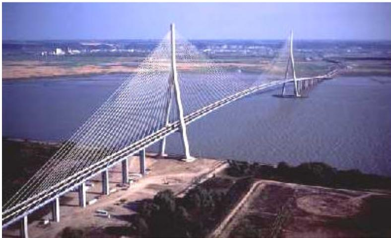
La superestructura comprende todos los componentes que se encuentran por encima de los elementos de soporte como son: superficie de rodamiento, sobre la cual circulan los vehículos, puede ser de asfalto o de concreto; losa, cuya función principal es la de distribuir las cargas transversal y longitudinalmente en toda la longitud del puente; y finalmente las vigas, que son los miembros principales del puente y se diseñan para resistir el trabajo a flexión ocasionado por el tránsito de vehículos.
