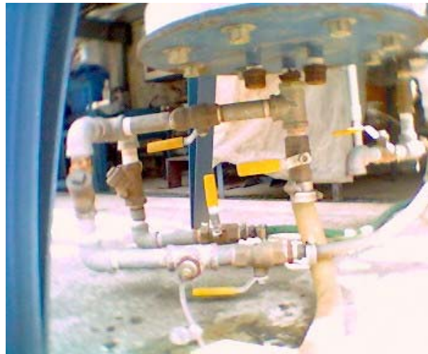
Figura 3.14. Sistema de alimentación de agua para retrolavado.
