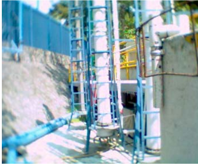
Figura 3.18. Aislante de polietileno de baja densidad en todo el biofiltro.
