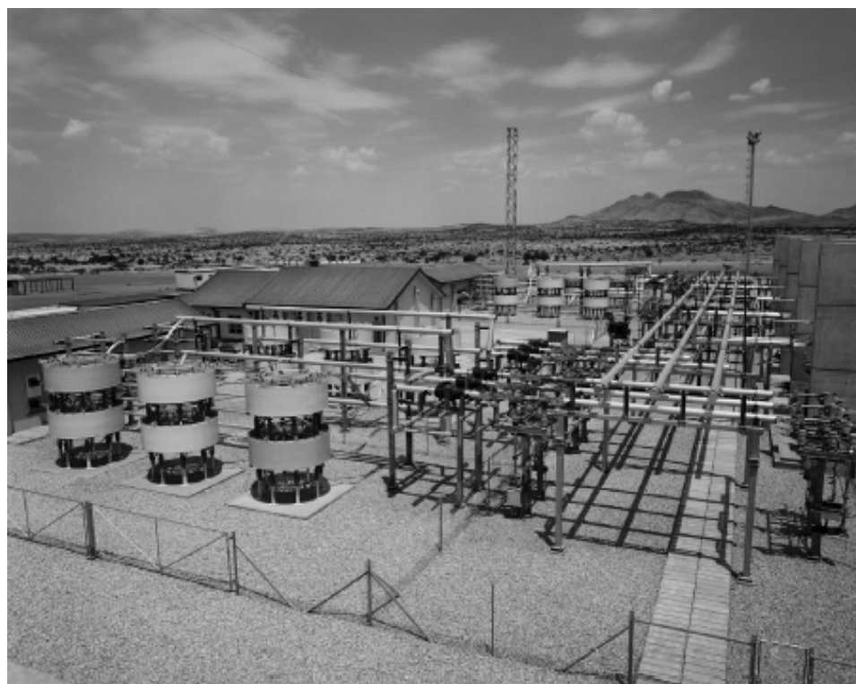
Vista General de un Compensador Estático de VARs
