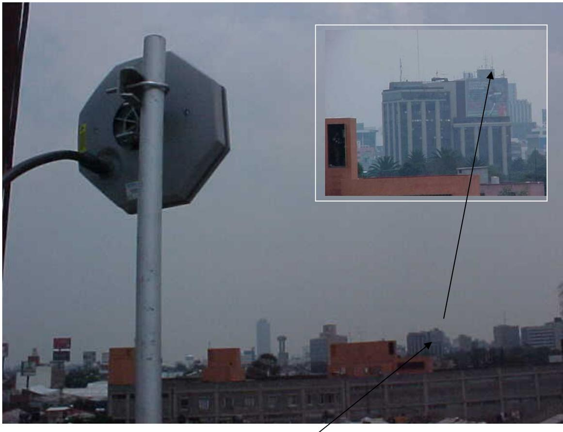
Figura IV.9: Antena Espejo que va Arriba con Línea de Vista a la RBS.
