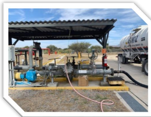
Figura VI.19; Fotografía instalaciones durante la descarga.
