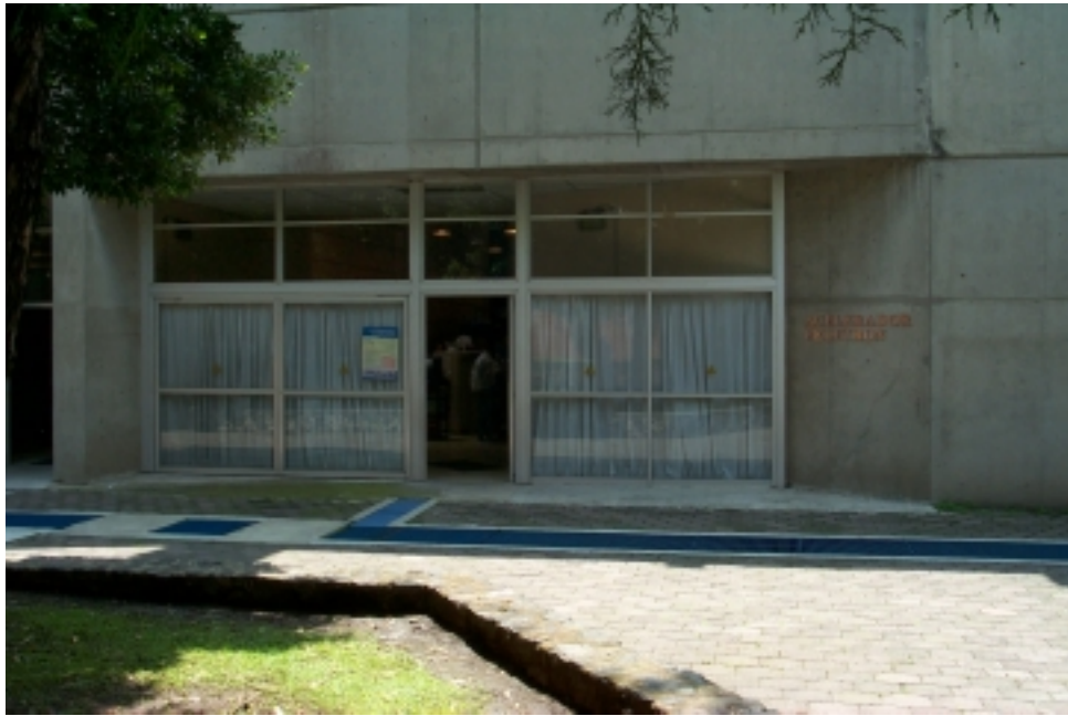
Fig. 4.3 FACHADA DEL PELETRÓN
