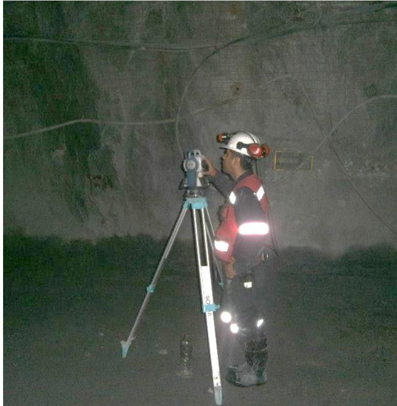
Ilustración 15 Levantamiento de puntos por parte de topografía.
