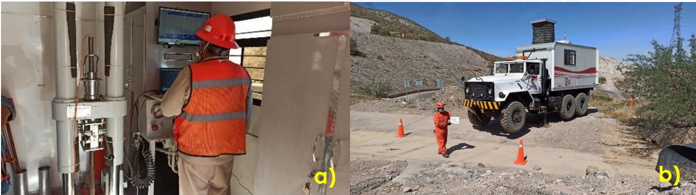
Figura 5.2 a) Observación de parámetros durante el hincado del cono/ b) Camión Hysson para hincado de cono.
