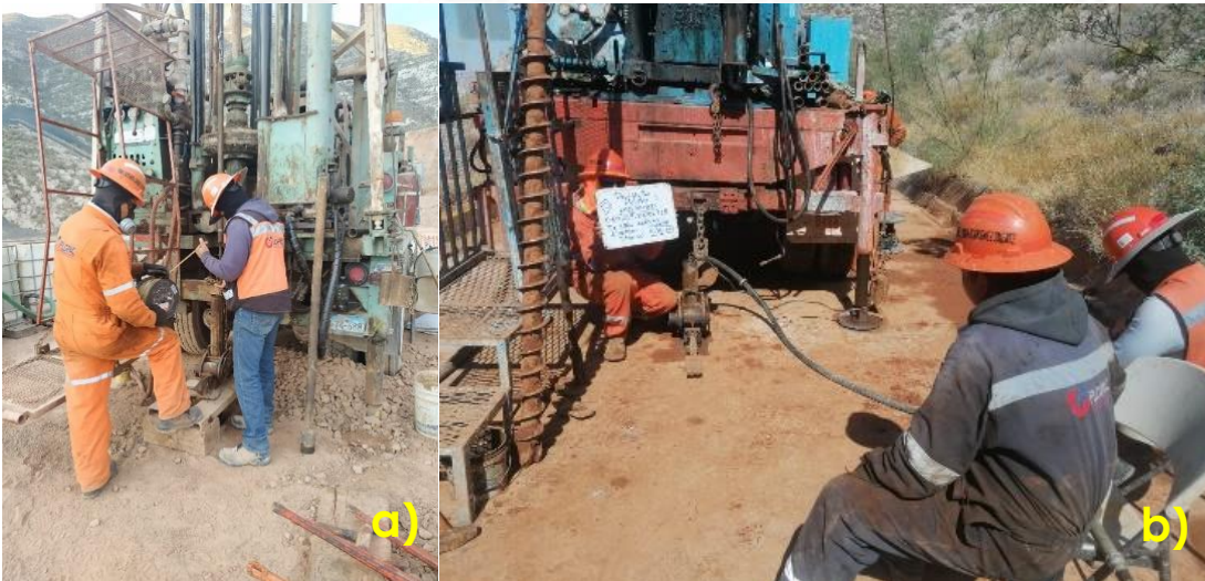
Figura 5.8 a) Medición de profundidad del barreno para evitar azolve/ b) Registro de lecturas.
