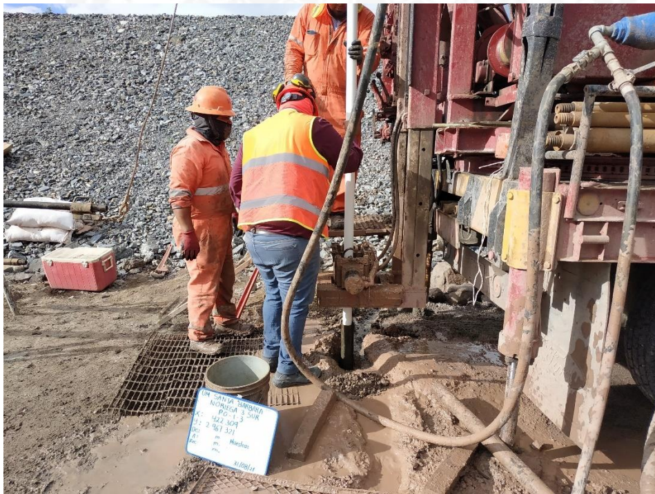
Figura 5.13 Instalación de tubería para pozos de observación.
