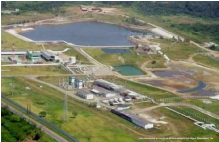
Figura 5.2.1. Centro de Almacenamiento Estratégico (CAE) Tuzandépetl. Imagen de (Loredo, 2021) recuperado el 25 de febrero de 2023
