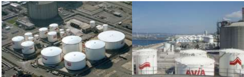
Figura 2.3.1. Terminal de almacenamiento de hidrocarburos. Imagen obtenida de (Heymo Ingeniería, s.f.).
