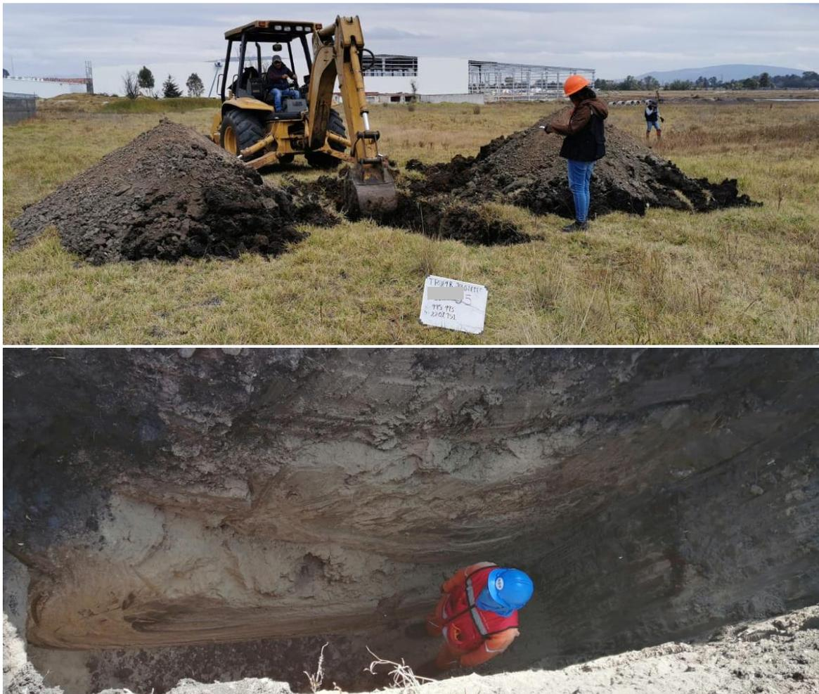
**Figura 3.2. Ejecución de pozos a cielo abierto.**
