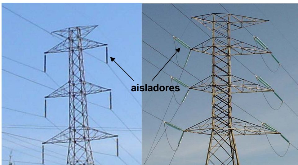
Figura 5.1 Aisladores eléctricos para líneas aéreas.
