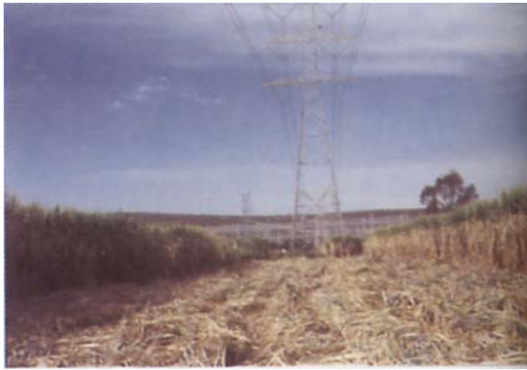
Figura 3 Corte de caña en verde bajo líneas de 400 kV antes de la quema de parcela e instalación de bandas de protección del aislamiento contra contaminación por excremento de aves para evitar salidas de la línea.
