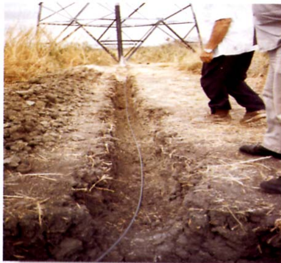
Figura 7.7 Mejoramiento de sistema de tierras en la línea de transmisión de 230 kV Escarcega-93010-Ticul [4].
