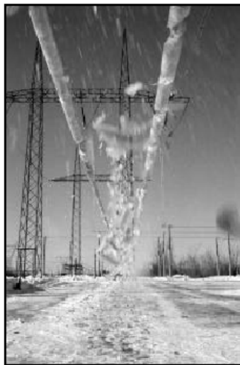
Figura 5.5 Nieve en un conductor.
