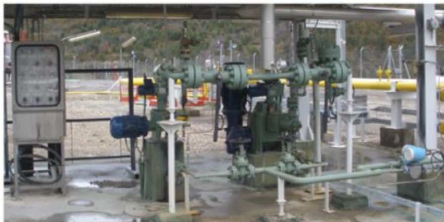
Figura 85. Sistema de inyección de metanol en Serrablo (Enagas, 2020).
