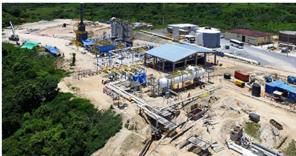
Figura 57. Central de almacenamiento por CYDSA, (CYDSA, 2022)
