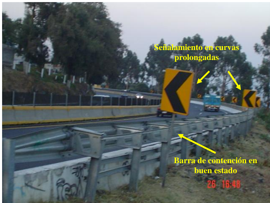
Figura 1.15 Obras de protección y señalamiento preventivo en curvas prolongadas
