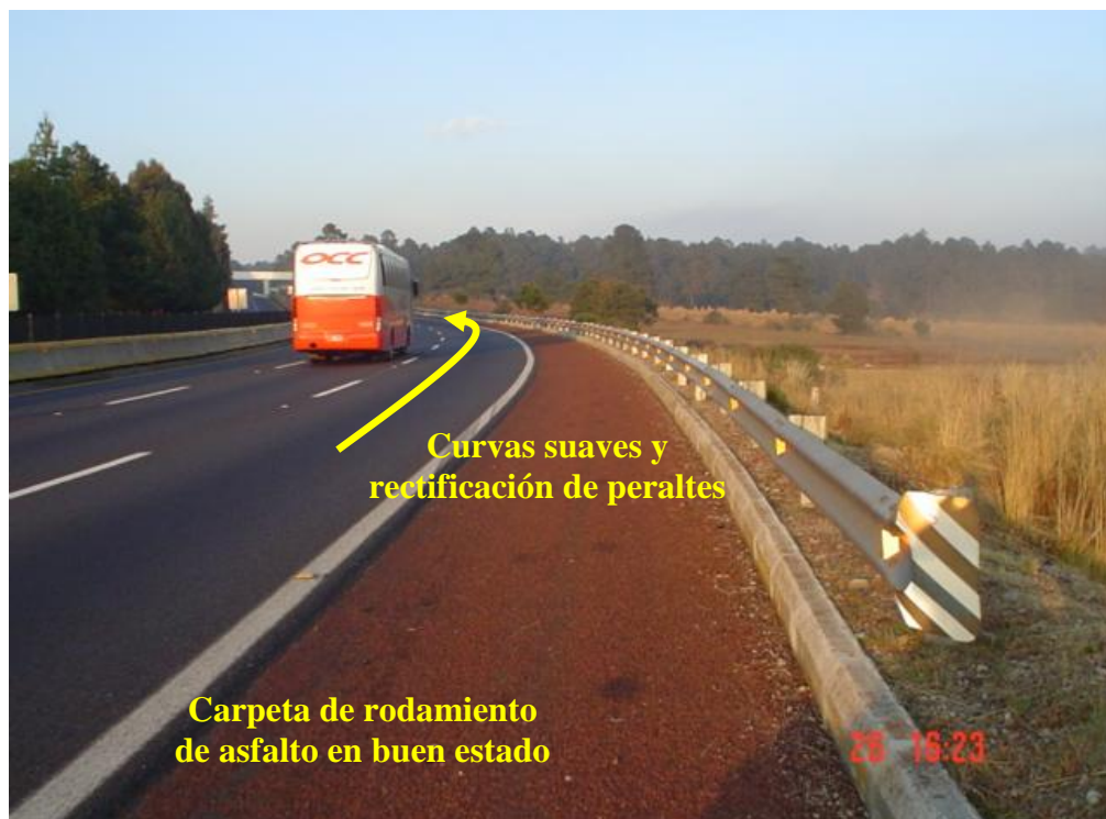
Figura 1.14 Vista del trazo y del estado de la superficie de rodamiento
