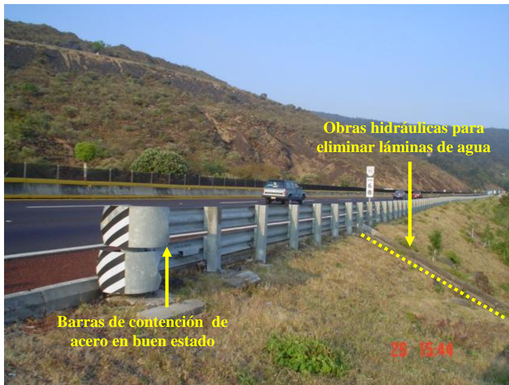
Figura 1.13 Mejoramiento de las obras de protección (barras de contención) e hidráulicas
