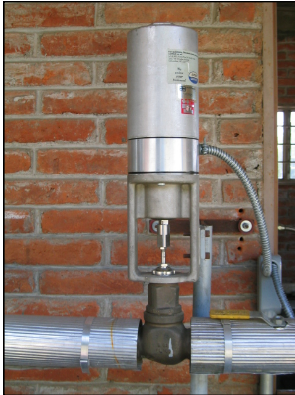
Figura 4.36. Montaje de la válvula de apertura proporcional.
