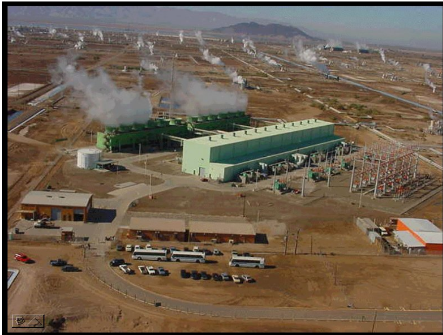
Figura 5.17. Planta geotérmica de Cerro Prieto.
