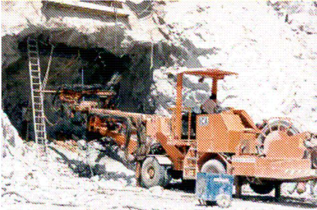
**Figura 5.12 Proceso inicial de excavación de las bocatomas**
