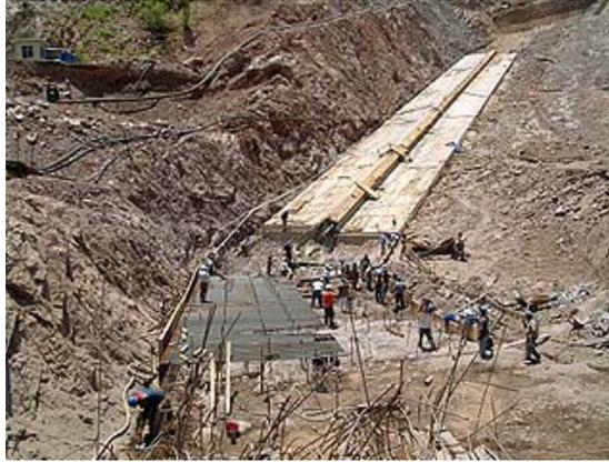
Fig. 5.15 Construcción del Plinto (tomado de la construcción del C.H. El Cajón.- CFE)
