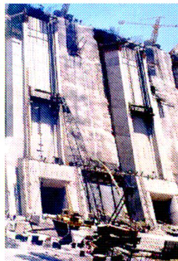
**Figura 5.9 Revestimiento de concreto armado bocatomas y torres de compuertas**
