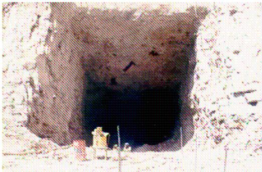
**Figura 5.13 Excavación del tramo bocatoma -transición -codo superior**
