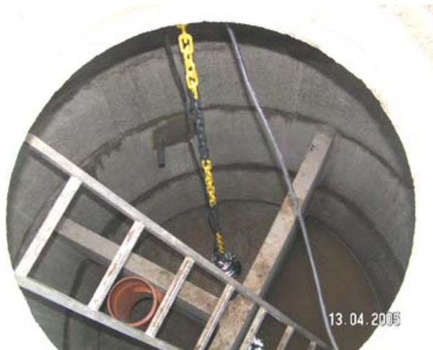
**Fig.4.7:** Montaje de la bomba en la tercera cámara de sedimentación. (Foto propia)
