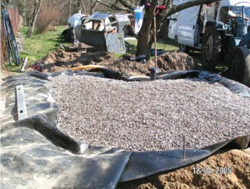
**Fig. 4.16:** Tendido y nivelación de la capa superior de grava. (Foto propia)
