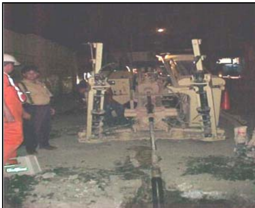
FOTOGRAFÍA V.9 “PERFORACIÓN DIRECCIONAL”
