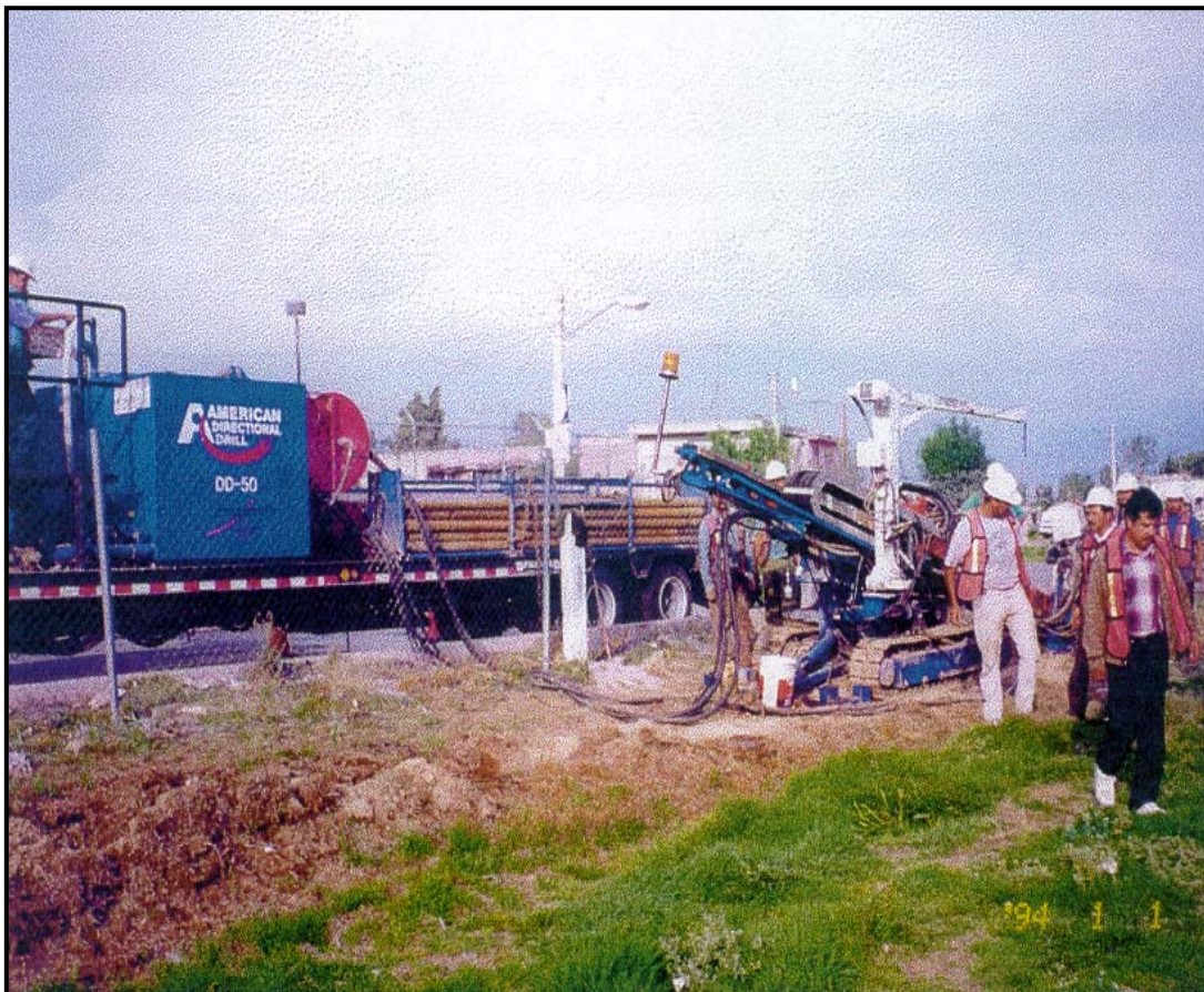
FOTOGRAFÍA V.41 “PERFORADORA DIRECCIONAL”
