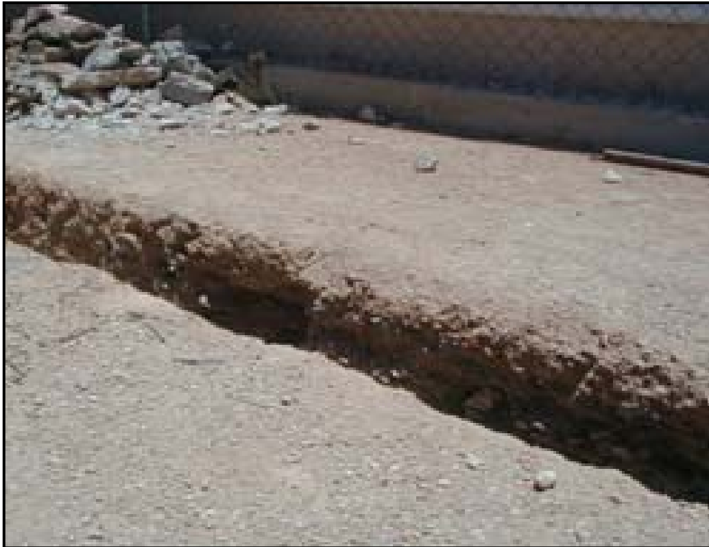
FOTOGRAFÍA V.28 “EXCAVACIÓN DE CEPA”
