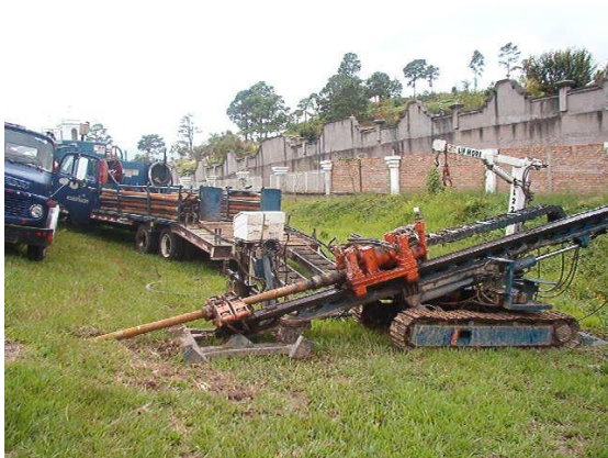
Realizando perforaciones horizontales
