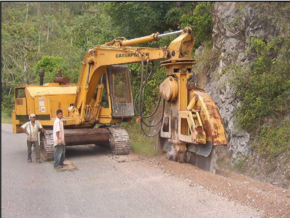
FOTOGRAFÍA VI.3 “CORTADORA DE DISCO PARA HACER ZANJA”
