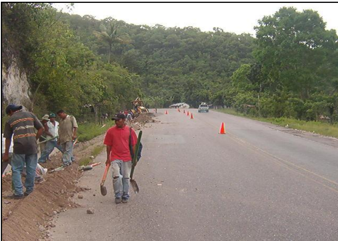
FOTOGRAFÍA VI.1 “MANO DE OBRA UTILIZADA PARA ZANJEAR”
