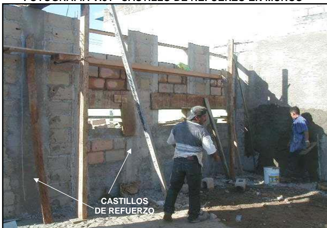
FOTOGRAFÍA V.31 "CASTILLO DE REFUERZO EN MUROS"
