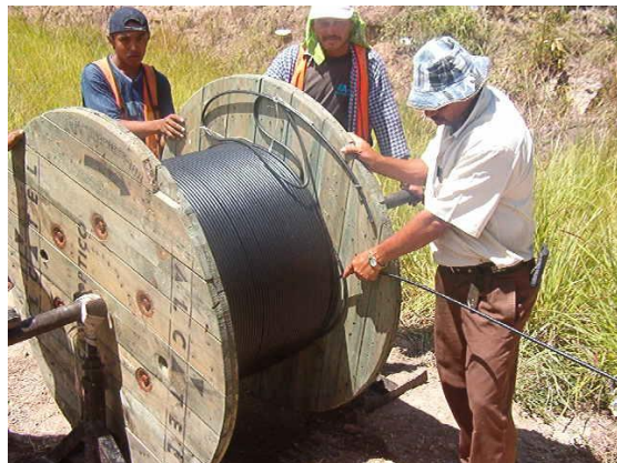
Inmersión de Cable de Fibra Óptica
