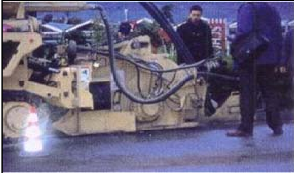
FOTOGRAFÍA V.18 “LUCES LUCUADORAS DE SEGURIDAD”
