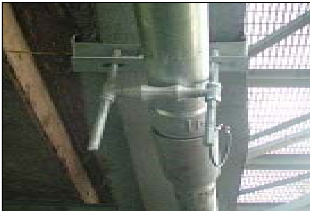
FOTOGRAFÍA V.8 “JUNTA DE EXPANSIÓN Y HERRAJE DE COLUMPIO”
