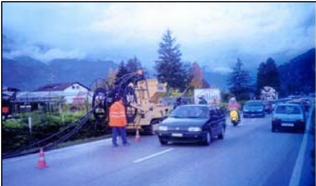
FOTOGRAFÍA V.17 “SEÑALIZACIÓN EN DERECHO DE VIA”
