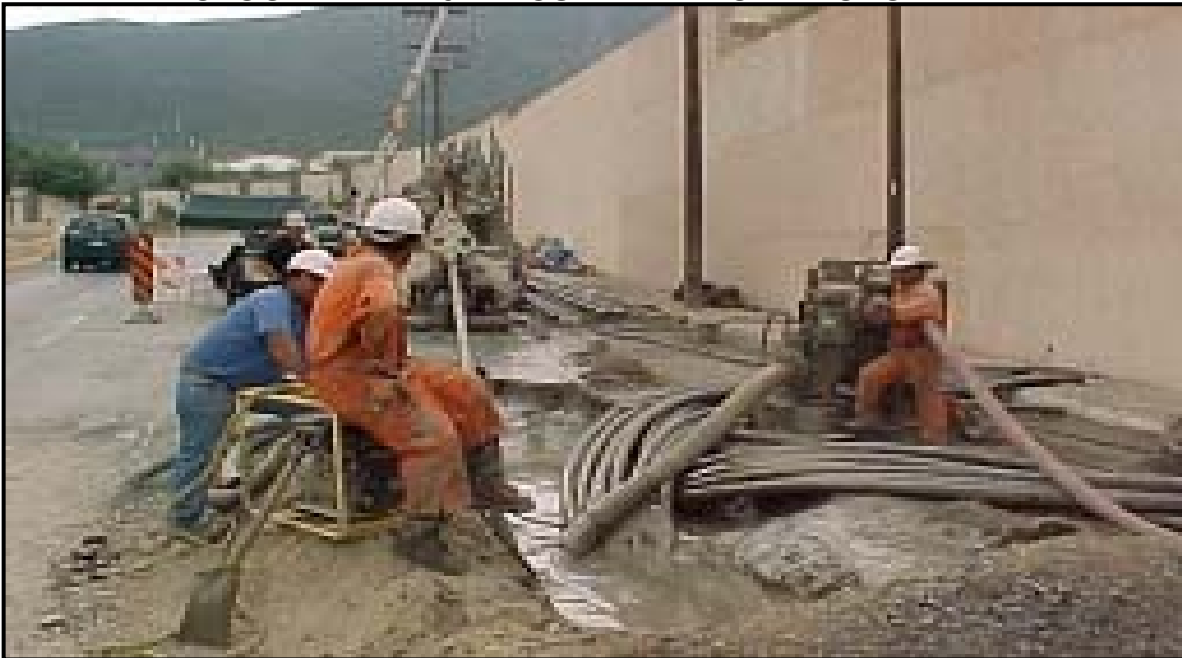
FOTOGRAFÍA V.10 “RECUBRIMIENTO DE TUBO HDPE”
