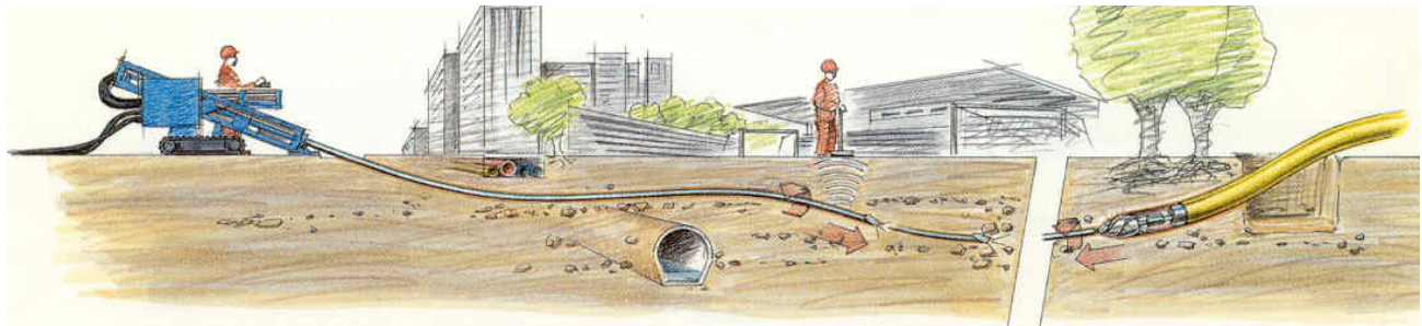
Fig. 4.- Instalación de tubería por medio de perforación direccional
