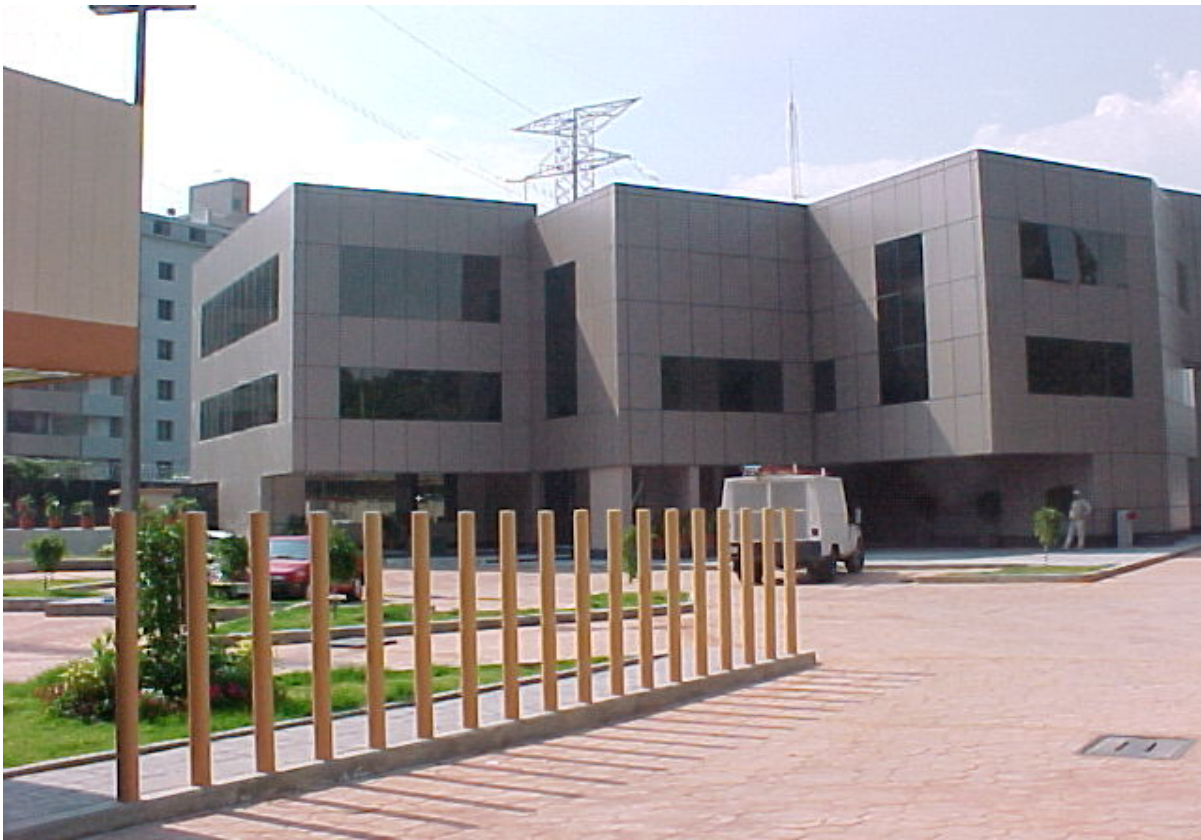
1 n).- Centro Operación Redes de Distribución Pedregal ( C.O.R.D.P. )
