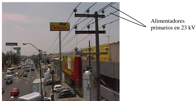
Fig. 2 f) Alimentadores primarios en 23kV.
