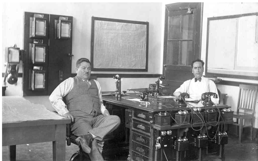
1 f).- Inicio de la operación de la red desde la planta de Nonóalco
