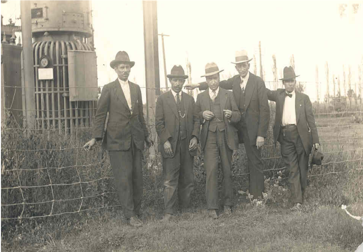
1 c).- Subestaciones tipo Kiosco
