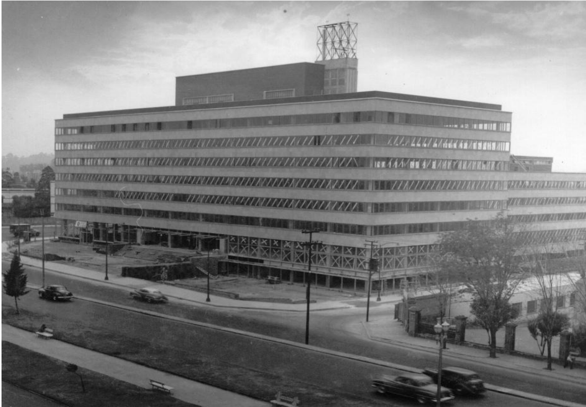
1 h).- Construcción del edificio Verónica
