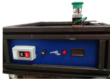
Figura E.9: Botón de paro de emergencia colocado.
