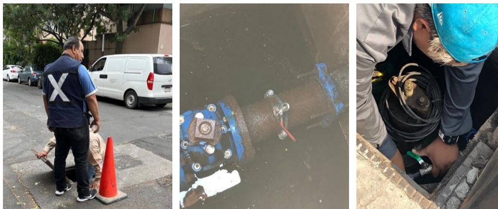
Figura 37. Apertura de registros de agua potable en el sector BJ-02 con el apoyo del personal de SACMEX.
