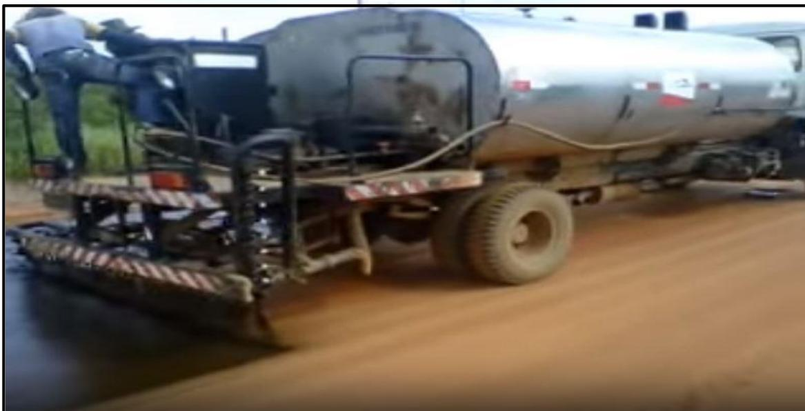
**Figura 80.** Colocación del Riego de impregnación
