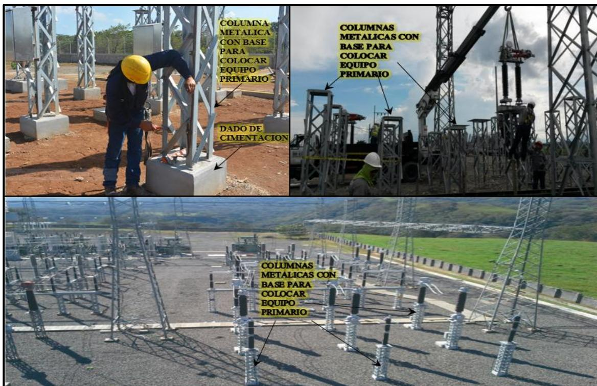
**Figura 4.** Estructuras Metálicas fabricadas con acero galvanizado
