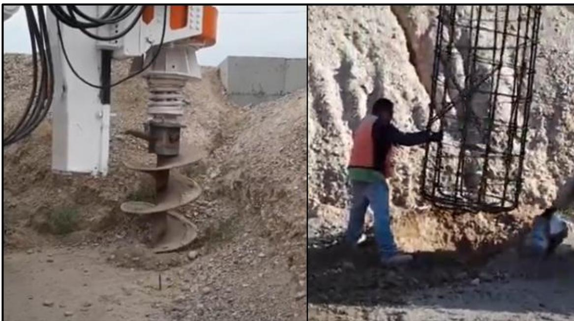
**Figura 20.** Perforación e intrucción del armado de pila para Cimentación
