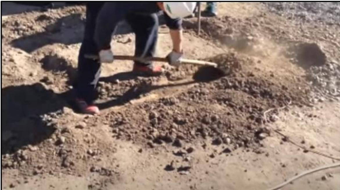
**Figura 61.** Excavacion para el tendido de Red de Tierra
