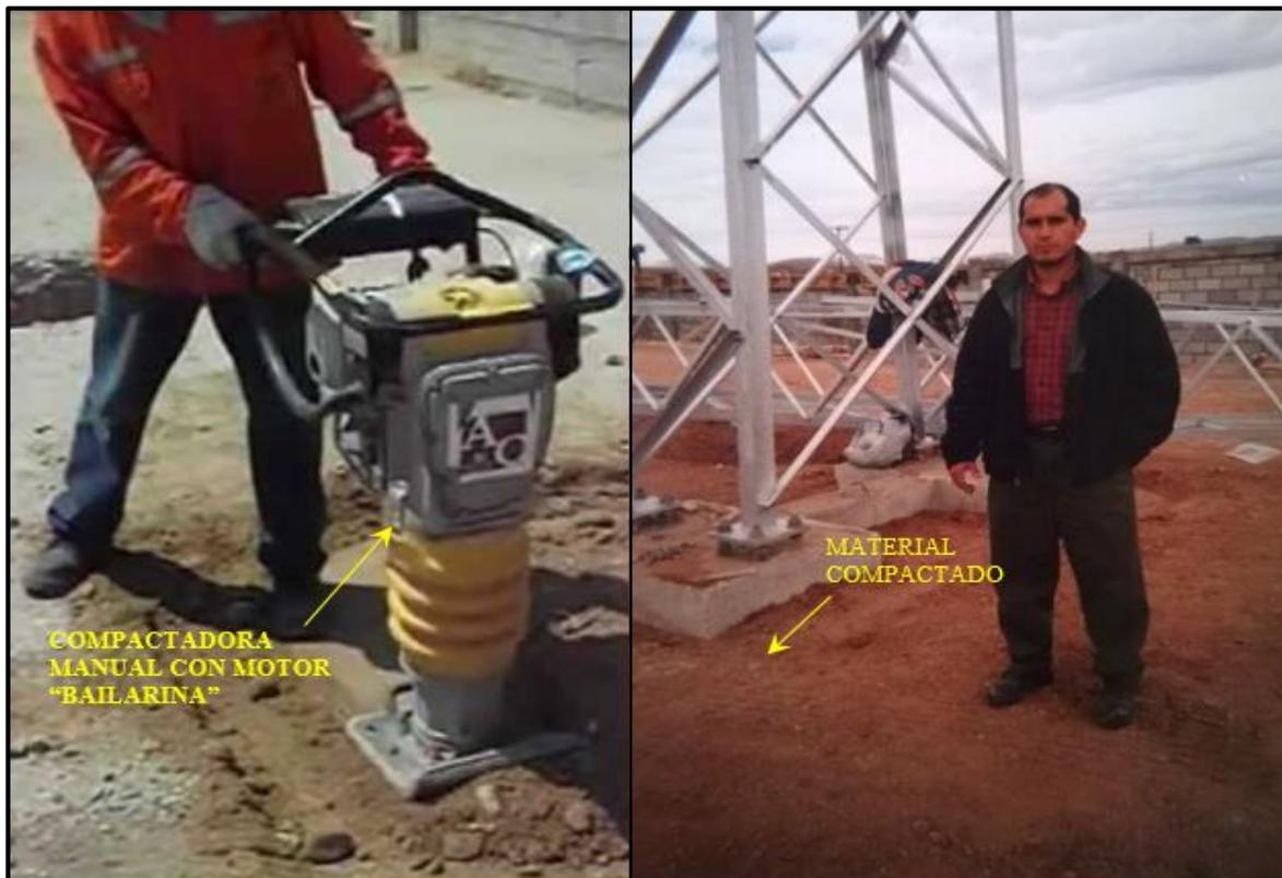
**Figura 39.** Relleno compactado en zanja donde se construyó Cimentación para Estructura Mayor
