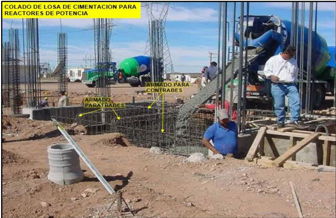
Figura 33. Colado de la losa de cimentacion para Reactores de Potencia
