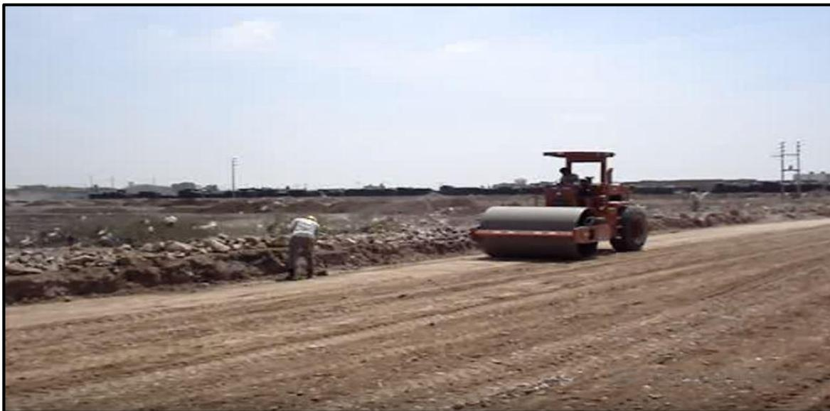
**Figura 12.** Compactación con rodillo mecánico
