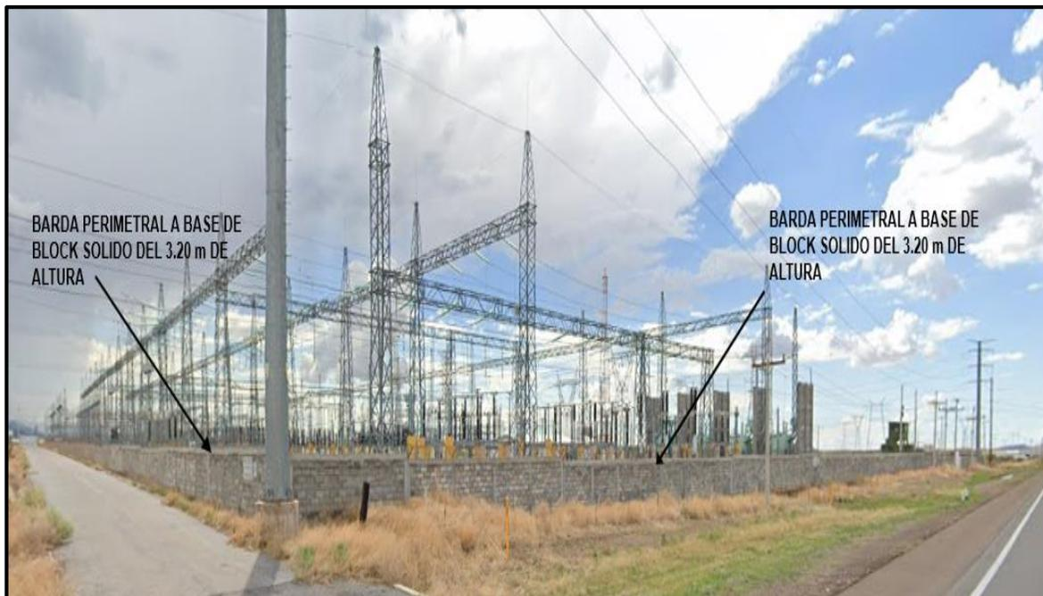
**Figura 27.** Barda perimetral de 3.20 m de altura desde el nivel de terreno natural
