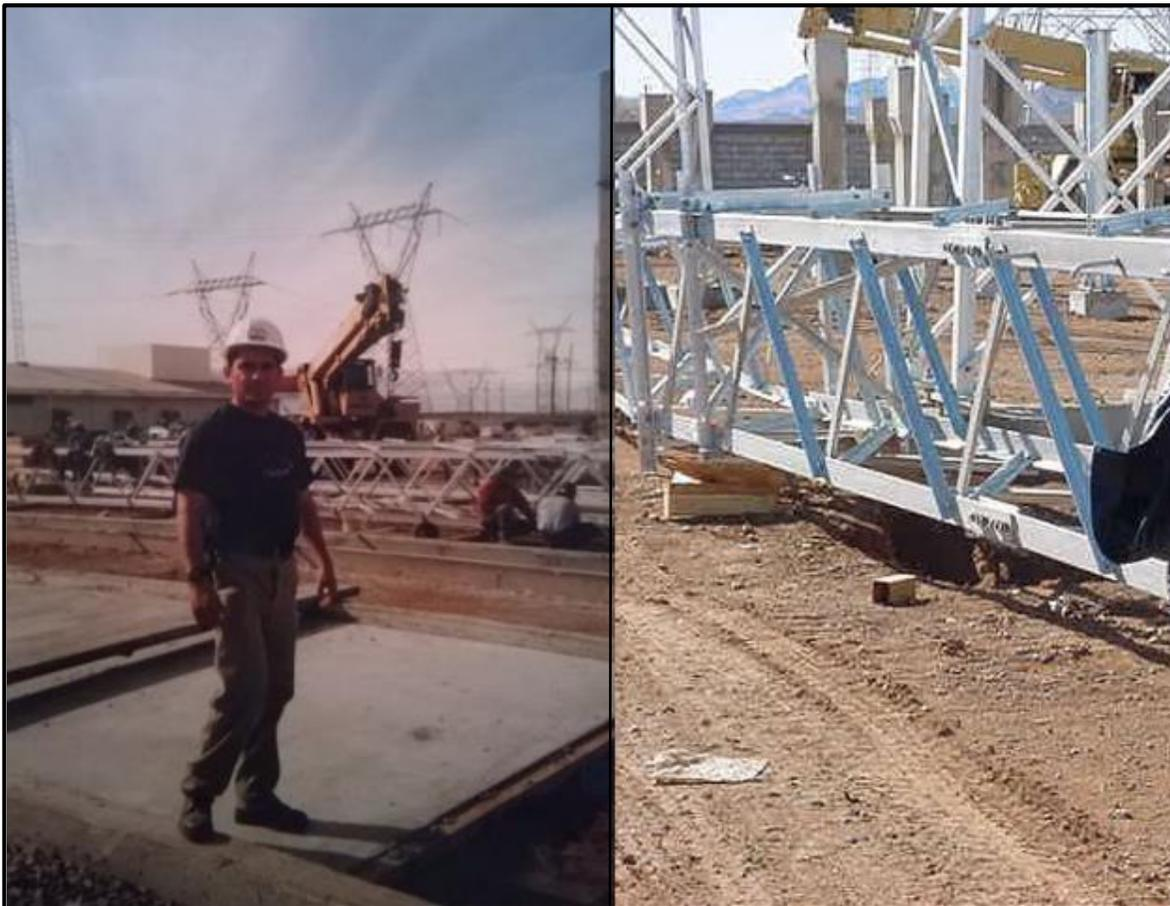
**Figura 65.** Prearmado de estructuras de acero
