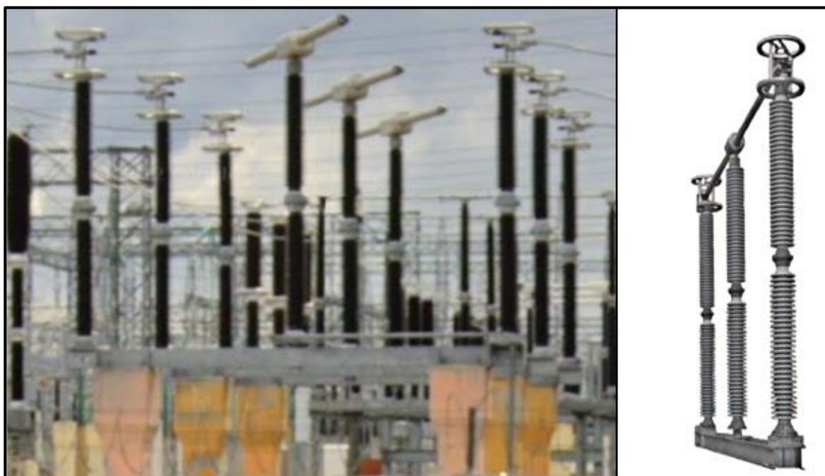
**Figura 41.** Cuchillas Desconectadoras de Doble Apertura Lateral (DAL)
