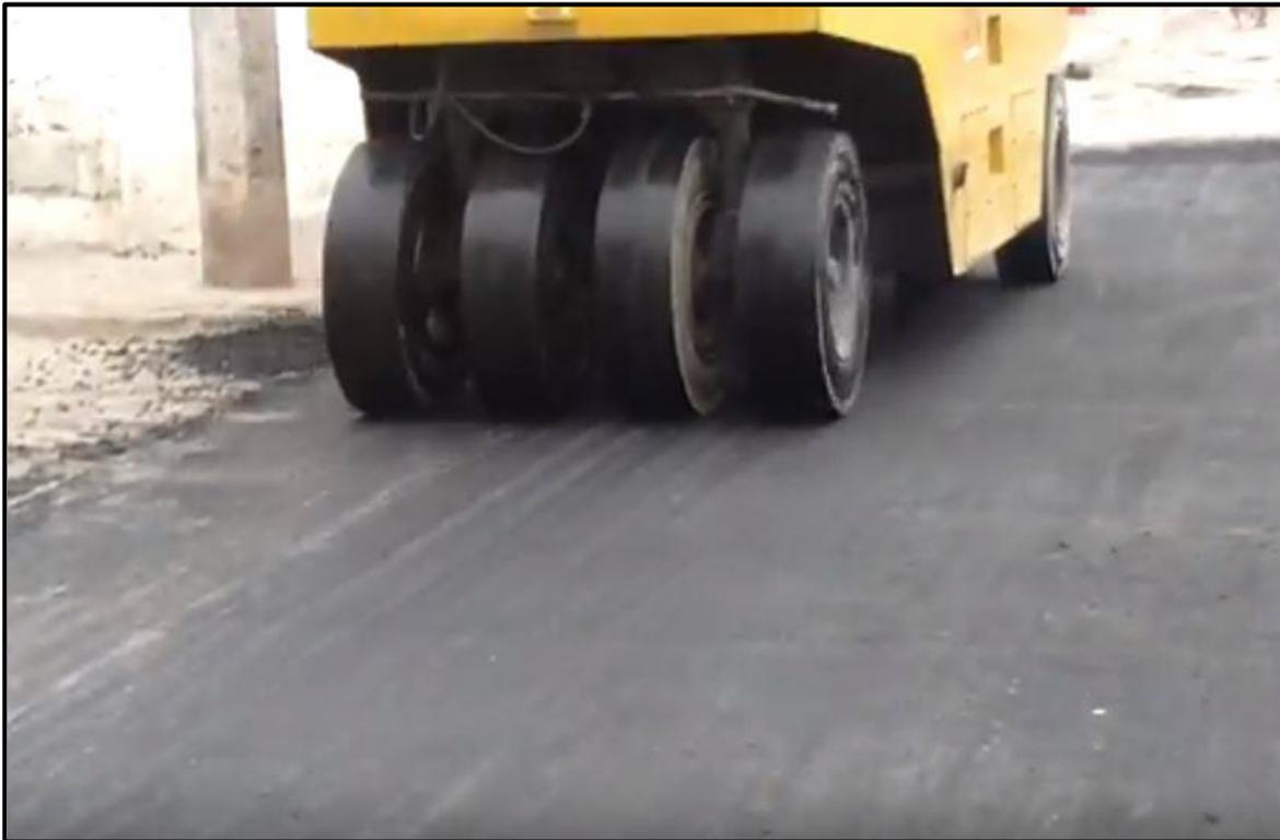
**Figura 81.** Compactación de la carpeta asfáltica
