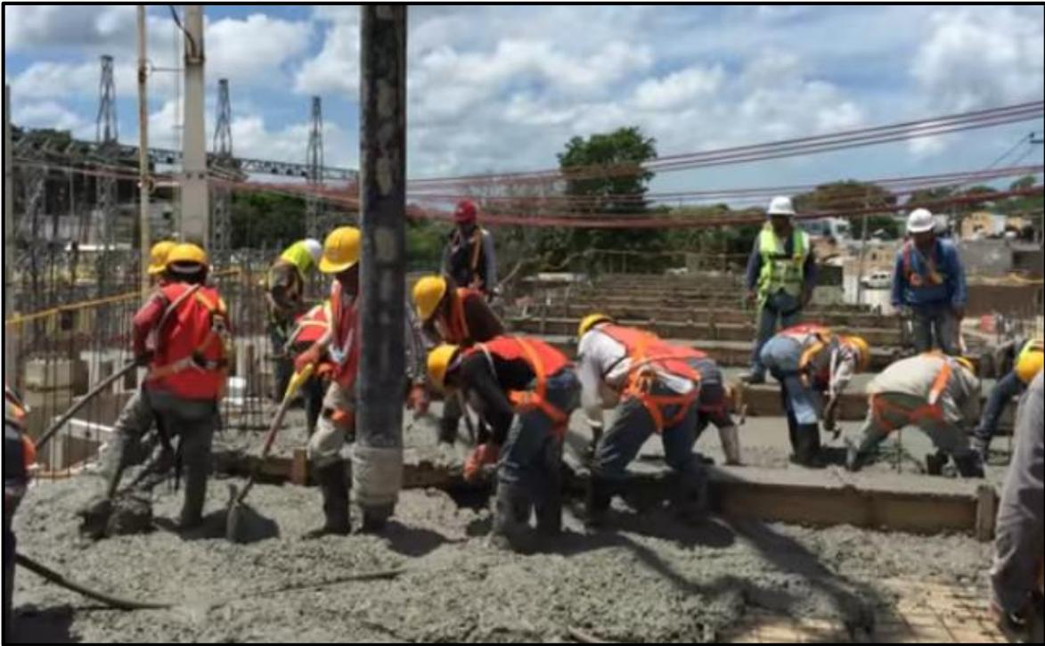
**Figura 58.** Colado de la loza de azotea del nuevo Módulo de la Caseta de Control
