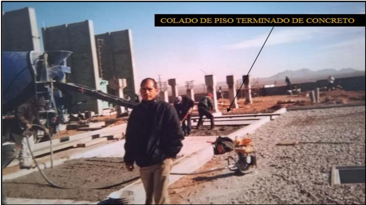
**Figura 78.** Colado de Piso Terminado de concreto
