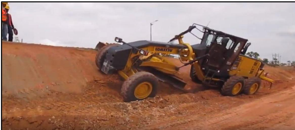
**Figura 7.** Cortes hechos con motoconformadora
