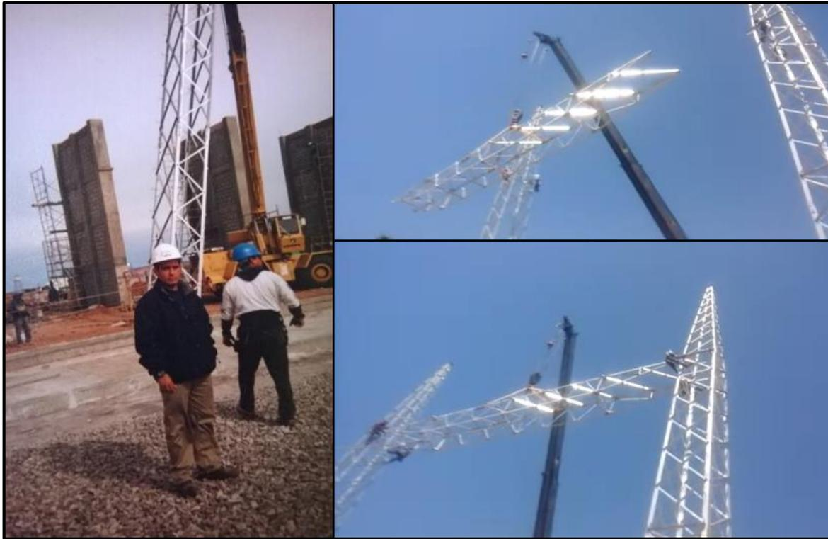
**Figura 66.** Montaje de columnas y traves de acero para Estructura Mayor
