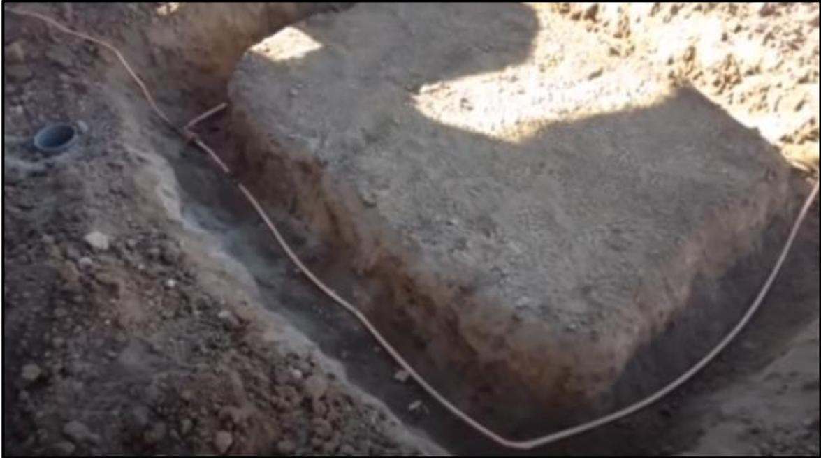
**Figura 62.** Colocación de cable de cobre desnudo de 107 mm<sup>2</sup> para la Red de Tierra
