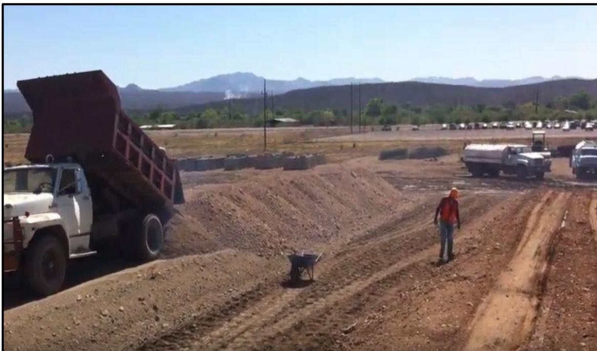
**Figura 9.** Tendido del material llevado del banco de préstamo
