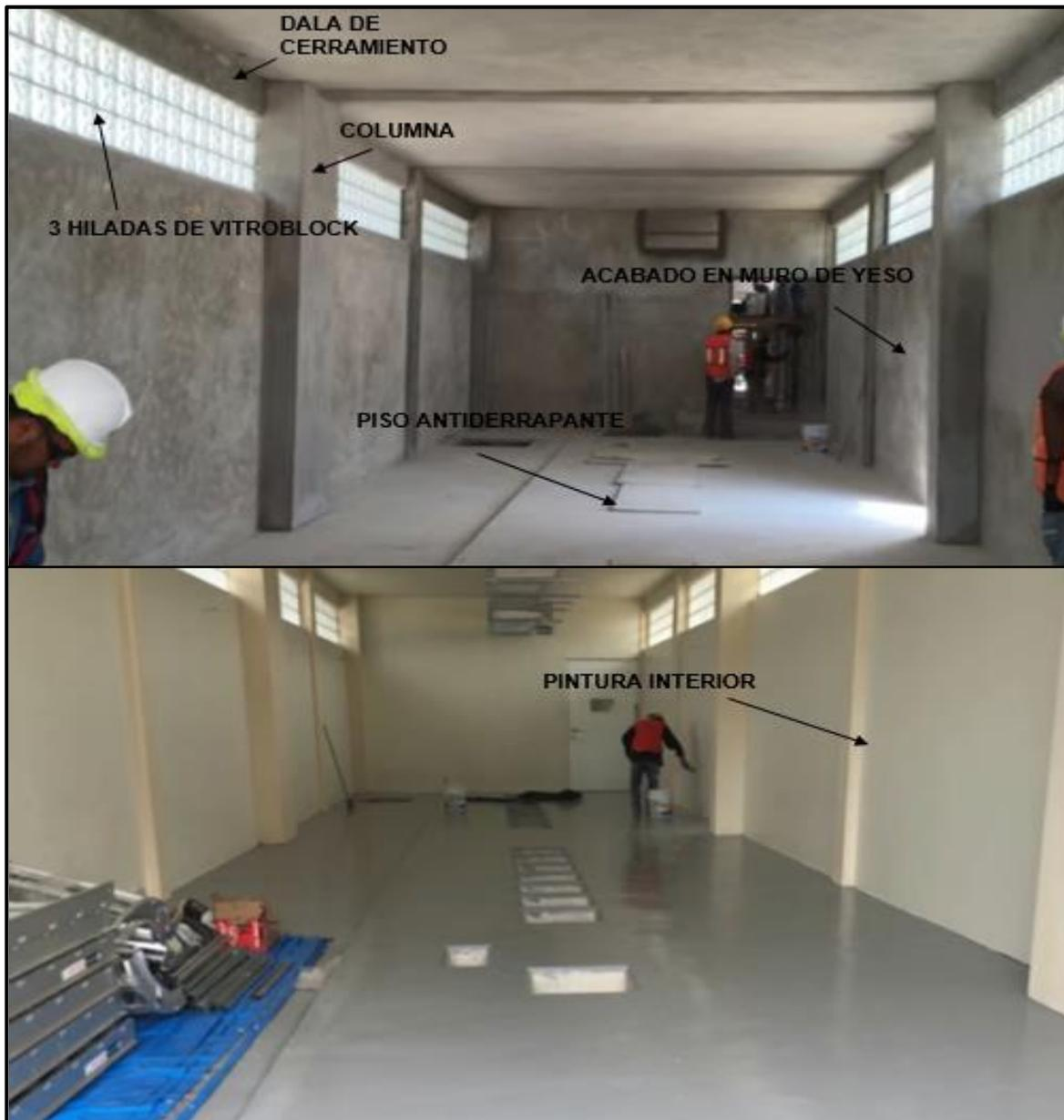
**Figura 59.** Acabados interiores nuevo Módulo Caseta de Control
