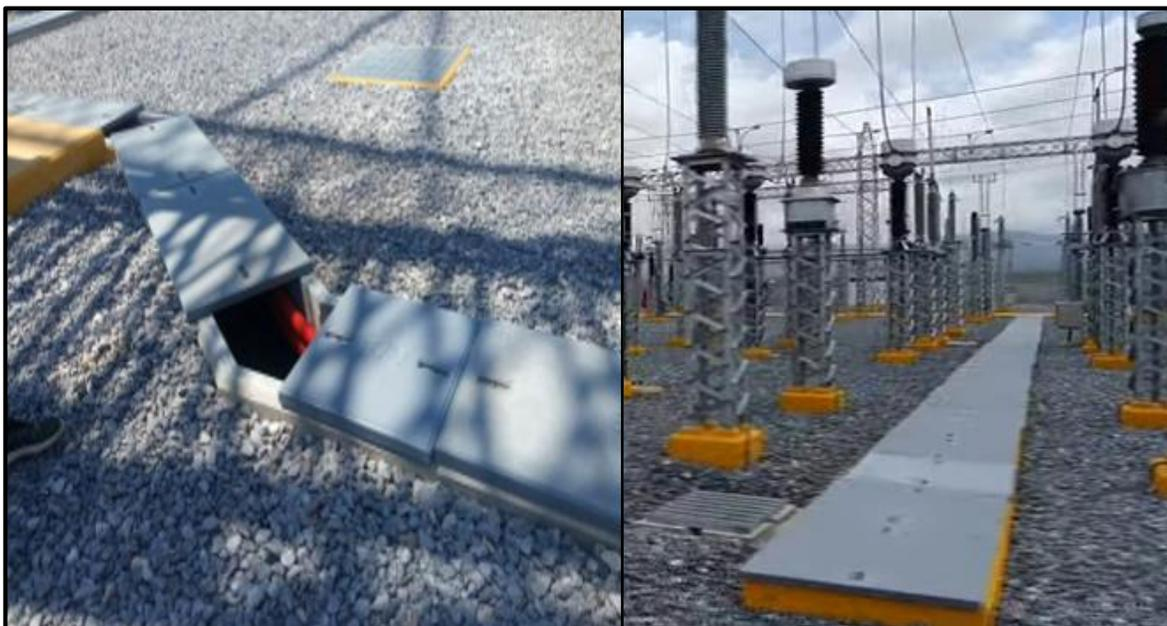
**Figura 72.** Acabado de Trincheras
