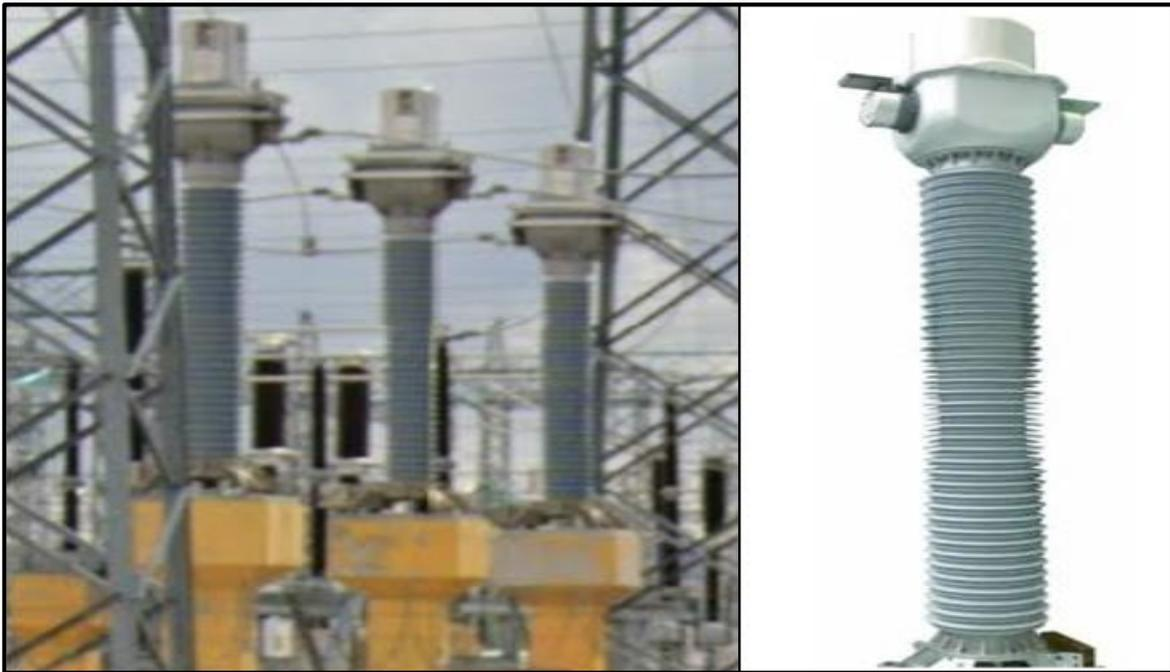
**Figura 42.** Transformadores de Corriente (TC's)
