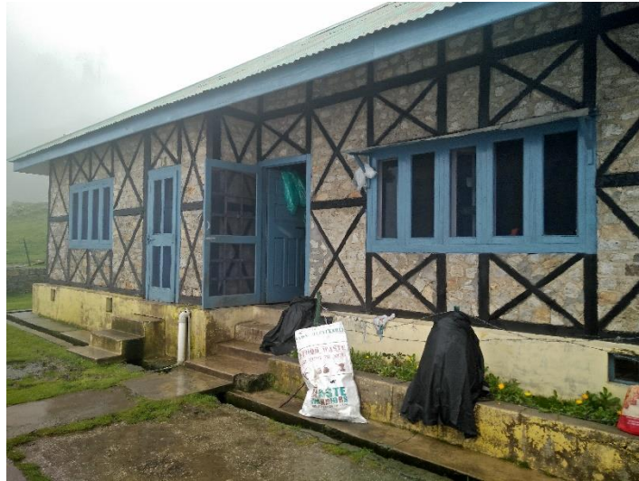
Figura 4.20 Ejemplo del sistema Dhajji Dewari (Venkataramana, 1995)
