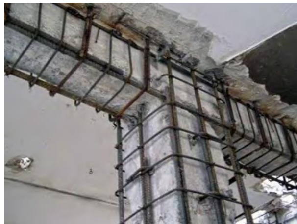
Figura 4.2 Viga encamisada con refuerzo longitudinal continuo a través del nudo con la columna (Tetta et al., 2015)
