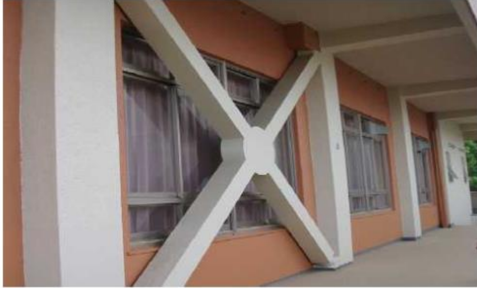
Figura 4.16 Arriostramiento de concreto prefabricado adherido a una estructura (Venkataramana, 1995)
