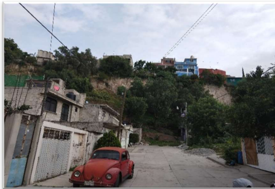
Foto 14 Zona de riesgo Col. Benito Juárez, casas en corona y pie del talud.
