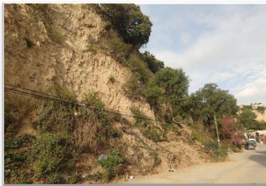
Foto 2 Talud Texalpa, vista de perfil, con la base del talud en la calle de Ruiz Cortínez.
