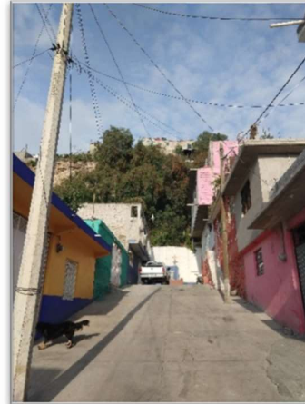
Foto 5 Vista en dirección Poniente del talud Texalpa con un muro de contención al fondo.
