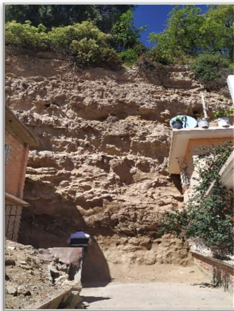
Foto 6 Cara del talud en la calle de Eucalipto
