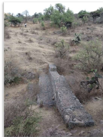
Foto 11 Presa gaviones colocadas a lo largo de la cañada.
