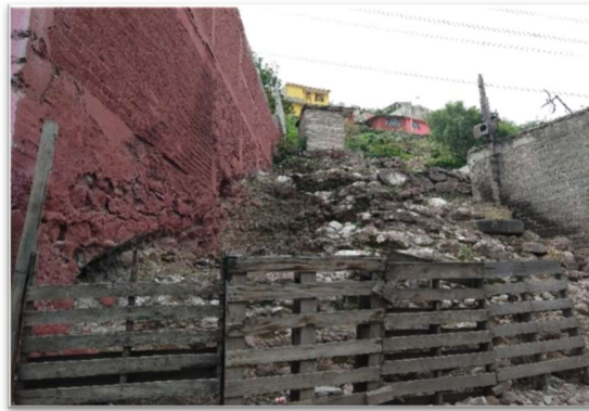
Foto 19 Cimentación de casas en zonas de antiguos flujos de roca.
