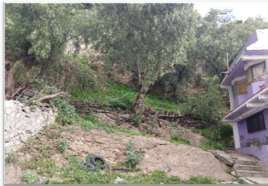
Foto 15 Vegetación en parte del cuerpo del talud.
