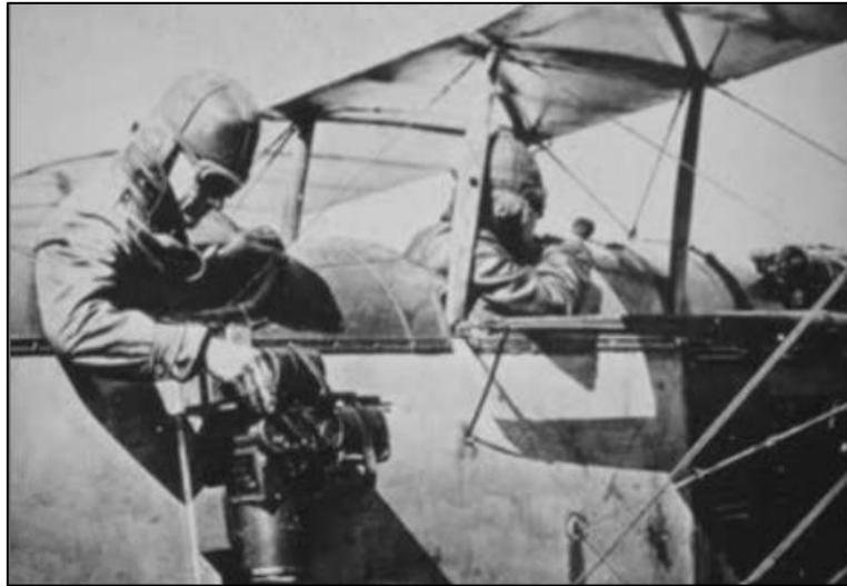
**Figura 4.** Preparación de cámara fotogramétrica montada sobre una avioneta. Fuente: Memphis Aerial Views - in Vintage Photos and Postcards (historic-memphis.com)
