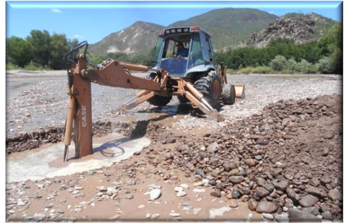
FIGURA 3.6.3 (Presa Santa Bárbara, Dgo. 2014)
