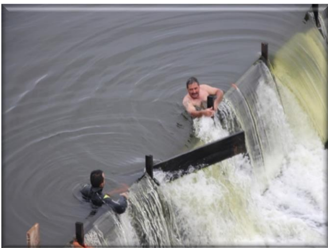
FIGURA 4.4.5.8 (CONAGUA, Presa Miguel Hidalgo, Sin., 2008)
