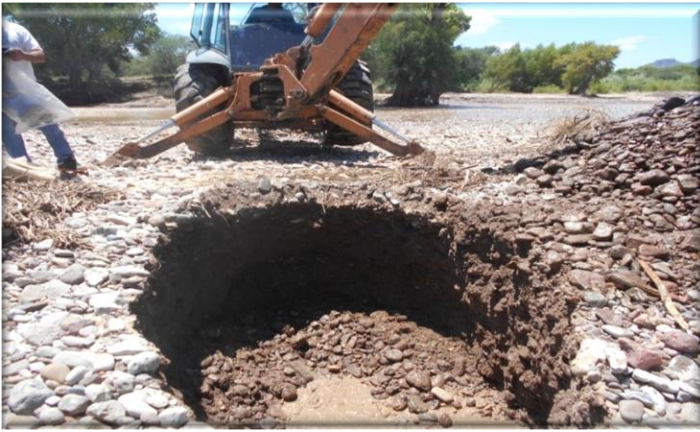
FIGURA 3.6.2 (Presa Santa Bárbara, Dgo. 2014)
