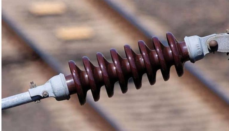
Figura 2.6 Aislador cerámico, utilizado en líneas de transmisión (UNISALIA,2012)
