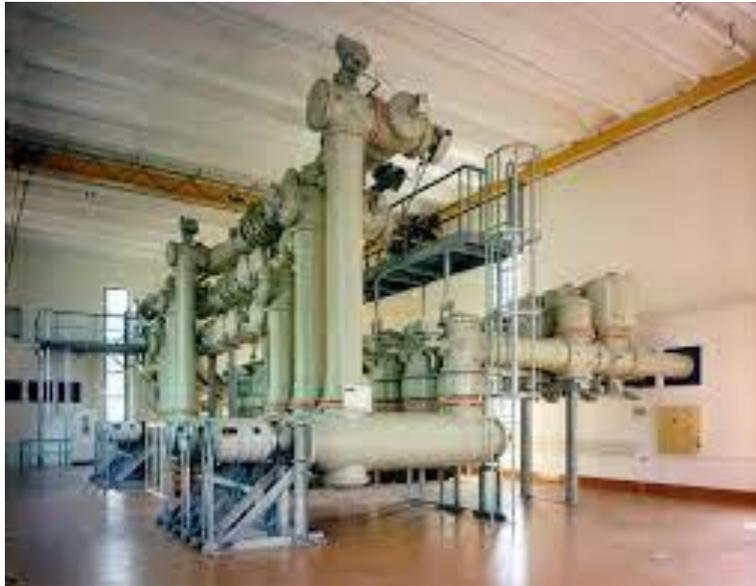
Figura 2.7. Subestación eléctrica con hexafluoruro de azufre como aislante (UNISALIA,2012)
