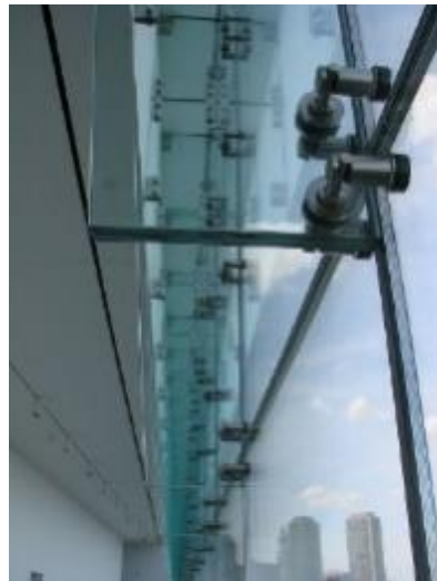
Figura 59. Fachada suspendida con costilla y conectores
