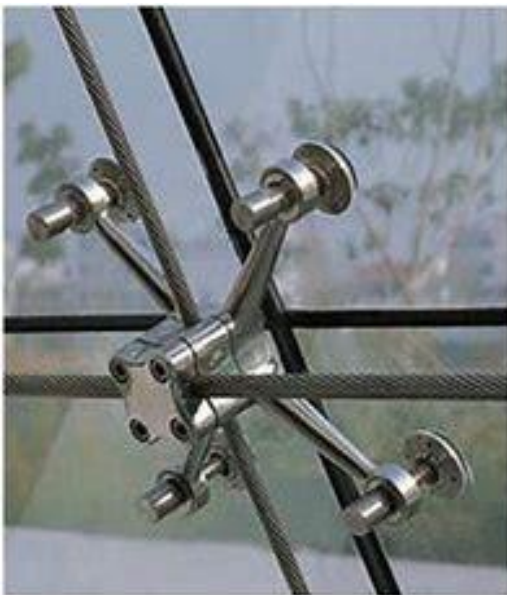
Fig. 64 Araña de 4 brazos Para tensor de acero inoxidable
