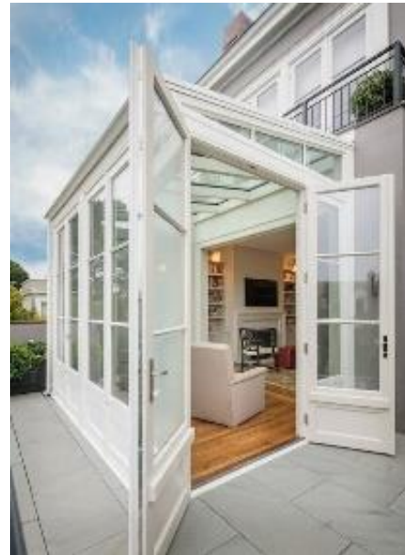
Fig. 52 Ventanas de PVC
