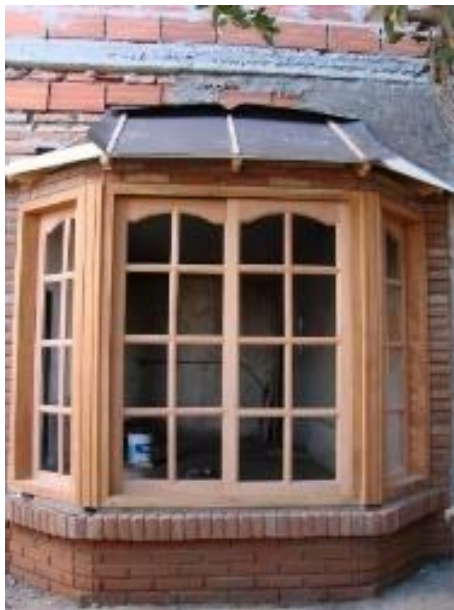
Fig 49 Ventanas de madera
