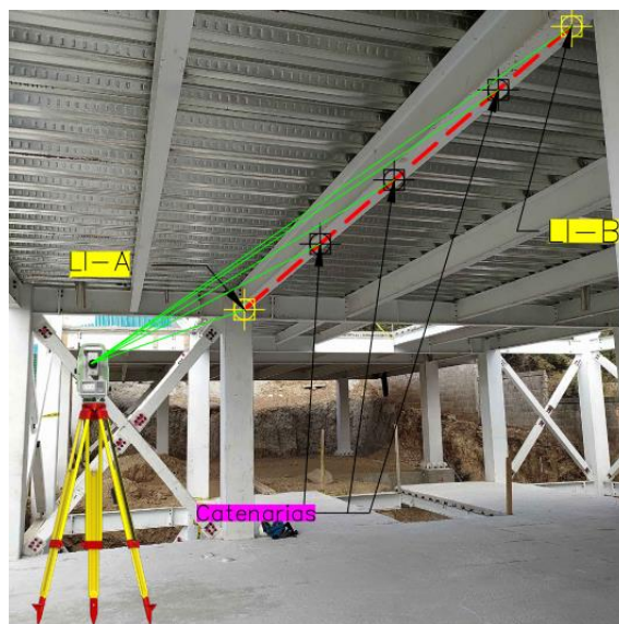
Imagen 20. Esquema del procedimiento para levantamiento de flechas
