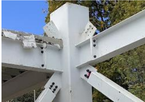
Imagen 12. Nudos rígidos como elemento estructural
