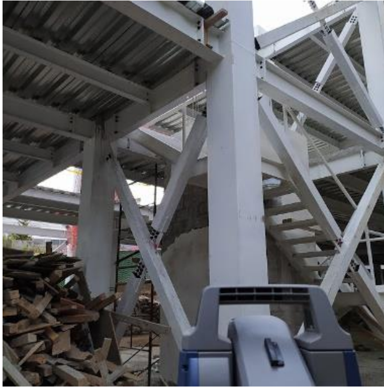
Imagen 59. Levantamiento de deflexiones de traves de cubo de escaleras y elevador de la obra
