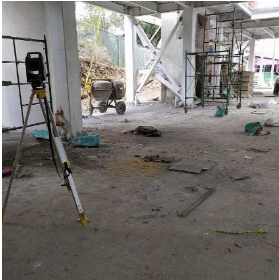
Imagen 58. Levantamiento de deflexiones de trabes en el sótano del edificio.
