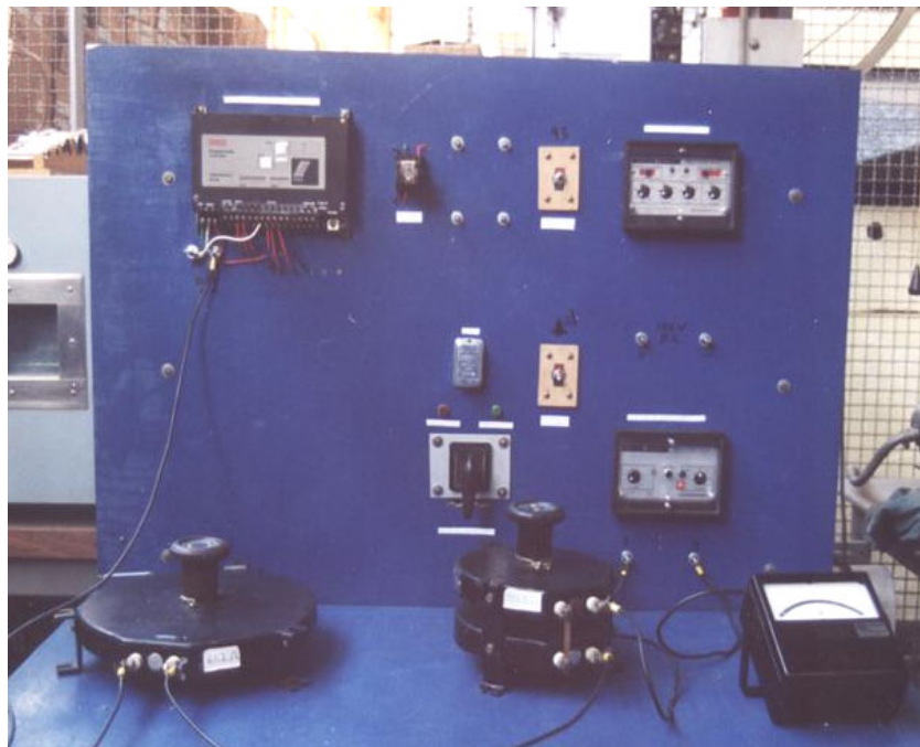
Fig. 6.2 Circuito de prueba conectado al sistema.
