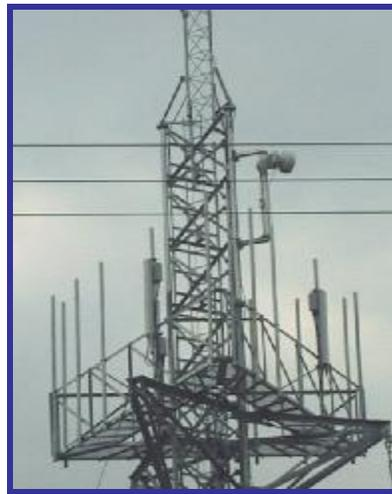
b) Montura de antenas omnidireccionales.
