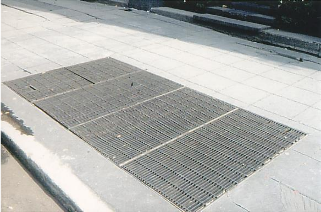
Fig 4.1 Vista exterior de una bóveda tipo sumergible.
