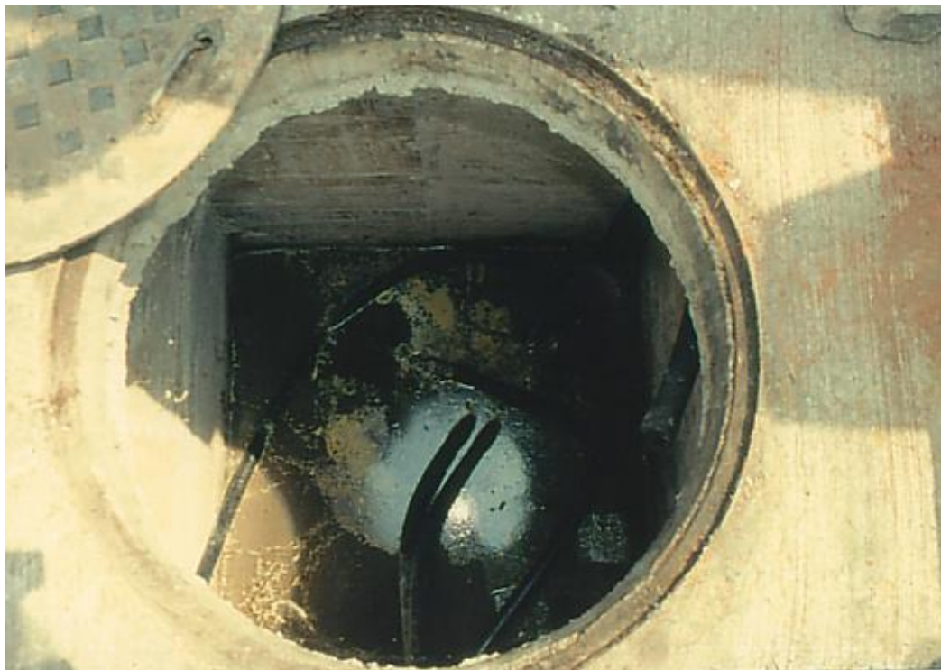
Fig 4.5 Pozo de visita
